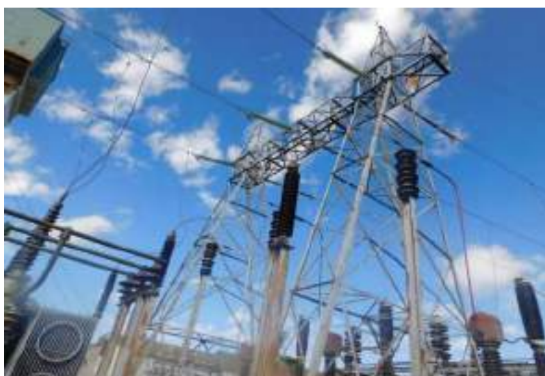
Fotografía 3-2 Pórtico de llegada de la LT 138 kV S.E. Paragsha I – Paragsha II
