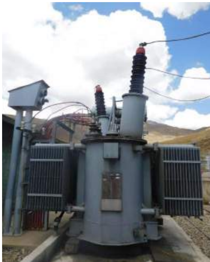
Fotografía 4-2 Transformador trifásico de potencia 6 MVA S.E. Chumpe 69/2.4 kV
