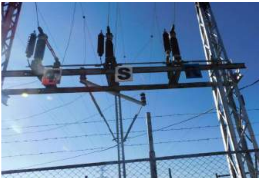
Fotografía 6-3 Seccionadores de línea de 50 kV hacia la S.E Vista Alegre
