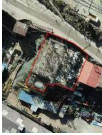
Componente = S.E. Casapalca Superficie = 505 m 2
