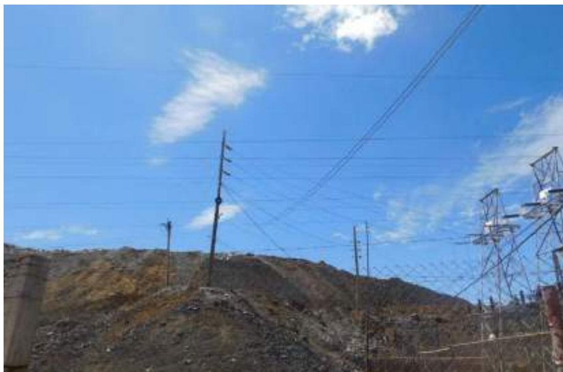
Fotografía 3-2 Pórtico de llegada de LT 50 kV simple terna a la S.E Excelsior desde la S.E Paragsha I.
