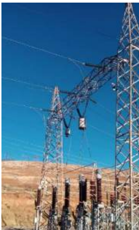
Fotografía 10-2 Pórtico de salida de la LT 138 kV desde S.E. Oroya Nueva – S.E. Caripa
