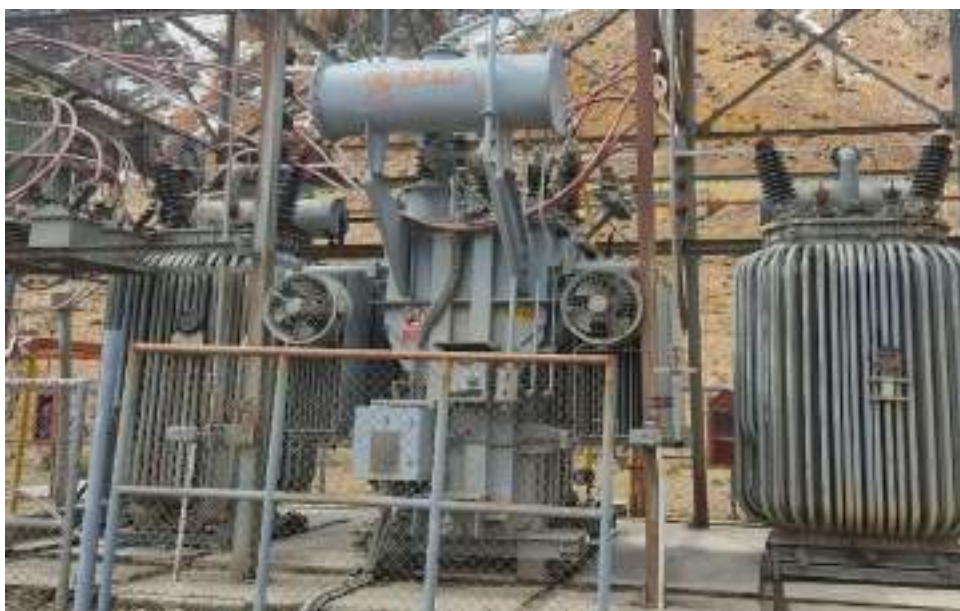
Fotografía 6-2 Transformador trifásico de potencia 3.75 MVA S.E. San Cristóbal 47.5/2.4 kV
