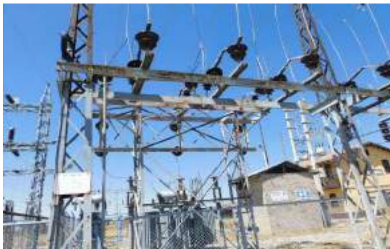
Fotografía 6-4 Seccionadores de línea de LT 50 kV de S.E Shelby hacia S.E. Carhuamayo
