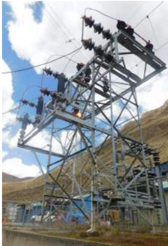
Fotografía 4-4 Interruptor de potencia en 69 kV
