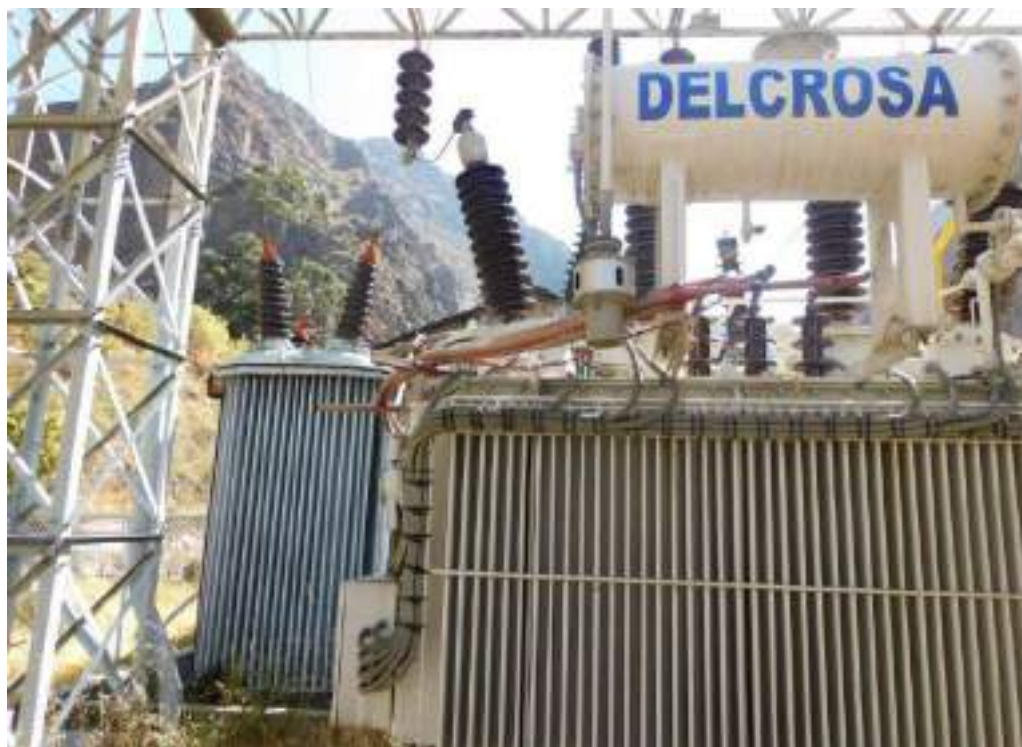
Fotografía 4-2 Transformador trifásico de potencia 1.5 MVA S.E. San Mateo 50/4.16 kV
