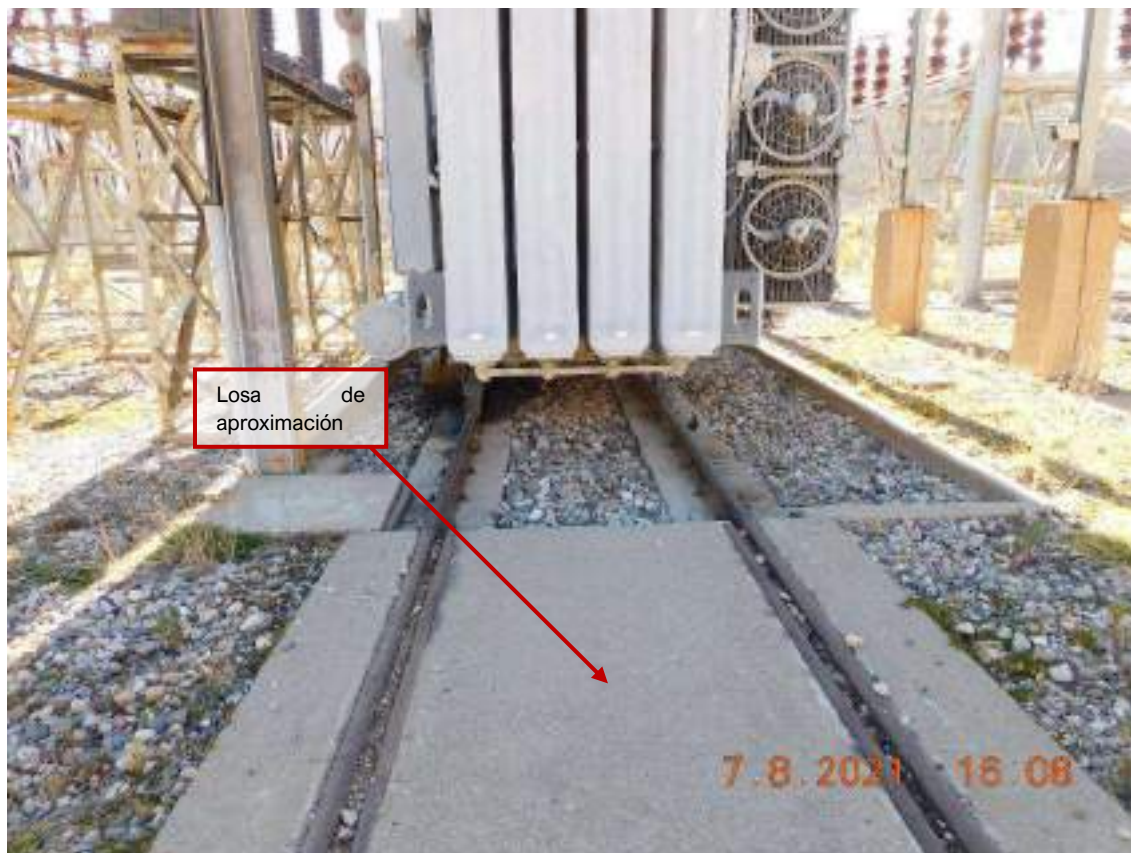
Fotografía 3.3-117 Vista de Losa de aproximación
