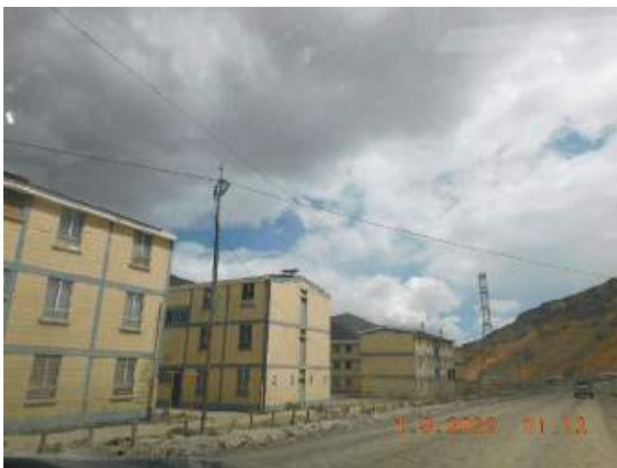
Fotografía 42: Campamento minero "San Cristóbal", el cual fue identificado previamente como poblado; sin embargo, de acuerdo con la evaluación en campo, se corroboró que se trataba de un campamento perteneciente a la Unidad Minera Carahuacra perteneciente a la empresa VOLCAN S.A.
