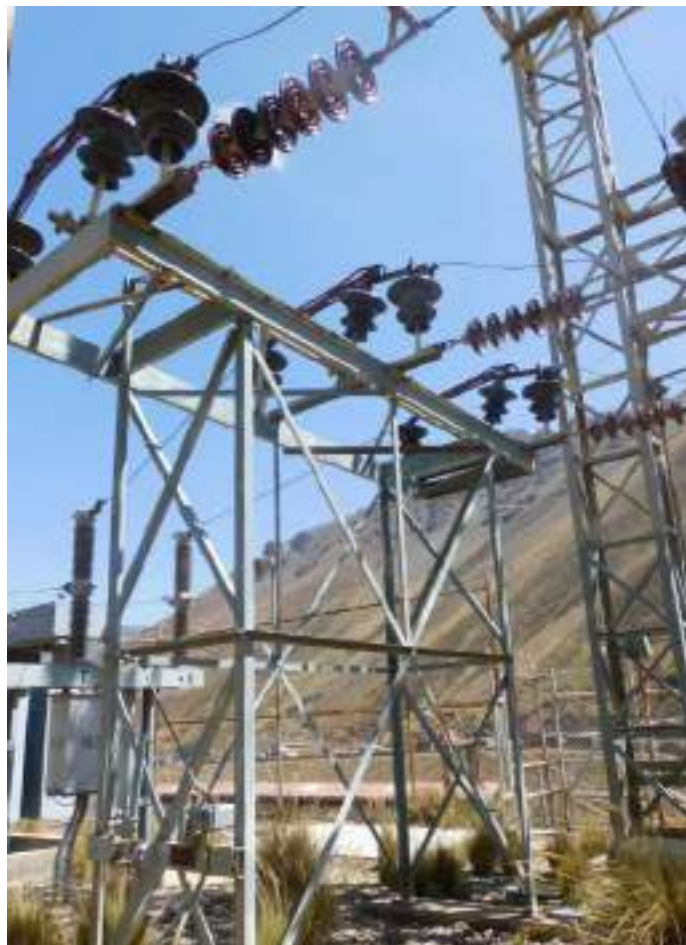
Fotografía 3-5 Interruptor de potencia de 50 kV
