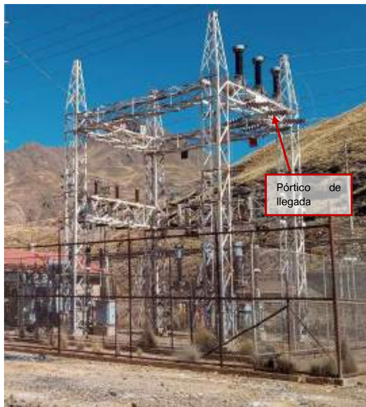
Fotografía 3.3-144 Vista de Pórtico de Llegada
