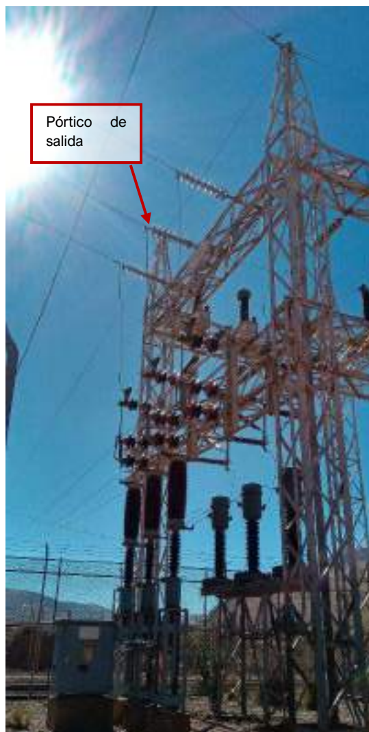
Fotografía 3.3-145 Vista de Pórtico de salida
