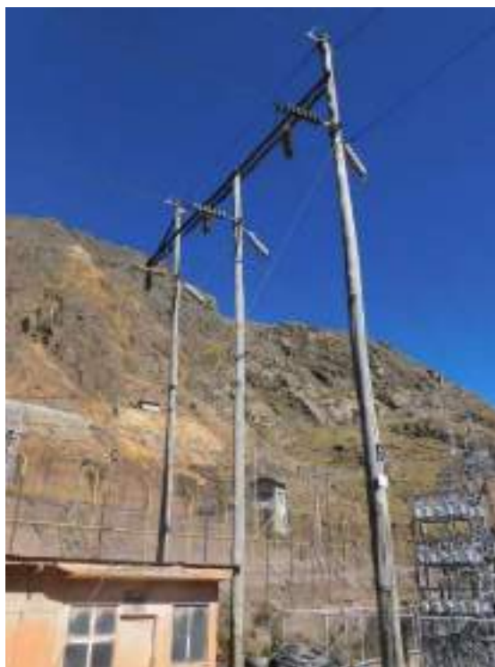
Fotografía 3-2 Pórtico de llegada de LT 50 kV a la S.E. Andaychagua proveniente de S.E. Andaychagua ELC.
