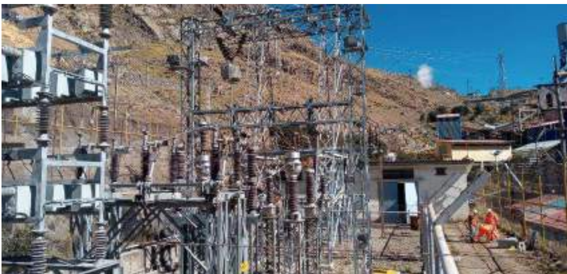
Fotografía 3.3-168 Vista actual 2 del componente
