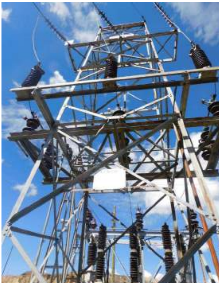
Fotografía 5-8 Juegos de seccionadores de barra con conexión a tierra en 50 kV.
