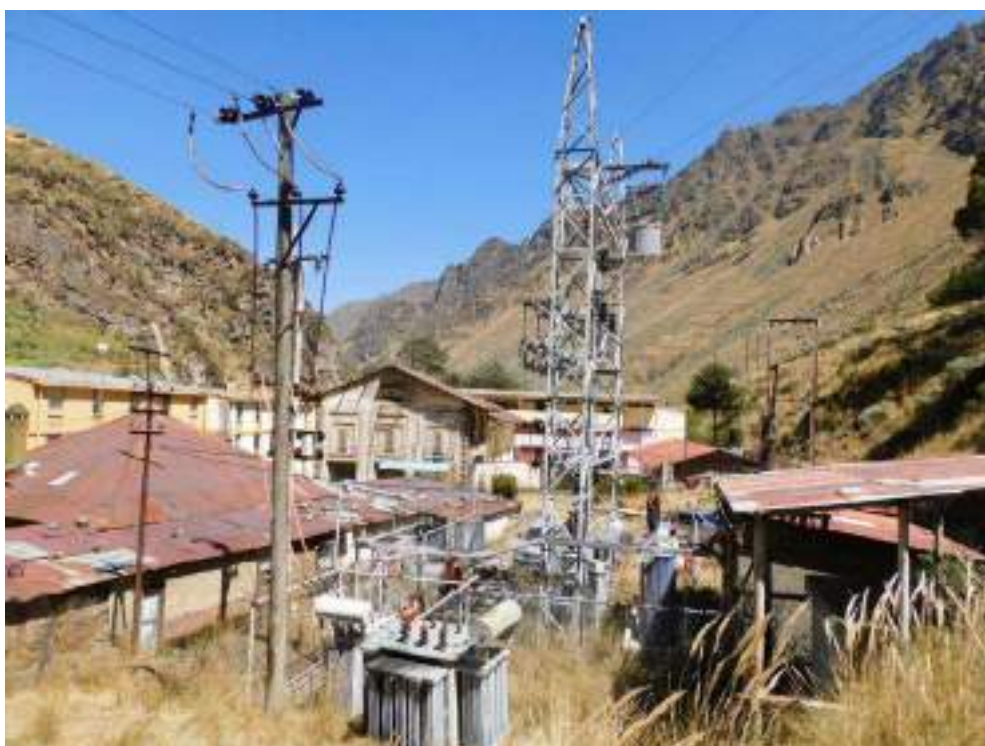
Fotografía 3.3-223 Vista actual 2 del componente
