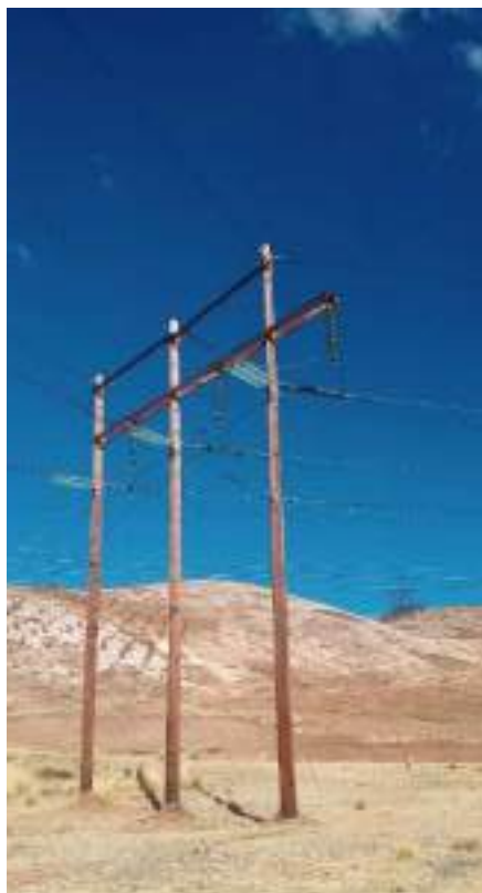
Fotografía 10-2 Pórtico de salida de la LT 138 kV desde S.E. Oroya Nueva – S.E. Caripa
