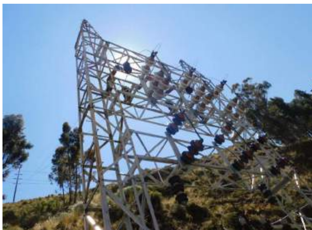
Fotografía 5-2 Seccionador de línea de potencia en 72.5 kV
