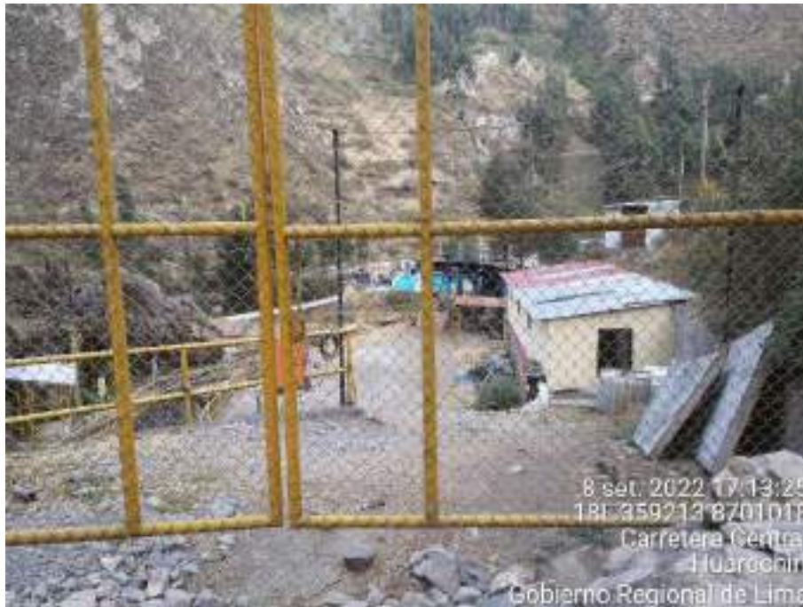
Fotografía 4: Punto de acceso al punto identificado en etapa de gabinete como Graton Túnel. Debido a la presencia de un cercado no se pudo acceder al área, aunque por fuentes primarias se pudo conocer que no hay población próxima.
