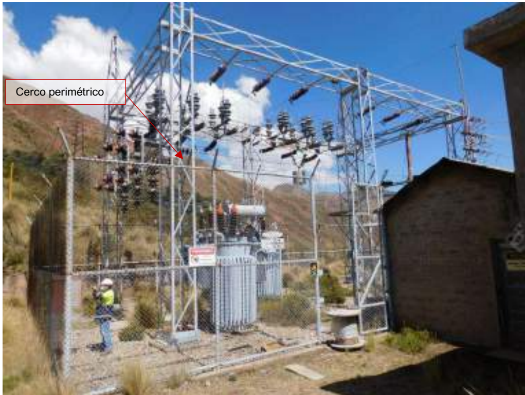
Fotografía 3.3-308 Vista de Cerco Perimétrico
