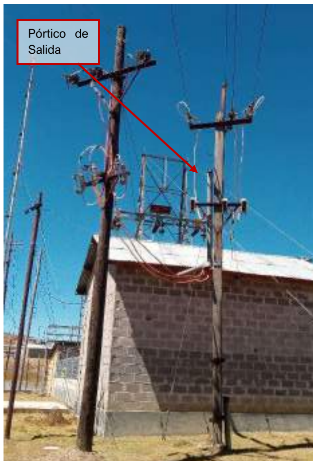
Fotografía 3.3-51 Vista de Pórtico de salida
