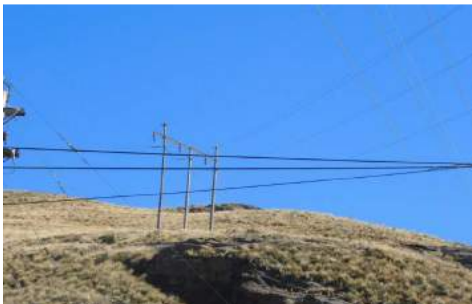
Fotografía 4-2 LT 50 kV simple terna saliendo desde la S.E. Mahr Túnel hacia la S.E. Concentradora Carahuacra
