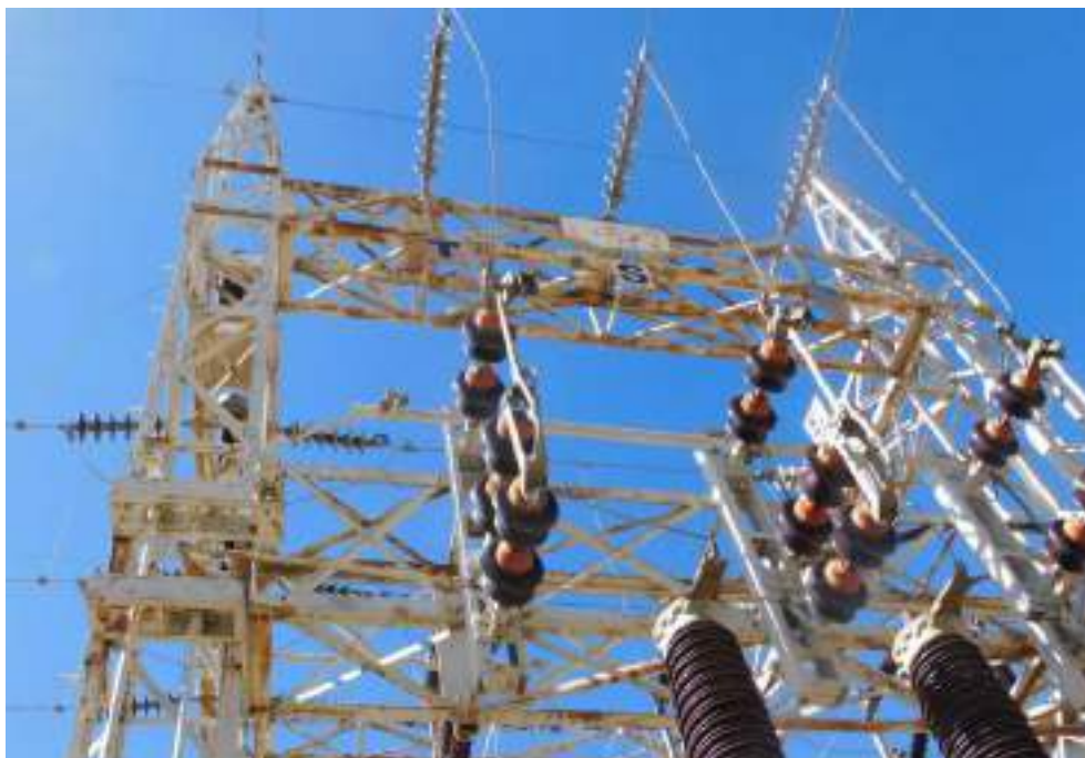
Fotografía 5-4 Transformadores de corriente en la S.E Mahr Túnel
