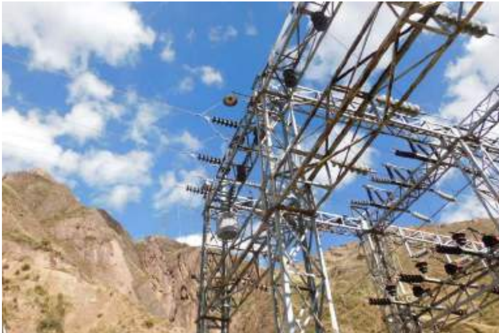
Fotografía 3-2 Torre terminal LT 50 kV desde S.E. Antuquito hacia S.E Carlos Francisco
