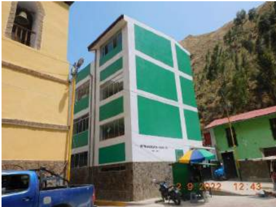
Fotografía 45: Institución Educativa N° 20681 – Alis, perteneciente a la UGEL N° 13 Yauyos, ubicado en el distrito de Alis.
