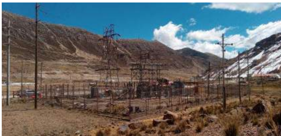
Fotografía 3.3-147 Vista actual 1 del componente
