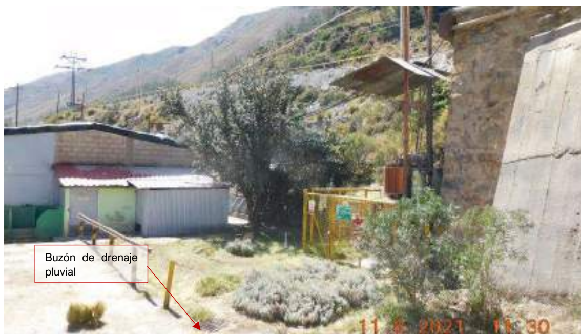
Fotografía 3.3-293 Vista de Canal exterior de drenaje pluvial.
