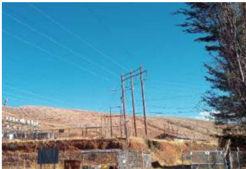
Fotografía 9-2 LT 50 kV de salida desde C.H. Oroya Nueva hacia la S.E. Alambrón.
