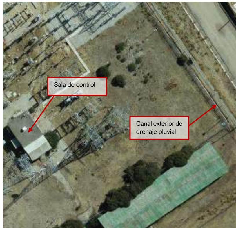
Fotografía 3.3-105 Vistas de Canal exterior de drenaje pluvial
