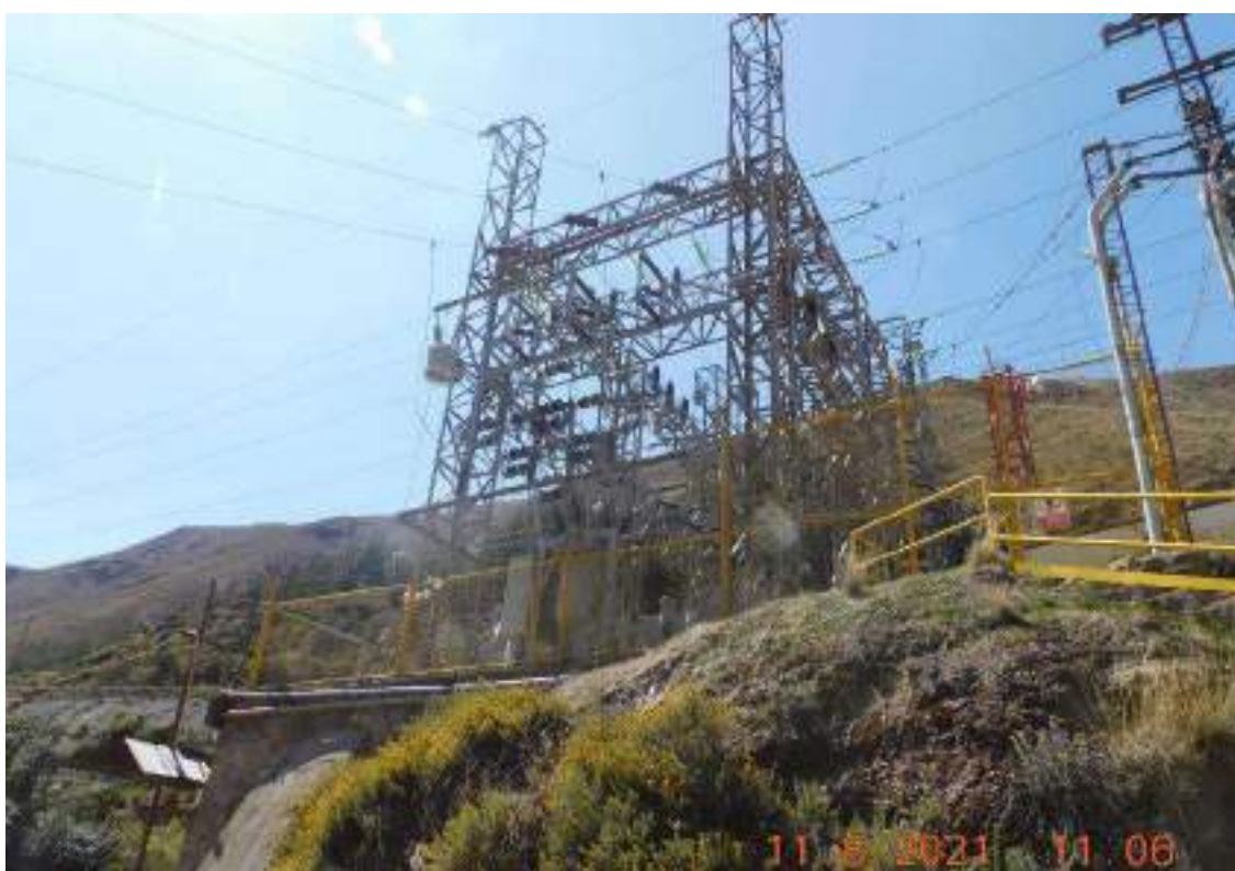
Fotografía 3.3-257 Vista actual 2 del componente
