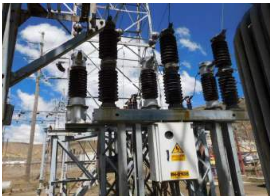
Fotografía 6-4 Interruptor de potencia 72.5 kV en SF6
