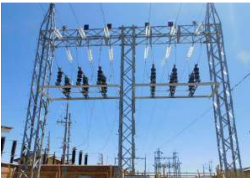
Fotografía 6-4 Seccionadores de línea de LT 50 kV de S.E Shelby hacia S.E. Carhuamayo
