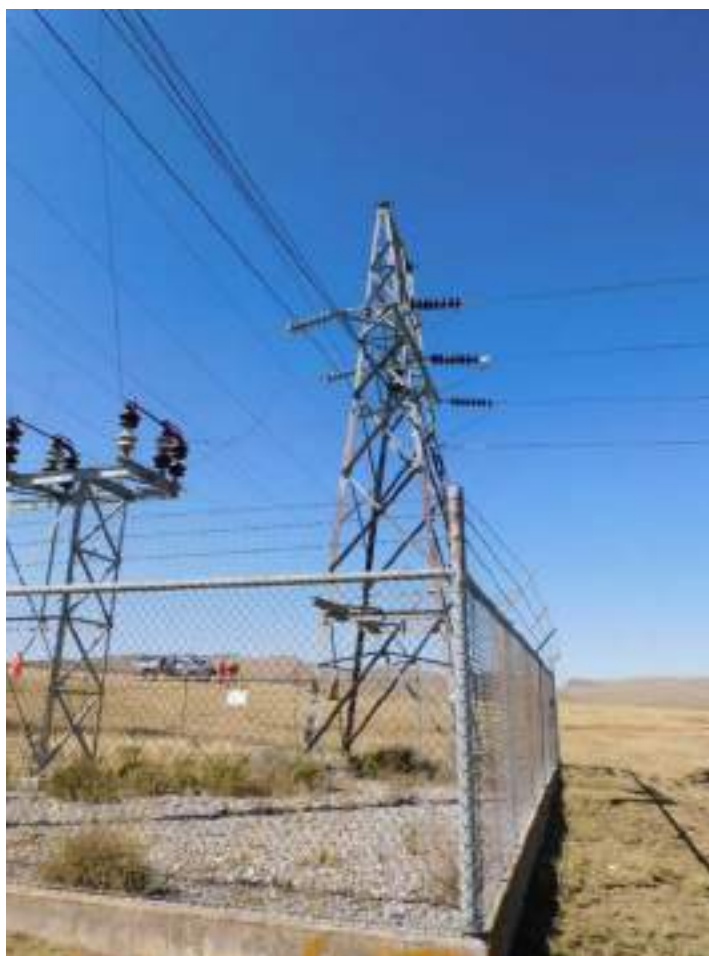
Fotografía 5-2 Pórtico de salida de LT 50 kV simple terna de la S.E Vista Alegre hacia la S.E. San Juan.
