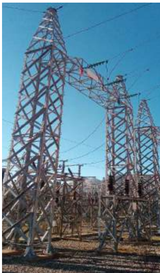
Fotografía 4-1 Pórtico de salida de LT 50 kV desde C.H Oroya Nueva hacia S.E. Curipata.
