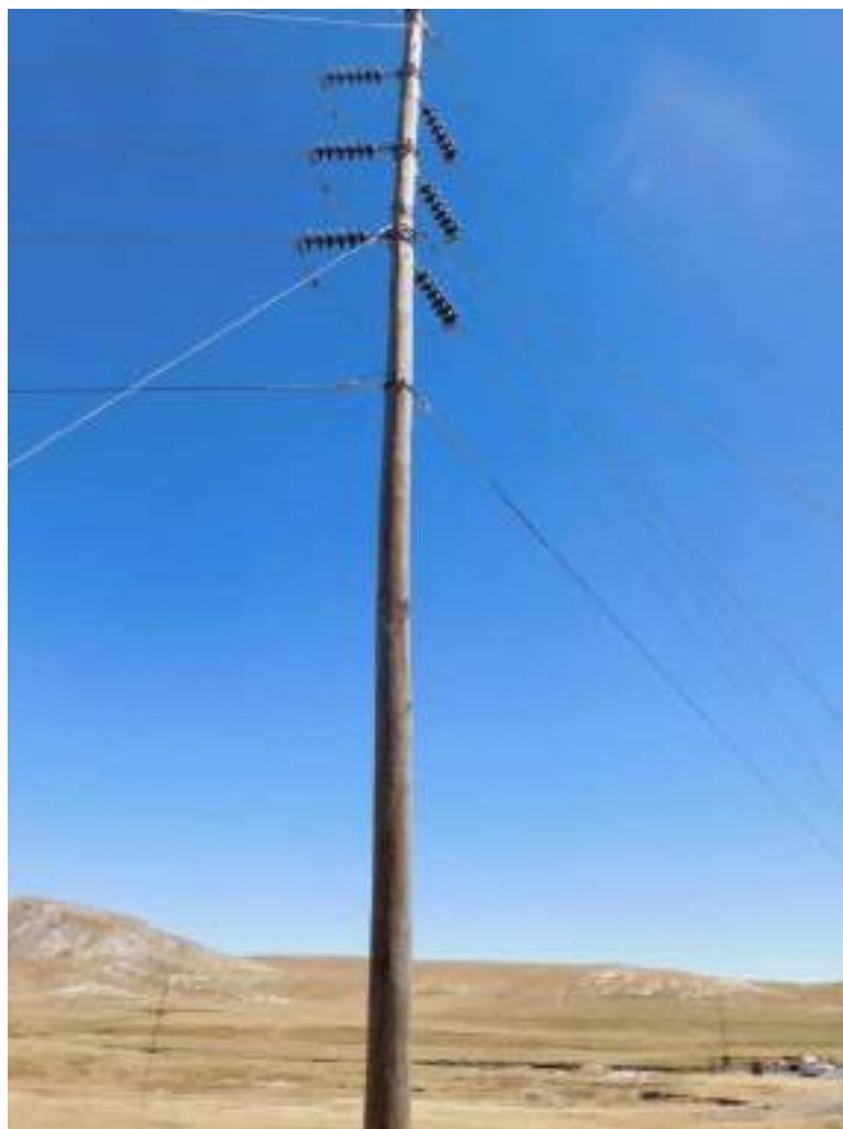
Fotografía 3-2 Poste de anclaje de salida de LT 50 kV simple terna de la S.E San Juan hacia la S.E. Vista Alegre.
