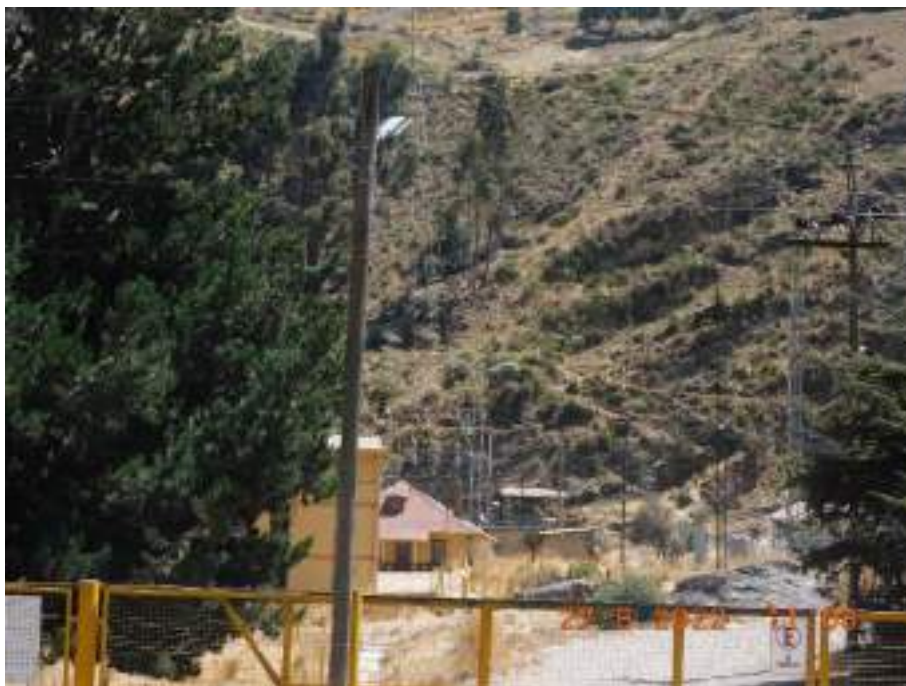
Fotografía 5: Vista general del Campamento Minero Bellavista, perteneciente a la UM Quenuales, ubicado en el distrito de Chicla, provincia de Huarochirí. Dentro de sus instalaciones se encuentra la SE San Mateo, la cual es parte de la zona STE Centro 15.
