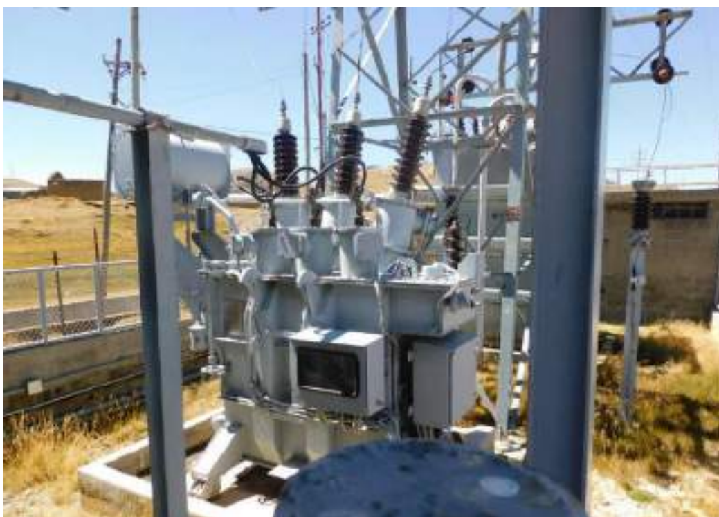
Fotografía 4-3 Transformador trifásico de potencia 2 MVA, S.E. San Juan de 50/2.4 kV.
