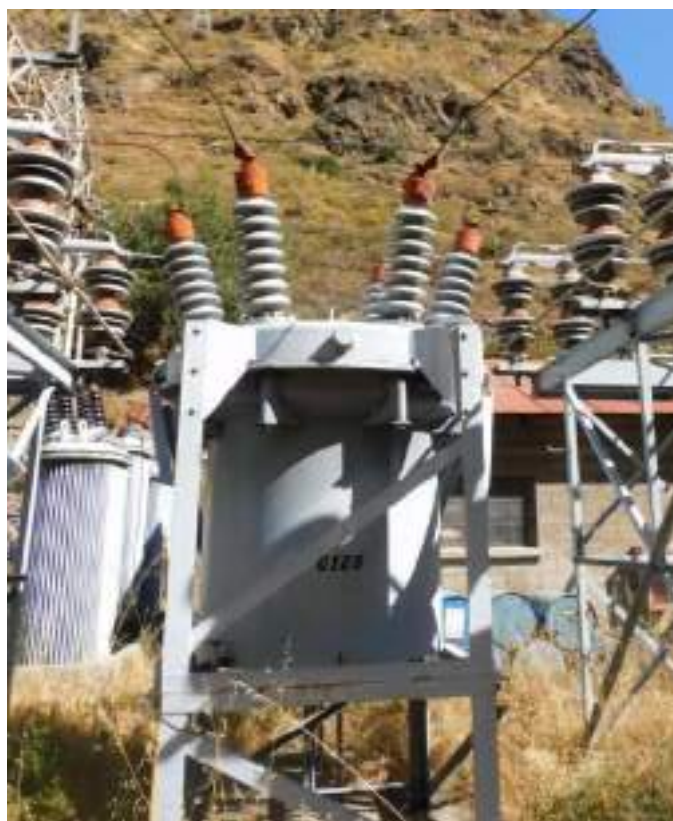
Fotografía 4-4 Interruptor de potencia en 72.5 kV
