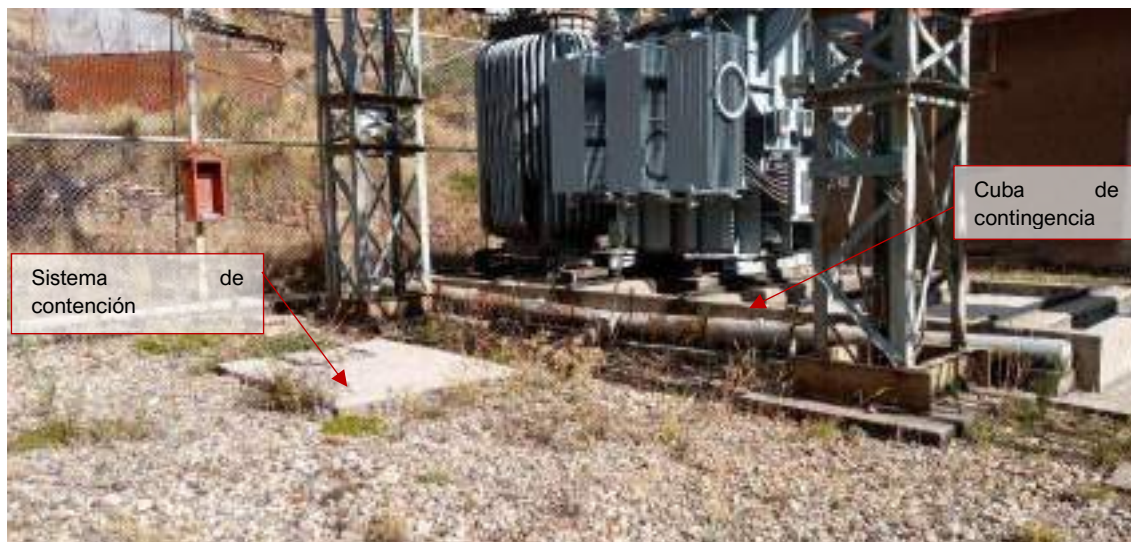
Fotografía 3.3-241 Vista del Sistema de contención
