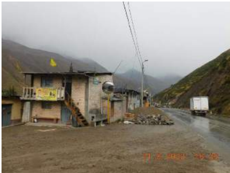
Fotografía 25: Barrio Unión Progreso Embarcadero ubicado a menos de 300 m de la zona STE Centro 19 (SE Casapalca Norte). Se aprecian viviendas construidas con ladrillo y cemento, aunque en su mayoría están construidas con tapia o adobe, además de techos de calamina.
