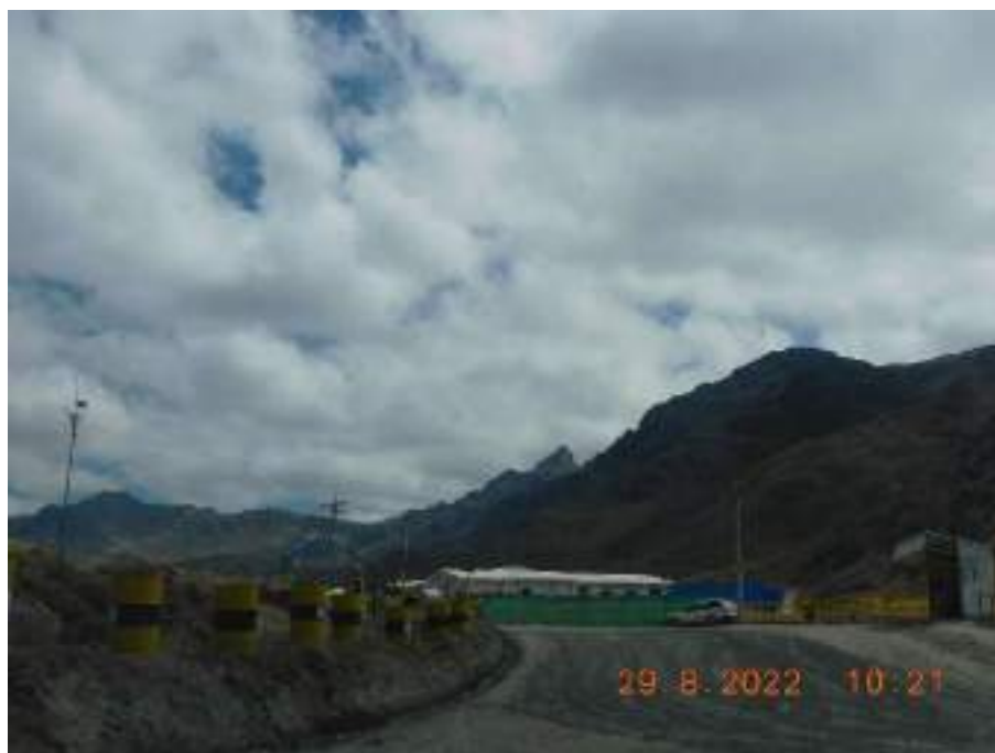
Fotografía 45: Vista general de la Unidad Minera Andaychagua, perteneciente a la empresa VOLCAN S.A.
