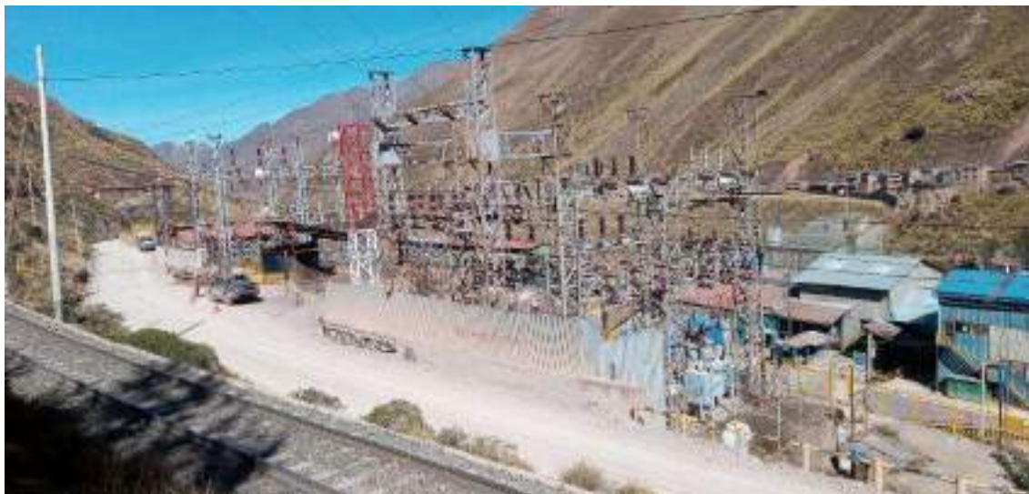
Fotografía 3.3-256 Vista actual 1 del componente
