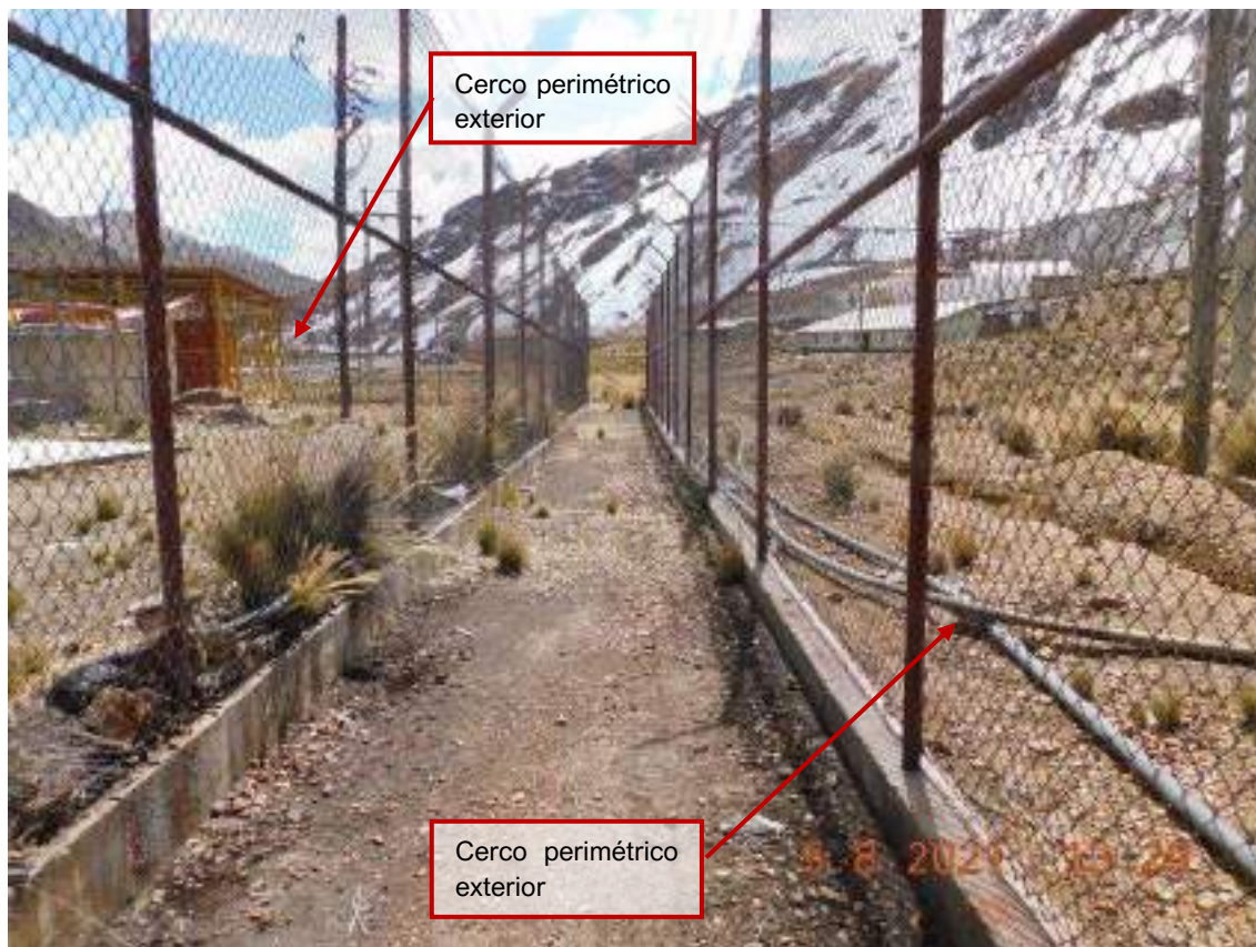
Fotografía 3.3-166 Vista de Cerco Perimétrico
