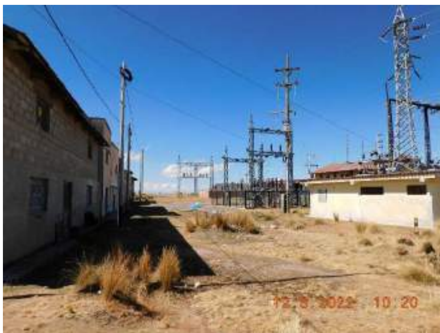
Fotografía 28: Se puede visualizar viviendas del CP Shelby que se encuentran a una distancia aproximada de 10 metros de la zona PAD STE Centro 7 (SE Shelby). Algunas de estas viviendas tienen como material de construcción predominante bloques de cemento o material noble, con techos de calamina.
