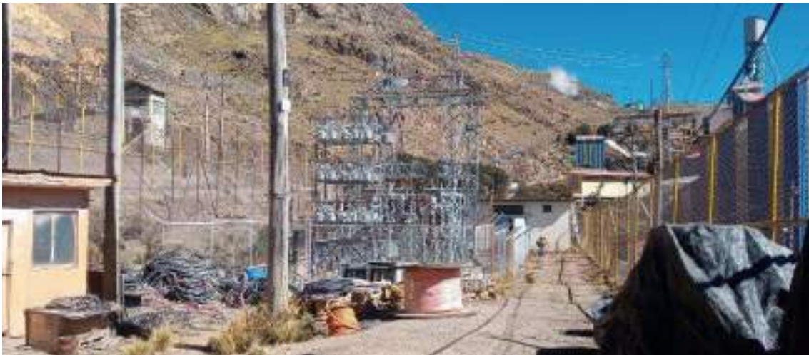
Fotografía 3.3-167 Vista actual 1 del componente
