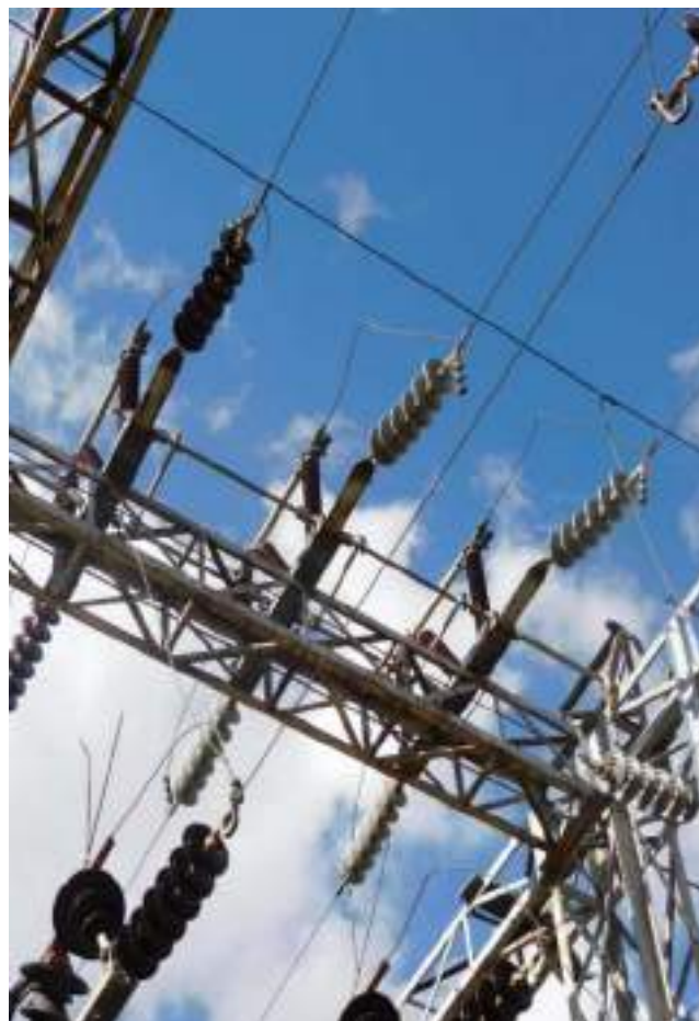
Fotografía 5-3 Seccionador de línea en 72.5 kV
