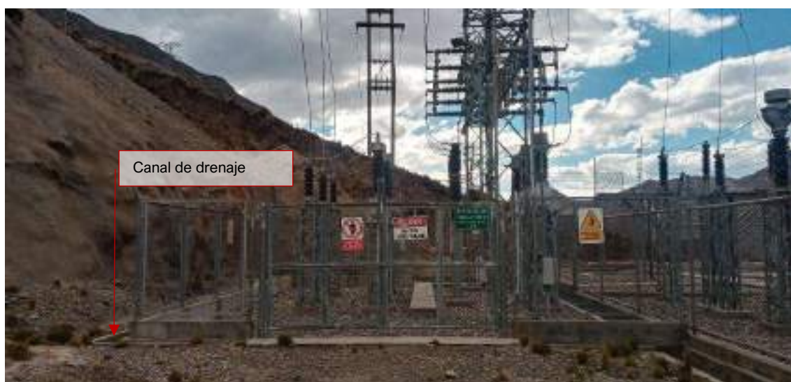
Fotografía 3.3-195 Vista de Canal exterior de drenaje pluvial.
