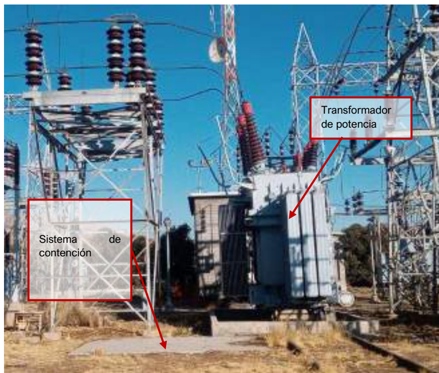
Fotografía 3.3-95 Vista del Buzón para recuperación de aceite.
