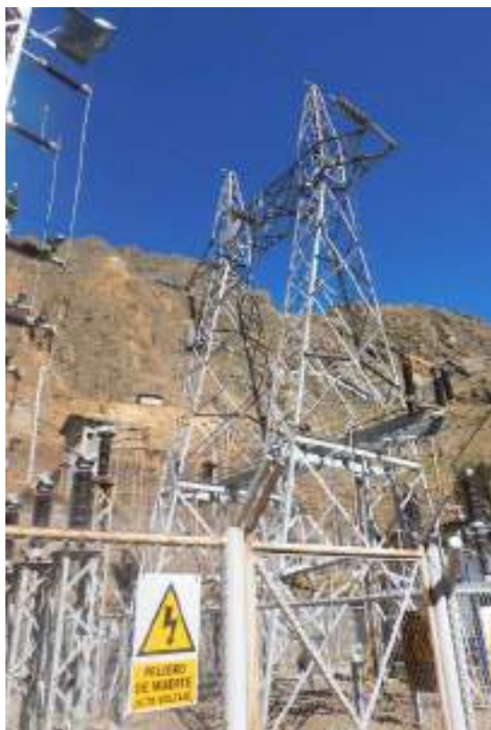
Fotografía 3-2 Pórtico de llegada de LT 50 kV a la S.E. Andaychagua proveniente de S.E. Andaychagua ELC.
