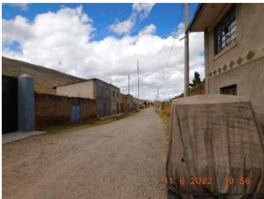
Fotografía 5: También se observó, en el Barrio Chivian, la presencia de calles afirmadas; así como viviendas construidas con materiales como adobe o tapia.
