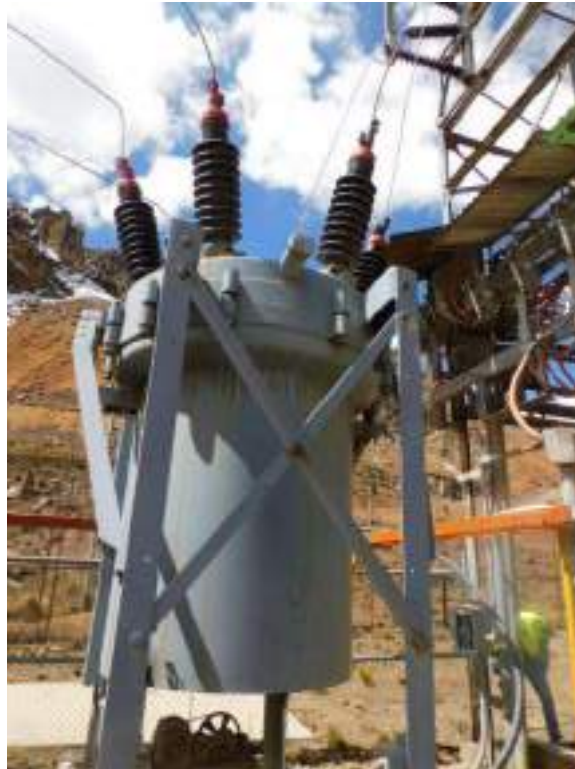
Fotografía 3.3-155 Vista de Interruptor de potencia 72.5 kV en aceite
