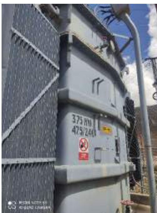
Fotografía 6-2 Transformador trifásico de potencia 3.75 MVA S.E. San Cristóbal 47.5/2.4 kV
