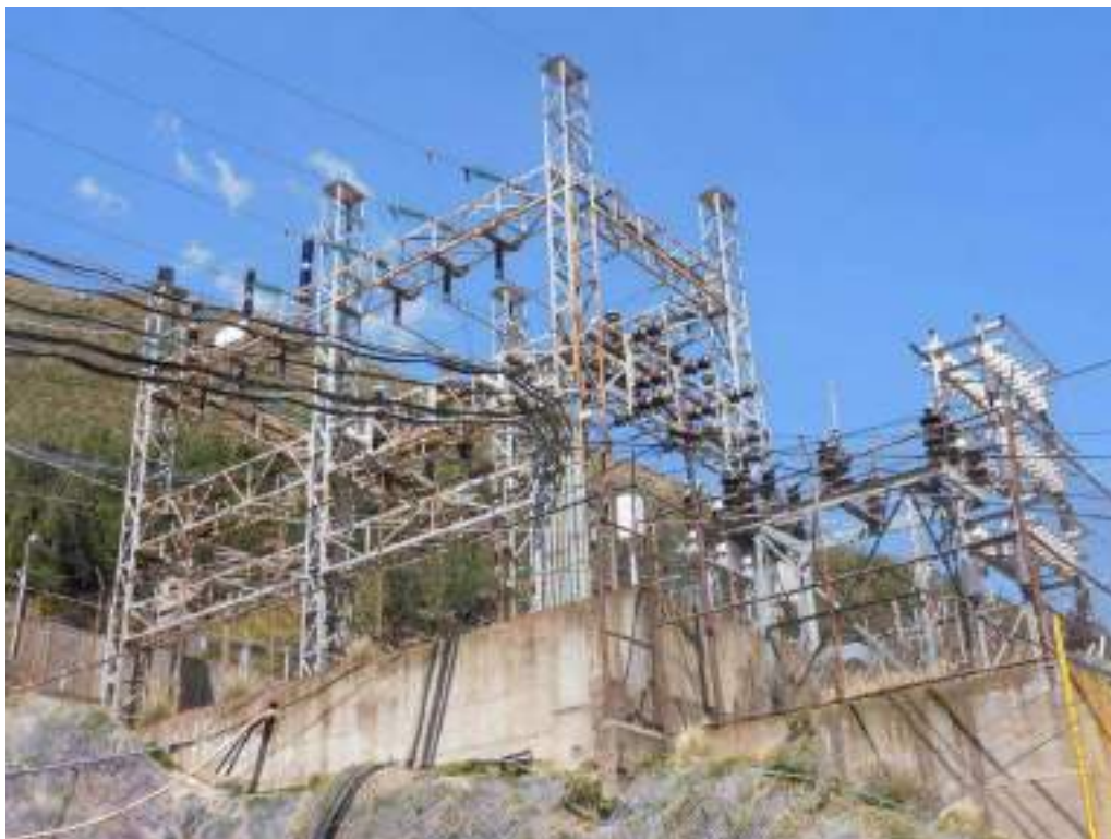
Fotografía 3.3-274 Vista actual 1 del componente
