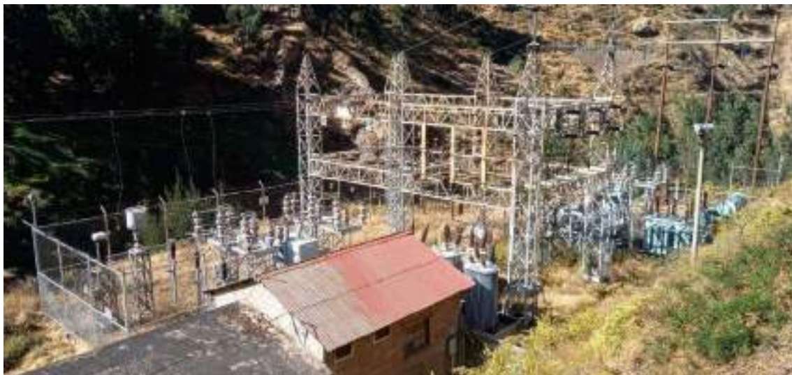
Fotografía 3.3-201 Vista actual 1 del componente
