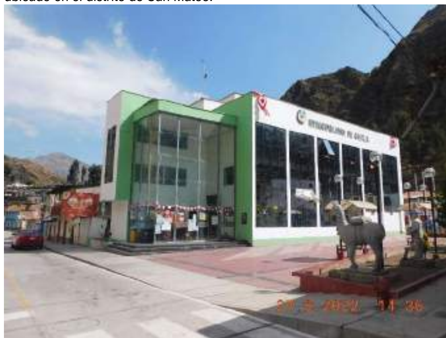
Fotografía 37: Municipalidad Distrital de Chicla.
