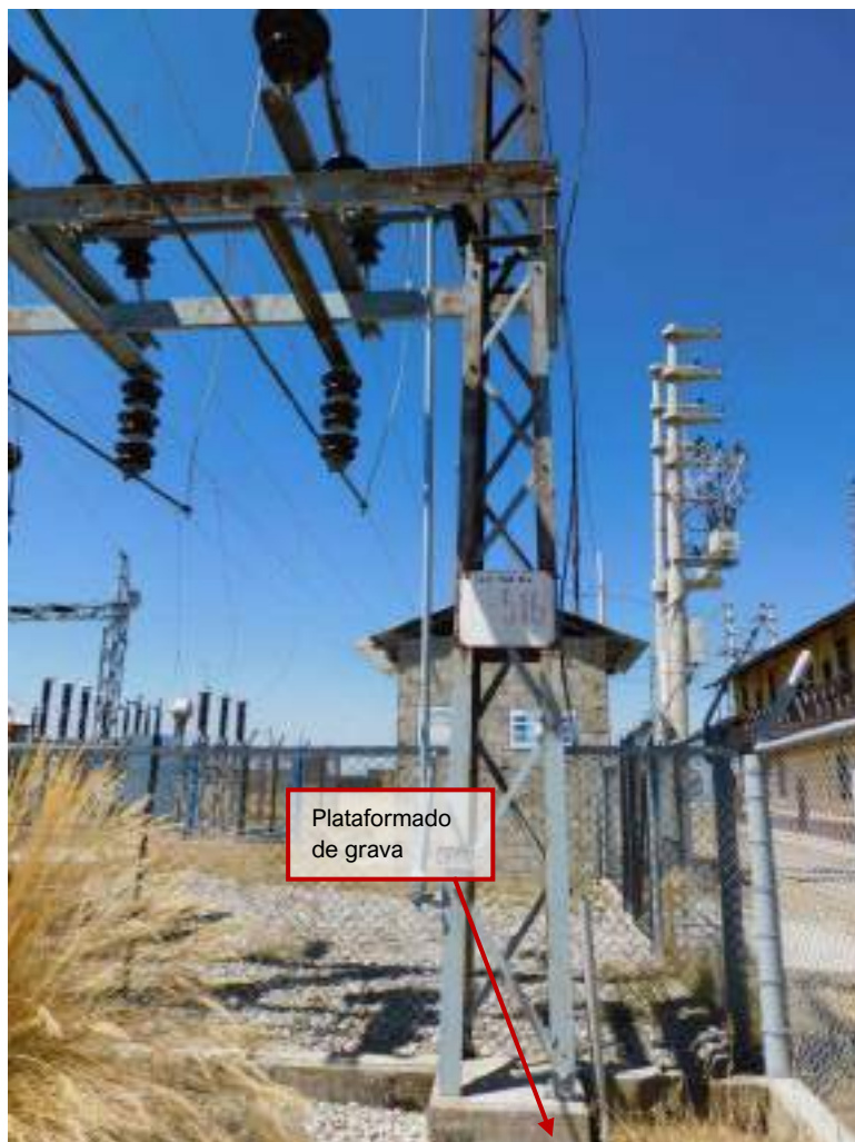
Fotografía 3.3-88 Vista de Plataformado de grava
