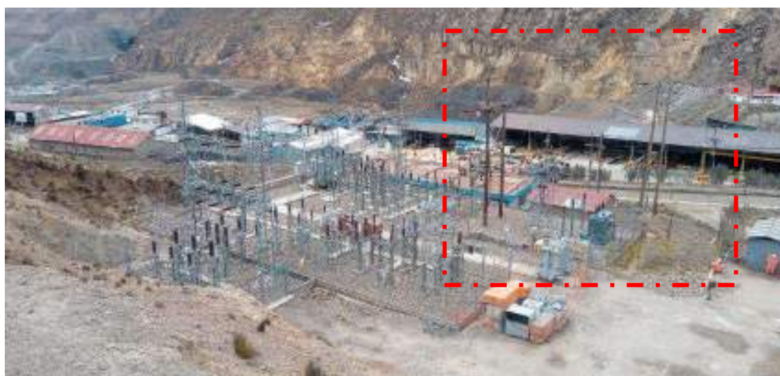
Fotografía 3.3-185 Vista actual 1 del componente
