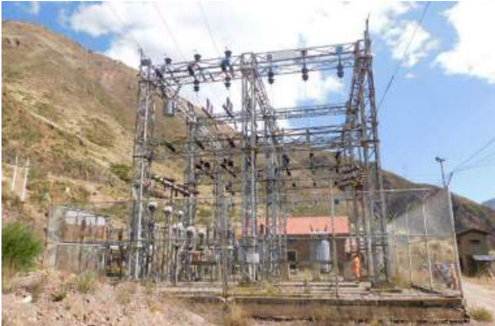
Fotografía 3.3-238 Vista actual 1 del componente
