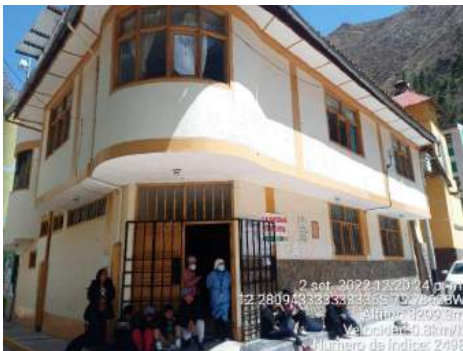
Fotografía 47: Puesto de Salud Alis, ubicado en el distrito de Alis.
