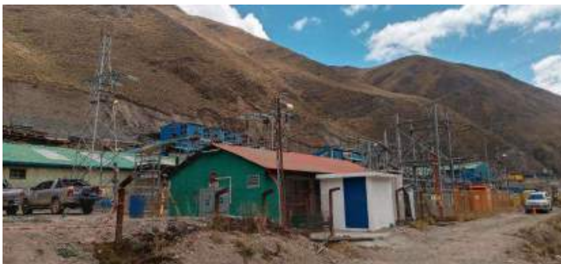
Fotografía 3.3-310 Vista actual 1 del componente
