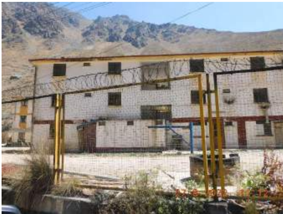
Fotografía 6: En el interior del Campamento Minero Bellavista se identificó la presencia de la Institución Educativa 21602 Mariano Melgar en el cual desarrollan sus estudios los menores pertenecientes al Barrio Los Pinos – La Calzada.
