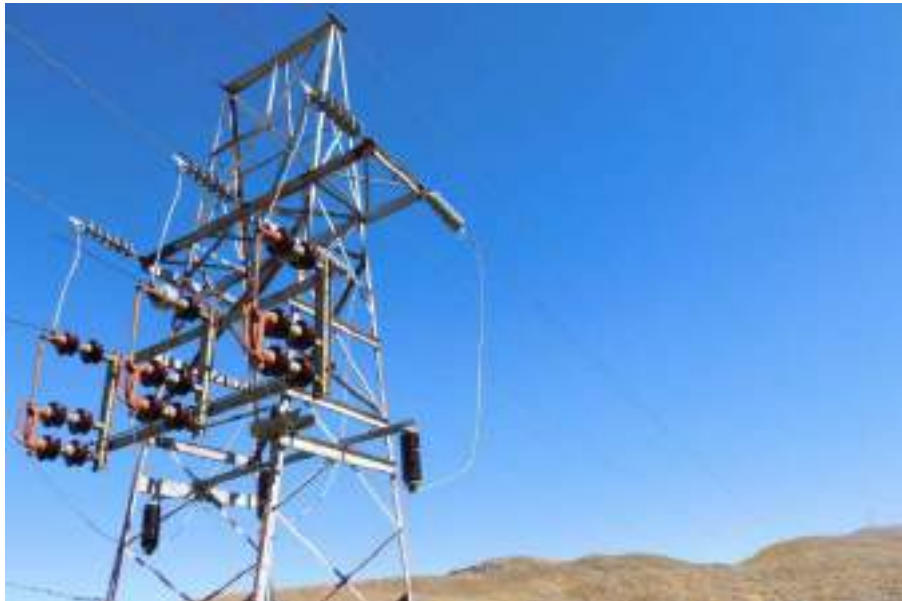
Fotografía 5-3 Pórtico de llegada de la LT 50 kV a la S.E Huicra
