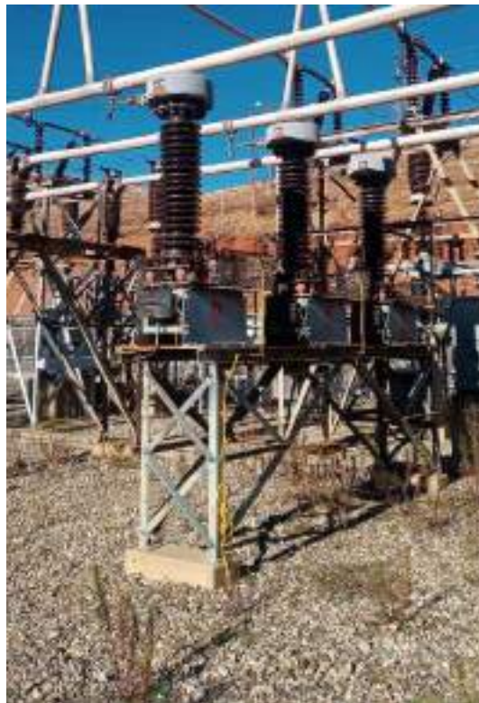
Fotografía 11-8 Transformadores de corriente 72.5 kV S.E. Oroya Nueva.
