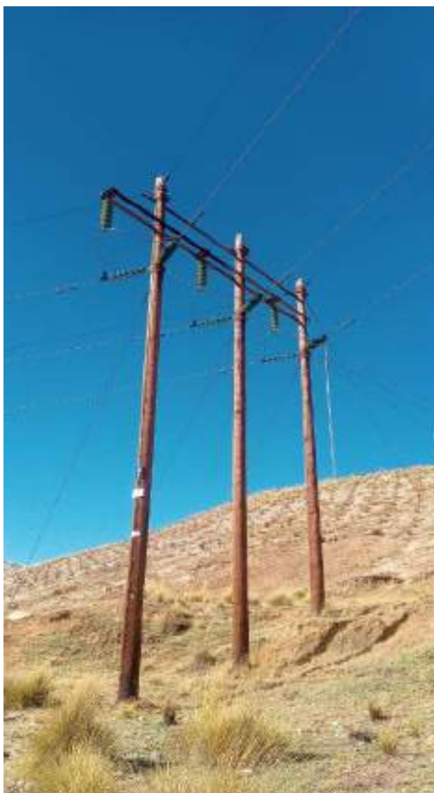
Fotografía 8-1 LT 50 kV de salida desde la S.E. Oroya Nueva hacia la S.E. Mayupampa
