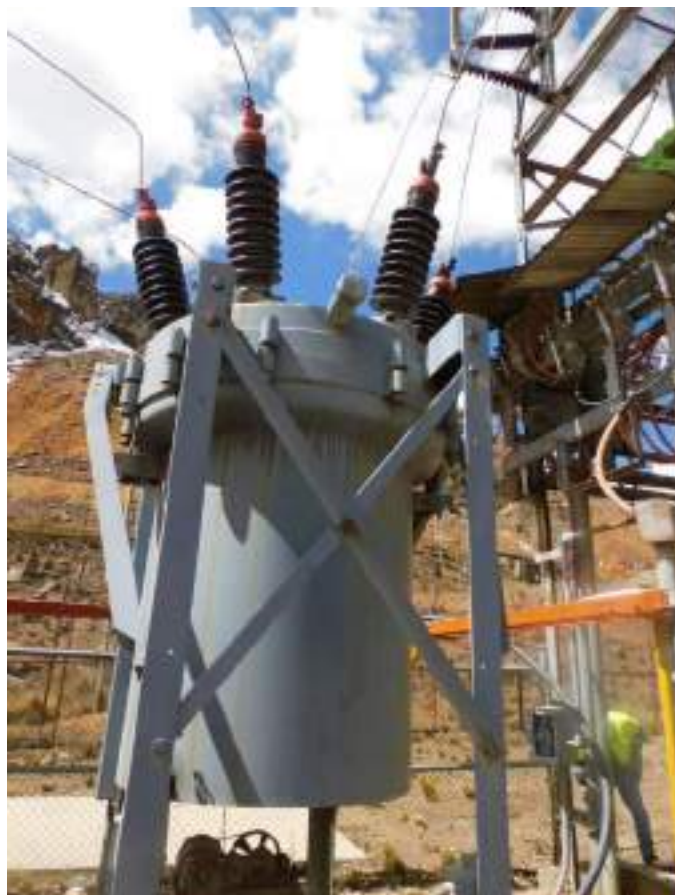
Fotografía 6-4 Interruptor de potencia 72.5 kV en SF6
