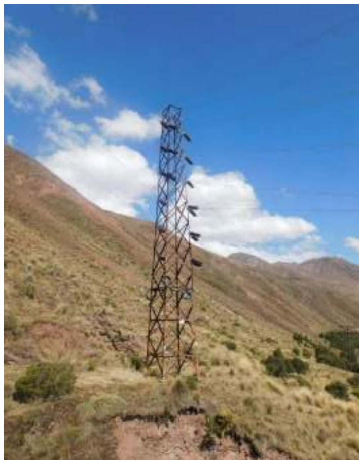
Fotografía 3-2 Estructura terminal de derivación hacia la S.E. Casapalca Norte
