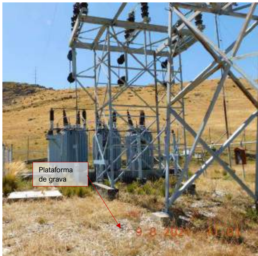
Fotografía 3.3-60 Vista de Plataformado de grava
