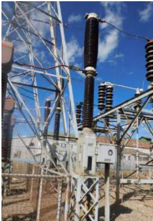
Fotografía 6-4 Pórtico de salida de la línea de transmisión 138 kV.
