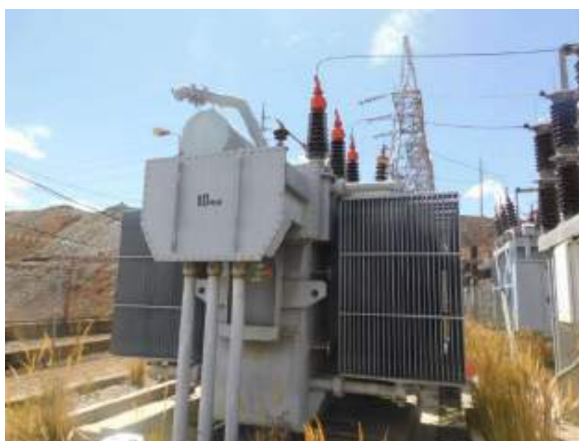
Fotografía 5-2 Transformador de potencia de 10 MVA, S.E. Excelsior 46/12.6 kV
