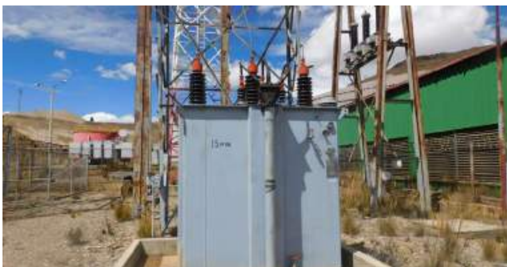
Fotografía 5-2 Transformador de potencia de 10 MVA, S.E. Excelsior 46/12.6 kV
