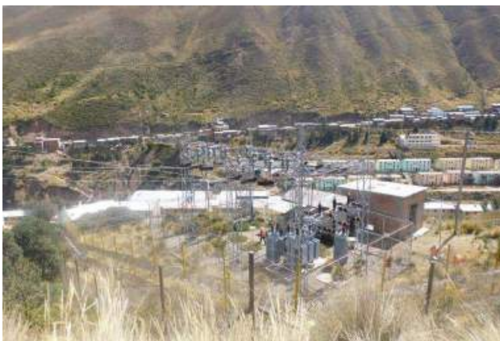
Fotografía 3.3-294 Vista actual 1 del componente
