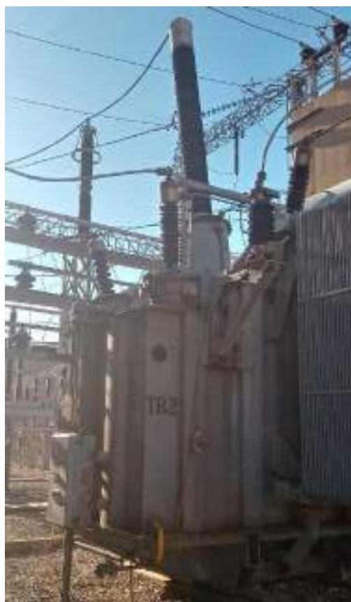
Fotografía 11-2 Transformador trifásico de 33.33 MVA en 220/50/13.8 kV
