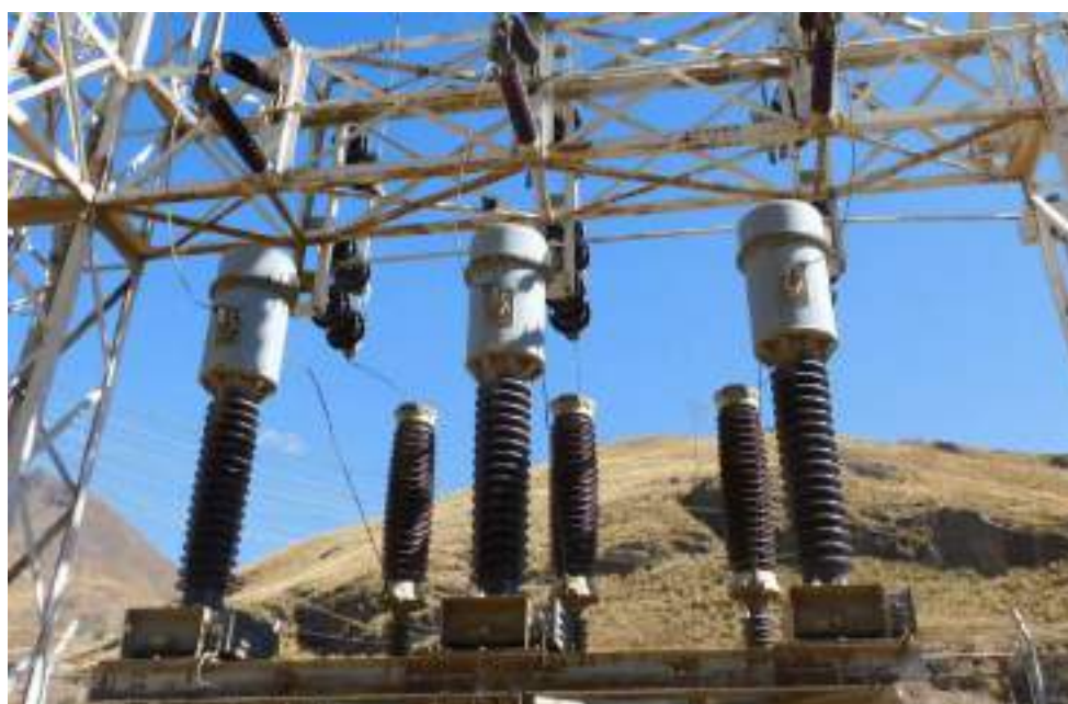
Fotografía 5-4 Transformadores de corriente en la S.E Mahr Túnel
