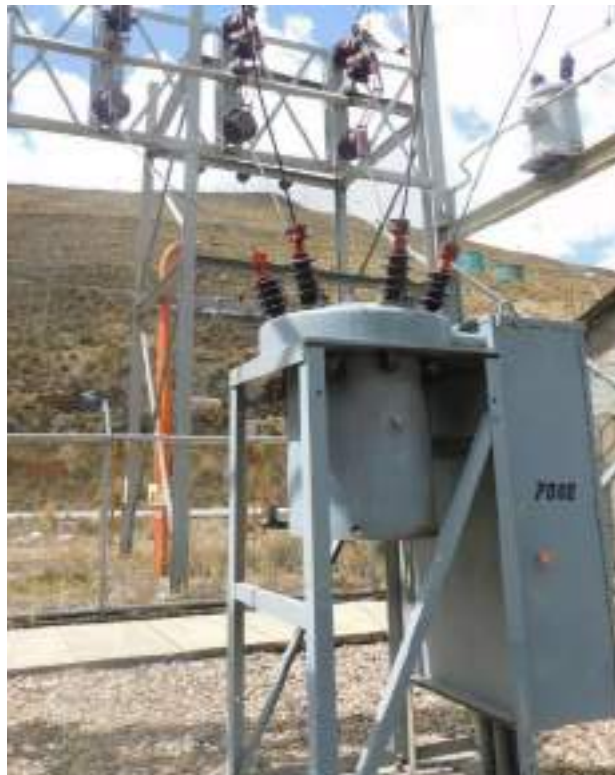
Fotografía 4-4 Interruptor de potencia en 69 kV
