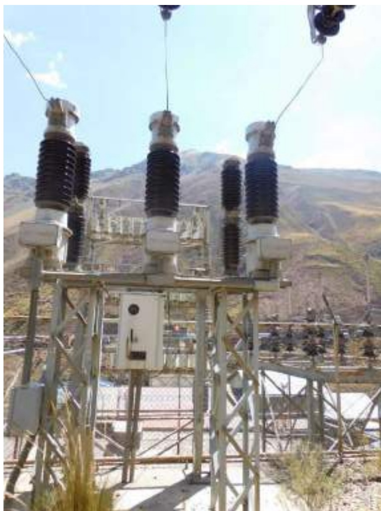
Fotografía 3-3 Transformadores de corriente en 50 kV
