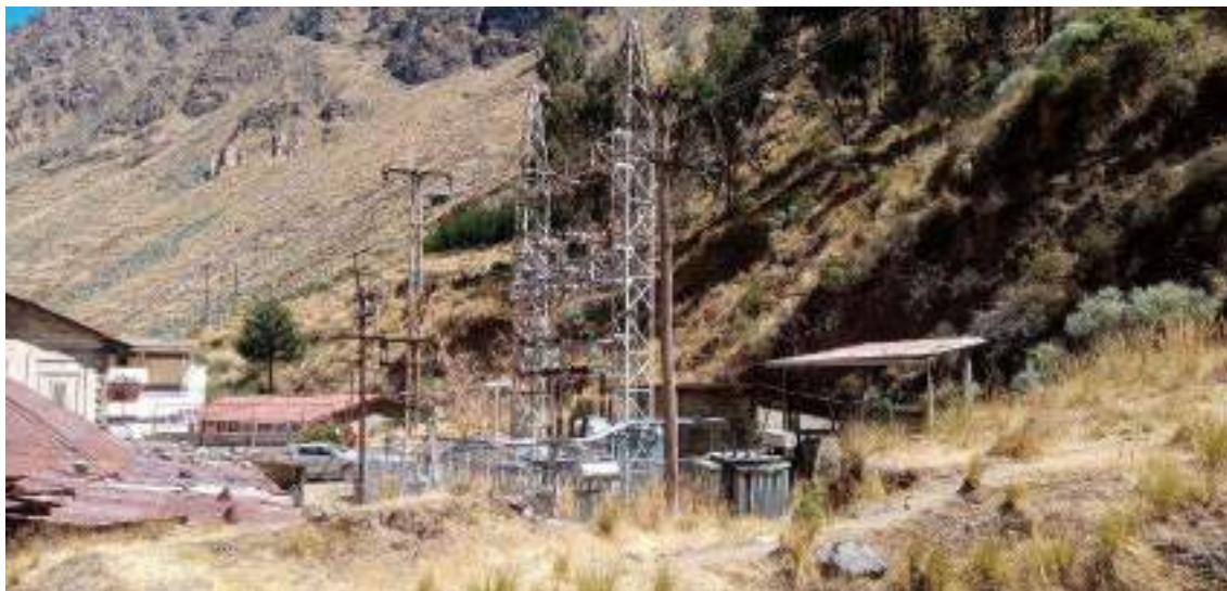
Fotografía 3.3-222 Vista actual 1 del componente
