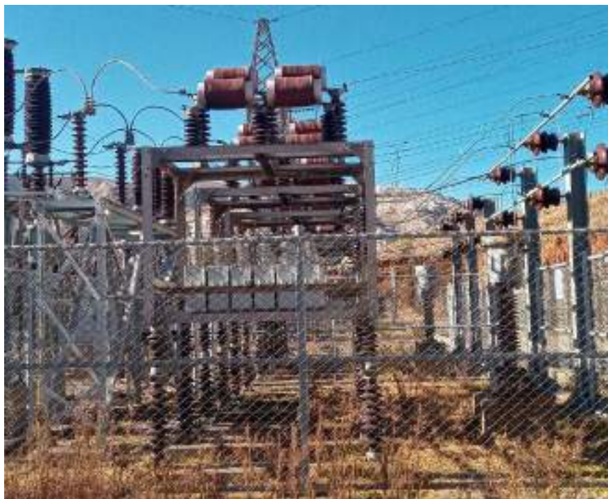
Fotografía 11-8 Transformadores de corriente 72.5 kV S.E. Oroya Nueva.
