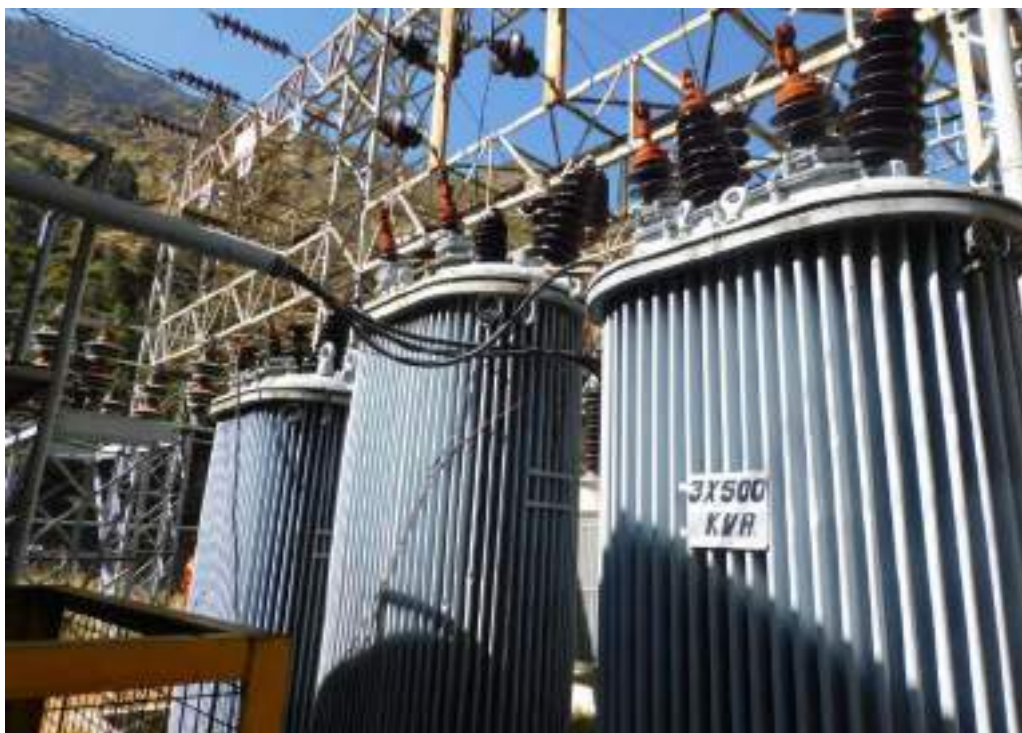
Fotografía 4-2 Transformador trifásico de potencia 1.5 MVA S.E. San Mateo 50/4.16 kV
