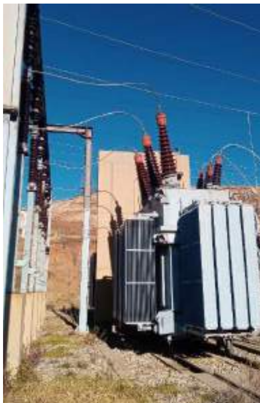
Fotografía 11-4 Interruptor de potencia en SF6, de 72.5 kV S.E. Oroya Nueva.
