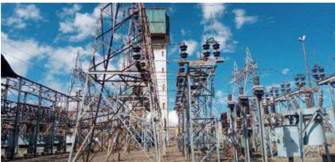
Fotografía 3.3-20 Vista actual 2 del componente
