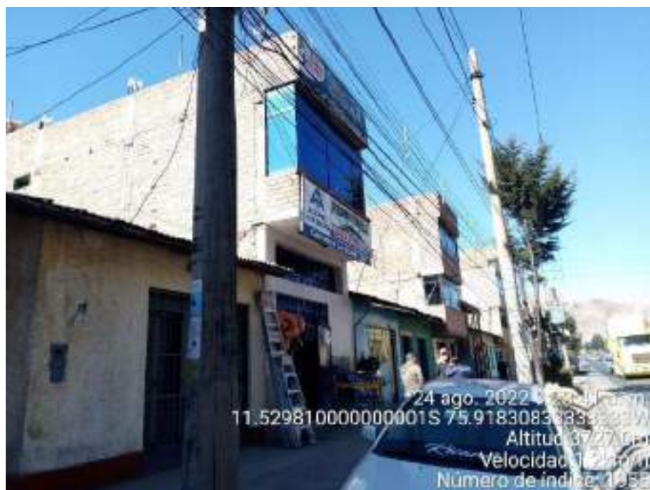
Fotografía 20: Asociación de Vivienda Ex Enafer de Huaymanta, ubicado a menos de 200 m de la zona STE Centro 9, se puede apreciar viviendas mayoritariamente construidas con ladrillo y cementos tanto en techos y paredes, aunque también se observaron viviendas cuyos techos eran de calamina.
