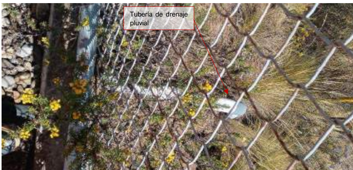
Fotografía 3.3-309 Vista de Canal exterior de drenaje pluvial.
