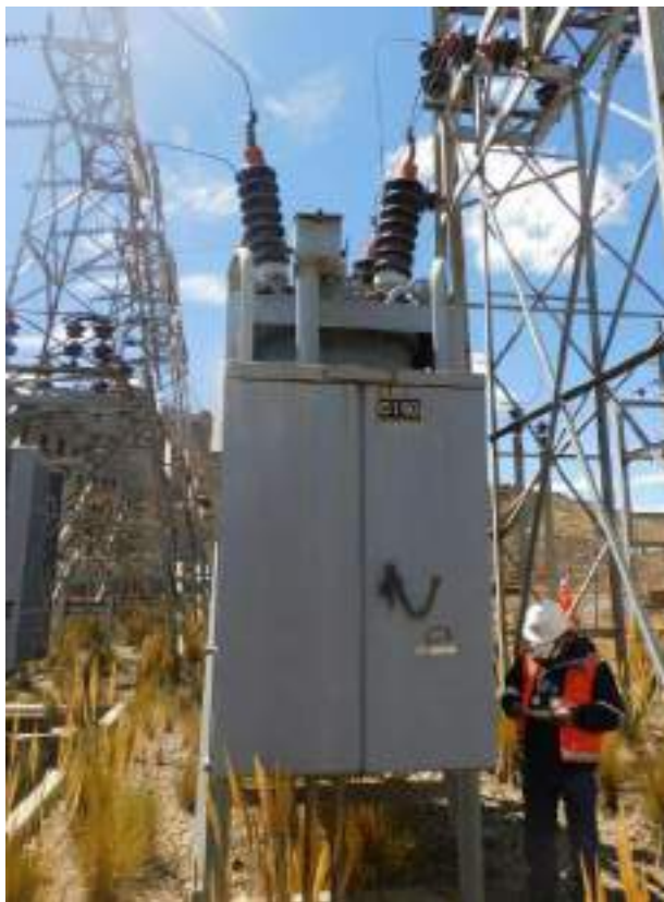
Fotografía 5-6 Transformador de corriente en 50 kV.
