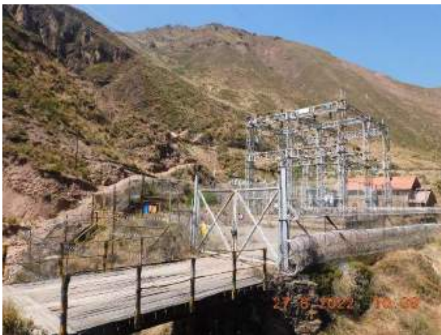
Fotografía 15: Vista general de la Zona STE Centro 16 (SE Antuquito), ubicado en el distrito de Chicla, provincia de Huarochirí.
