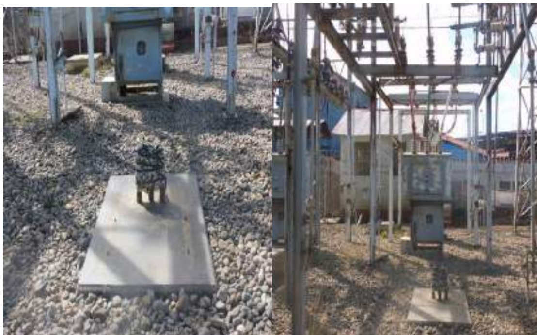
Fotografía 6-8 El interruptor de potencia Cod 2003 retirado de la subestación, pero aún se muestra en los planos como si estuviera instalado.
