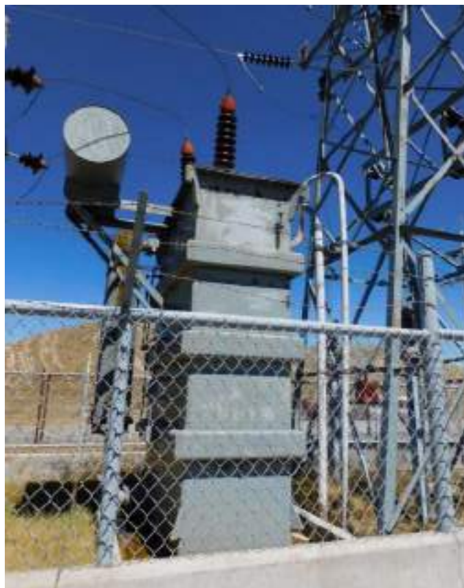
Fotografía 4-3 Transformador trifásico de potencia 2 MVA, S.E. San Juan de 50/2.4 kV.
