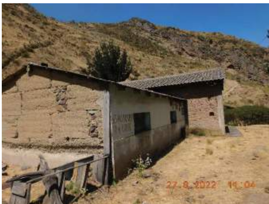
Fotografía 9: Asimismo, a 120 m aproximadamente del AIP STE Centro 15 (SE San Mateo), se registró la presencia de una vivienda, aunque no se pudo identificar a los propietarios de la misma.
