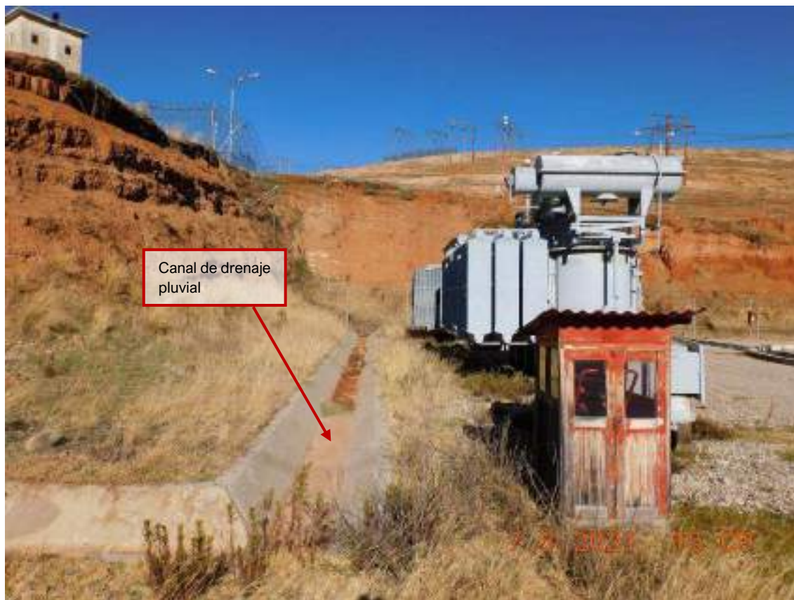
Fotografía 3.3-124 Vistas de Canal exterior de drenaje pluvial
