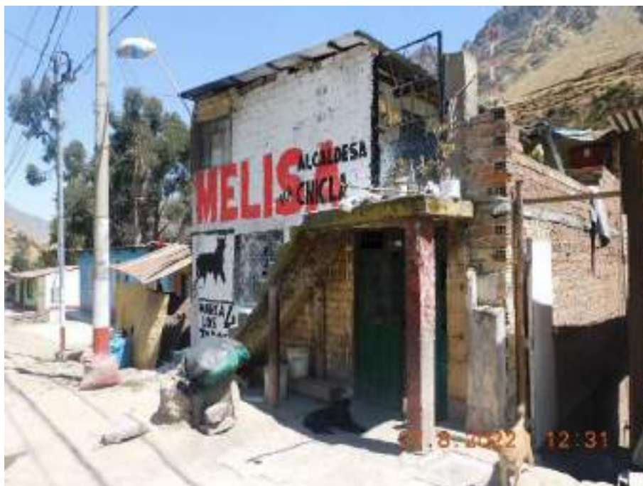
Fotografía 12: Se observó que las viviendas del Barrio Los Pinos – La Calzada están construidas, en su mayoría, con ladrillo y cemento en sus paredes, mientras los techos son de calamina.
