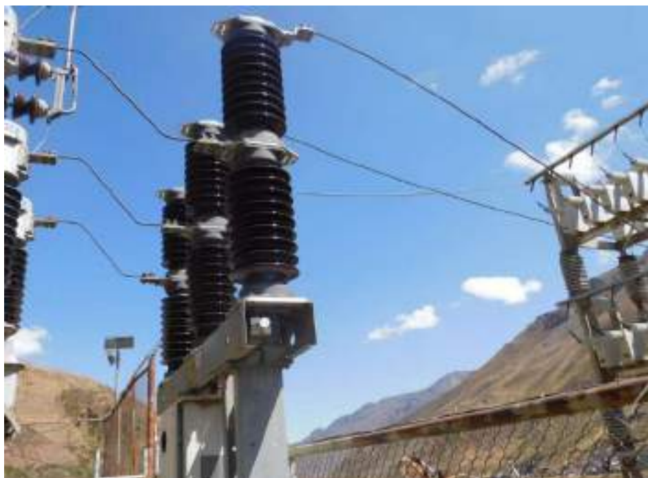
Fotografía 3-5 Interruptor de potencia de 50 kV
