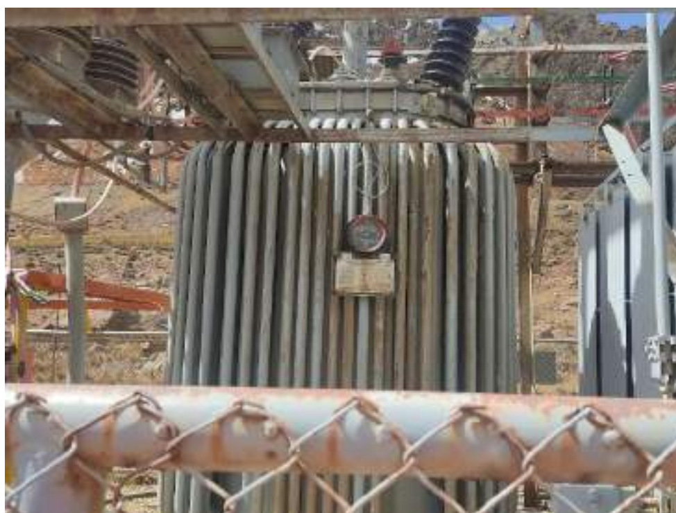
Fotografía 6-6 Transformadores Monofásicos fuera de servicio 72.5 kV que falta retirar
