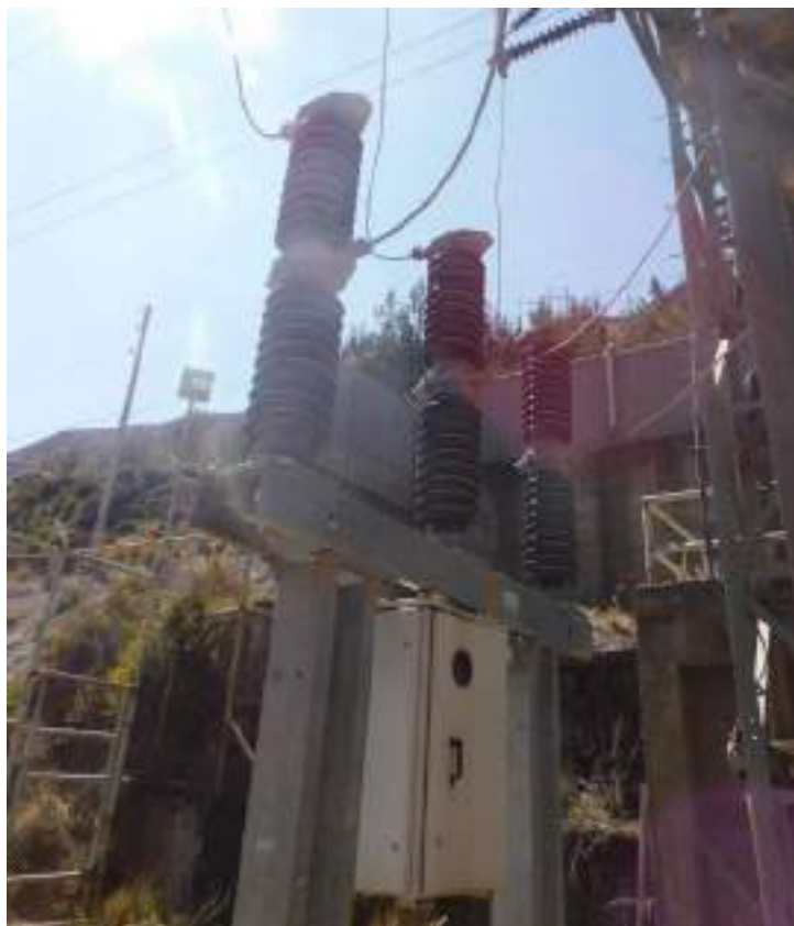
Fotografía 5-3 Transformadores de corriente en 50 kV
