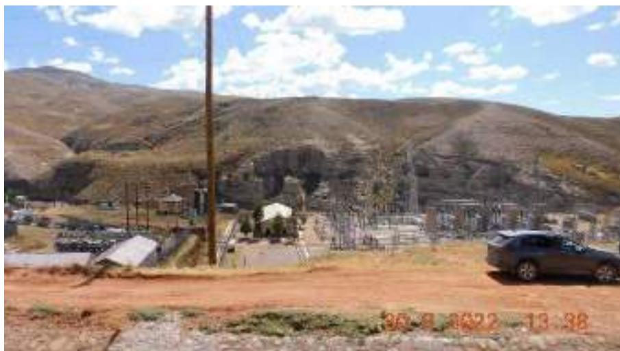
Fotografía 8: Vista general de la Zona STE Centro 9 (SE Oroya Nueva), ubicado en el distrito de La Oroya.
