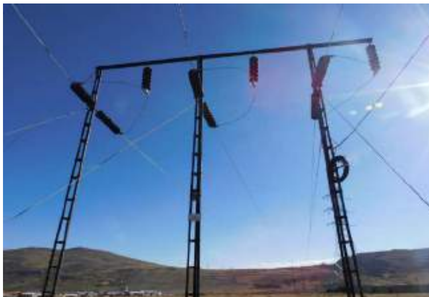
Fotografía 4-2 Torre de terminal de salida de la línea LT 50 kV hacia la S.E. La Fundación.
