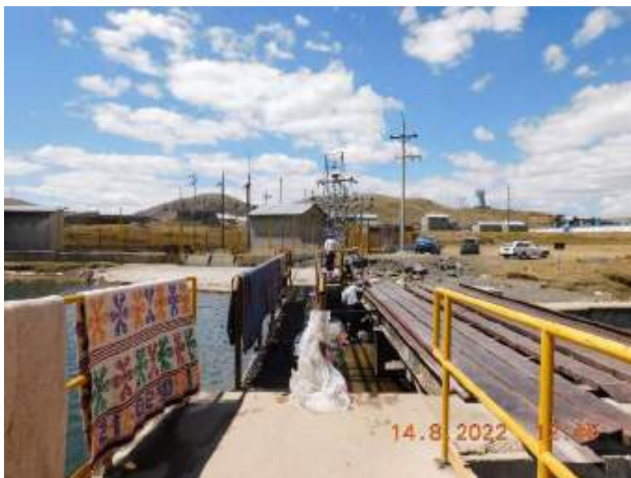
Fotografía 9: Inmediato de la zona PAD STE Centro 3 (SE San Juan), a casi 7-10 metros de la SE San Juan, se observó un puente peatonal que cruza el río San Juan. Al respecto, se observó que algunos pobladores de la ciudad de Pasco (según señalaron en el momento de la visita) vienen a esta zona y hacen uso del río San Juan y del puente peatonal para lavar sus frazadas.
