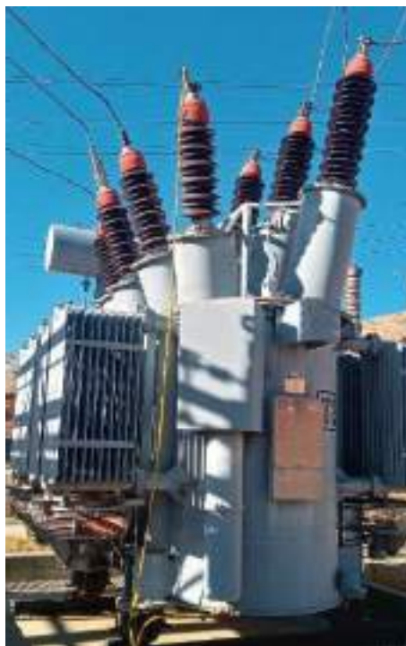
Fotografía 11-2 Transformador trifásico de 33.33 MVA en 220/50/13.8 kV
