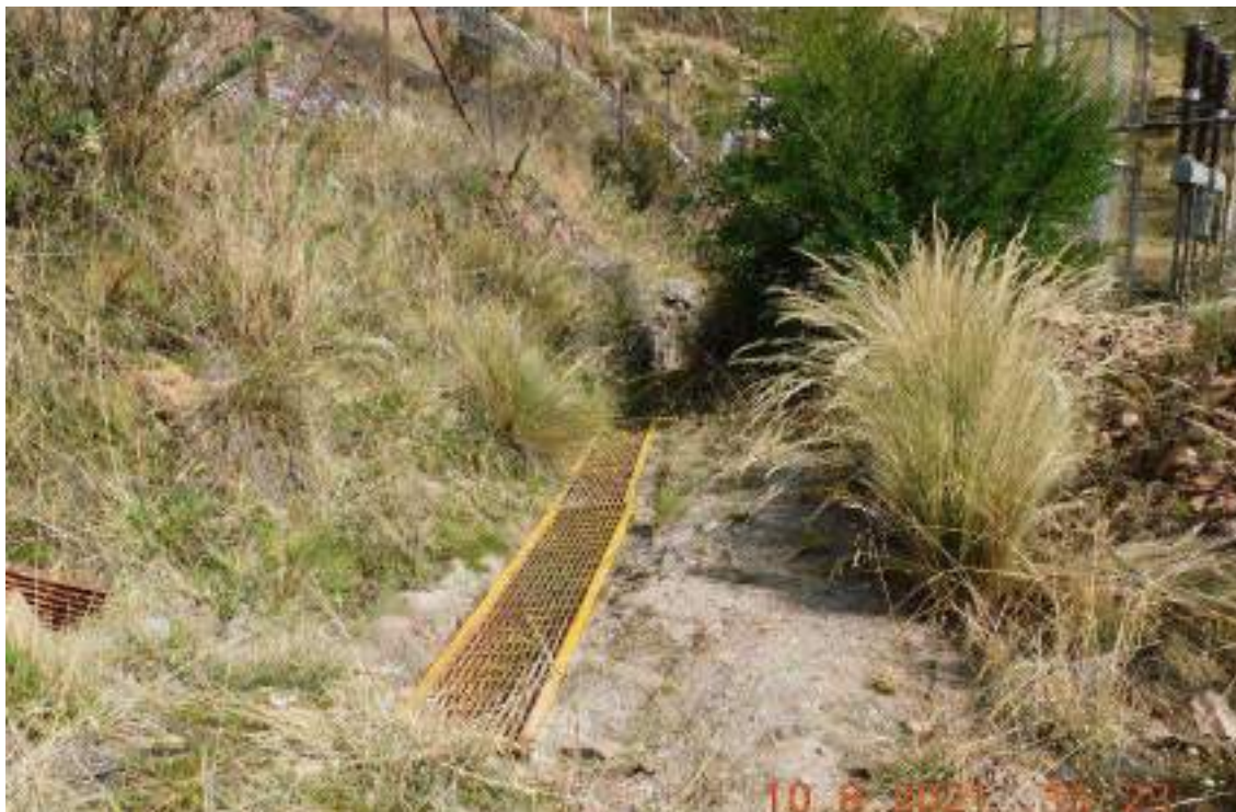
Fotografía 3.3-255 Vista de Canal exterior de drenaje pluvial.
