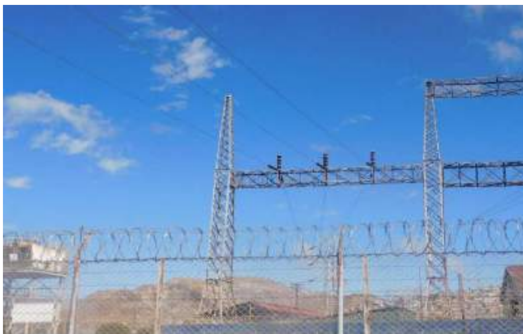
Fotografía 6-4 Pórtico de salida de la línea de transmisión 138 kV.
