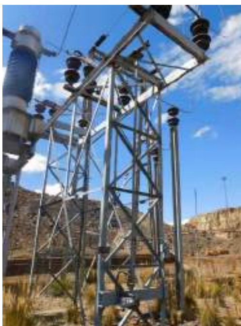
Fotografía 5-8 Juegos de seccionadores de barra con conexión a tierra en 50 kV.
