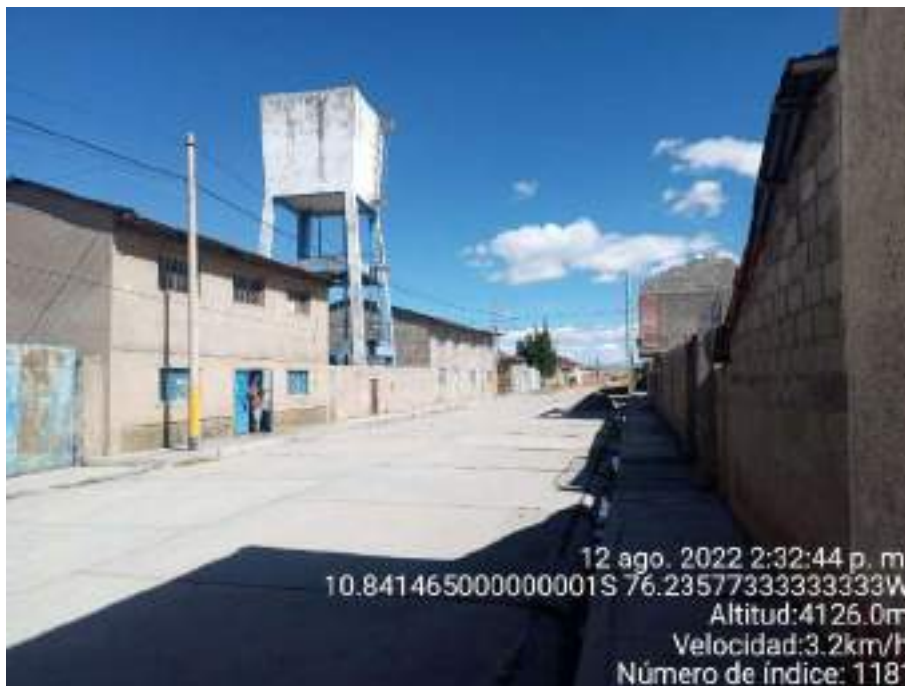
Fotografía 37: Viviendas de la sede distrital Vicco, CP Vicco, se observa la predominancia de viviendas construidas de material noble, aunque también persisten viviendas con paredes hechas de tapia o adobe.
