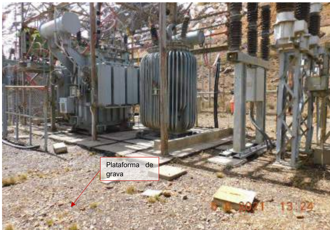
Fotografía 3.3-162 Vista de explanada – Plataforma de grava
