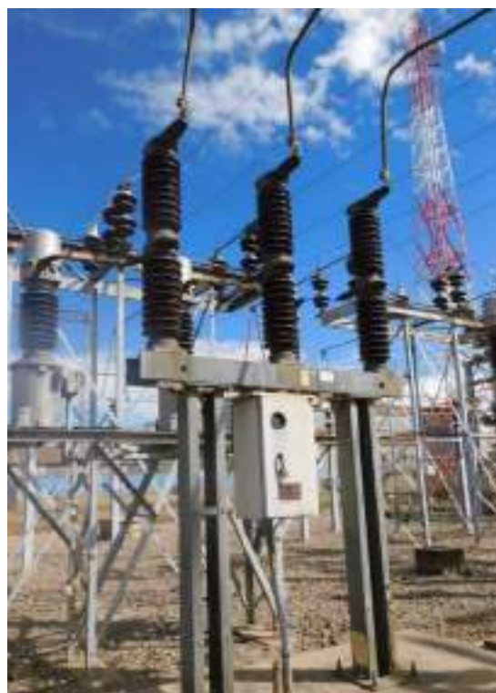
Fotografía 6-6 Interruptores de potencia en 50 kV.
