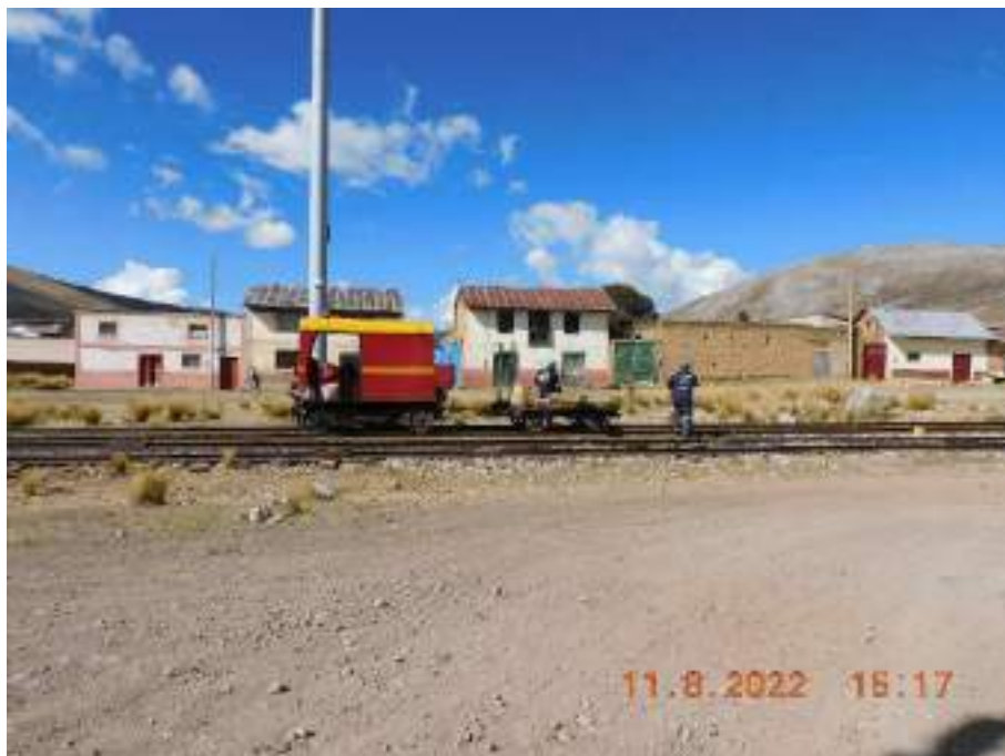
Fotografía 4: Asimismo, de manera cercana al Barrio Chivian también se observó una parte del tramo de la línea ferroviaria Lima – La Oroya, Ferrocarril del Centro.
