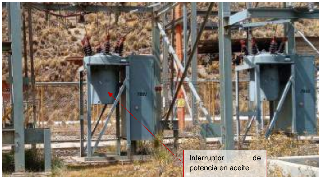
Fotografía 3.3-319 Vista Interruptor de potencia en aceite de 69 kV
