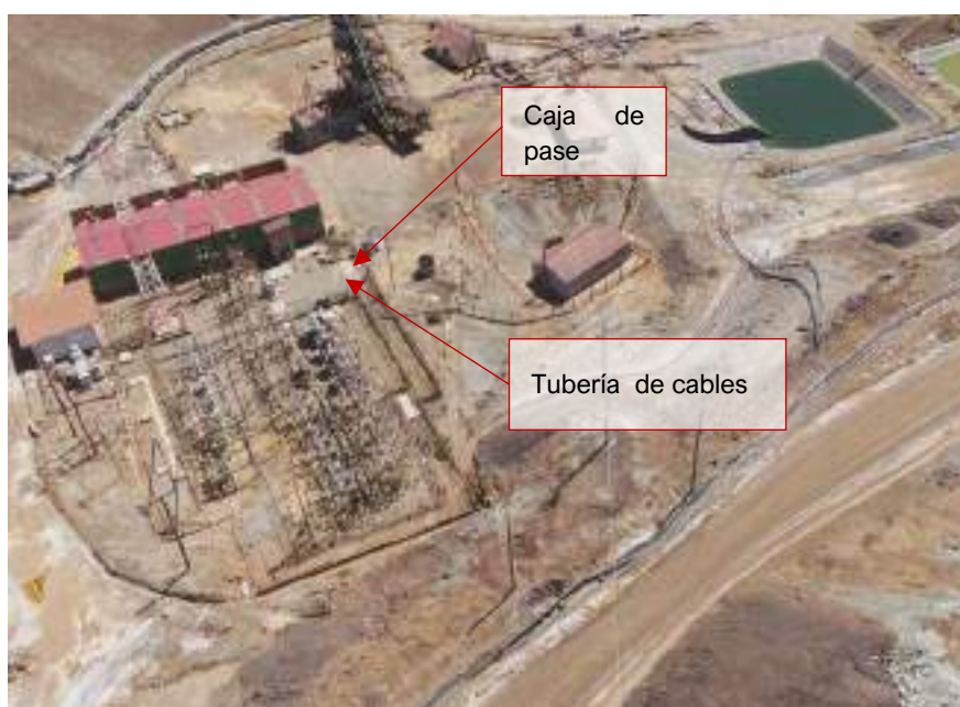
Fotografía 3.3-13 Vista de canaleta de cables
