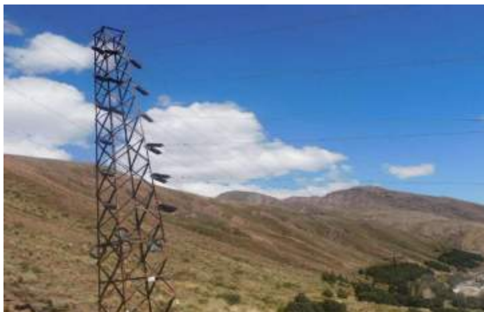
Fotografía 4-2 Torre terminal derivación de LT 50 kV desde S.E. Carlos Francisco hacia S.E. Casapalca Norte.
