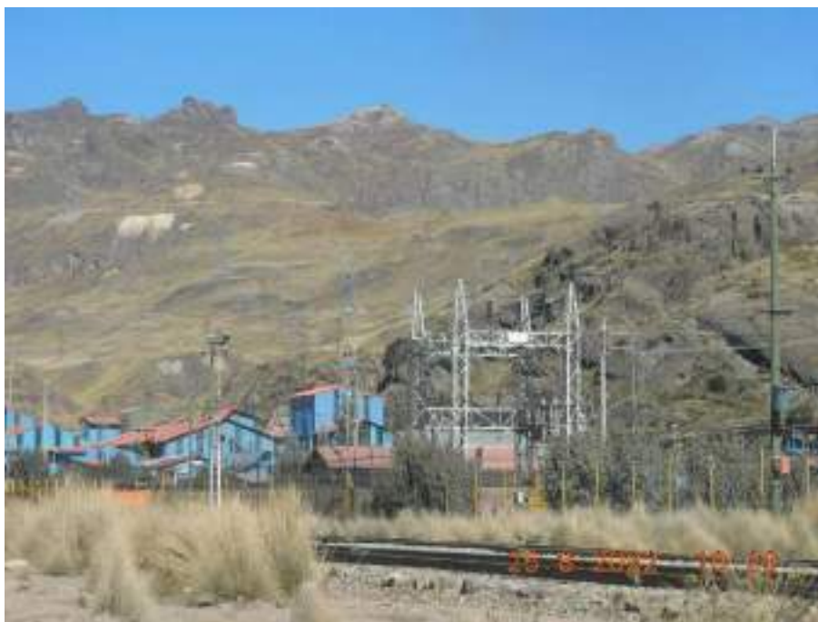
Fotografía 38: Zona STE Centro 10 (SE Mahr Tunel), ubicado en el distrito Yauli. La subestación se encuentra dentro de la zona de operaciones mineras de la empresa VOLCAN S.A., por lo cual no involucra poblaciones en su interior. El poblado próximo identificado fue el CP Manuel Montero ubicado a 30 m del ámbito de evaluación.
