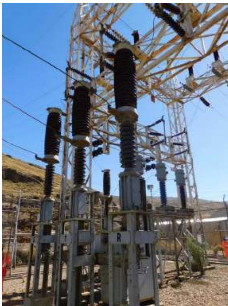
Fotografía 5-2 Interruptor de potencia 1200 Amp, 72.5 kV S.E. Mahr Túnel
