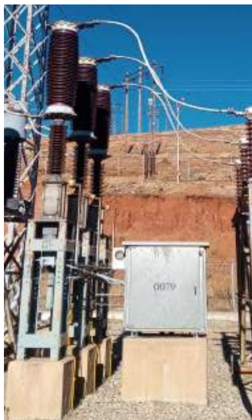
Fotografía 11-4 Interruptor de potencia en SF6, de 72.5 kV S.E. Oroya Nueva.
