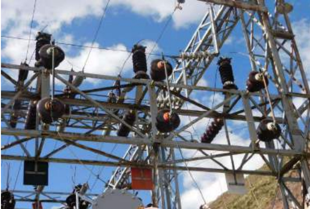
Fotografía 5-3 Seccionador de línea en 72.5 kV
