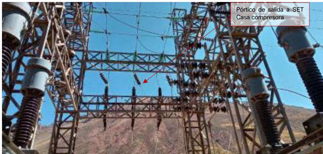
Fotografía 3.3-270 Línea de transmisión de 50 kV desde S.E. Carlos Francisco a SET Compressoras (Instalaciones de terceros)
