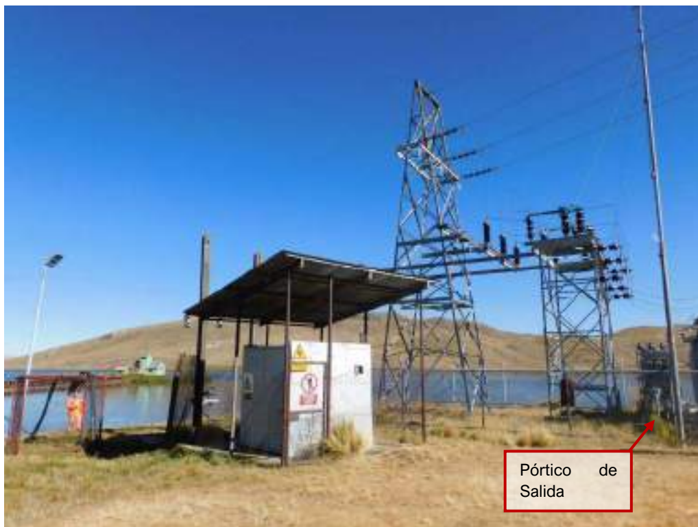
Fotografía 3.3-63 Vista de Pórtico de salida
