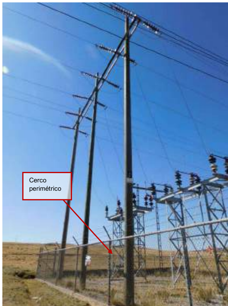
Fotografía 3.3-83 Vista de Cerco perimétrico
