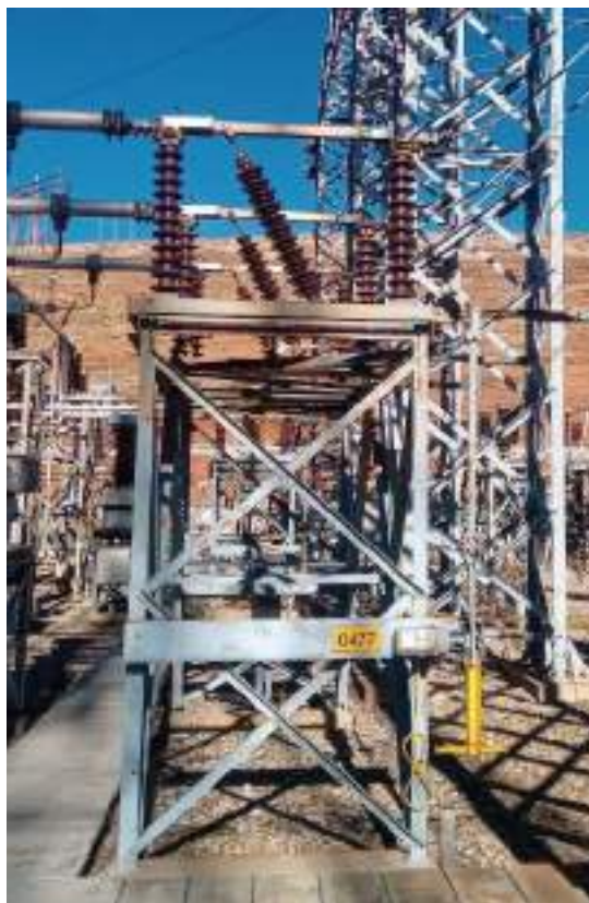
Fotografía 11-6 Seccionador de barra de 72.5 kV S.E. Oroya Nueva
