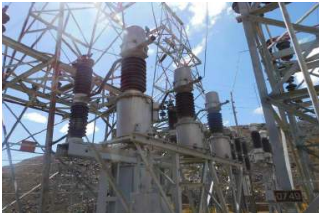
Fotografía 5-6 Transformador de corriente en 50 kV.
