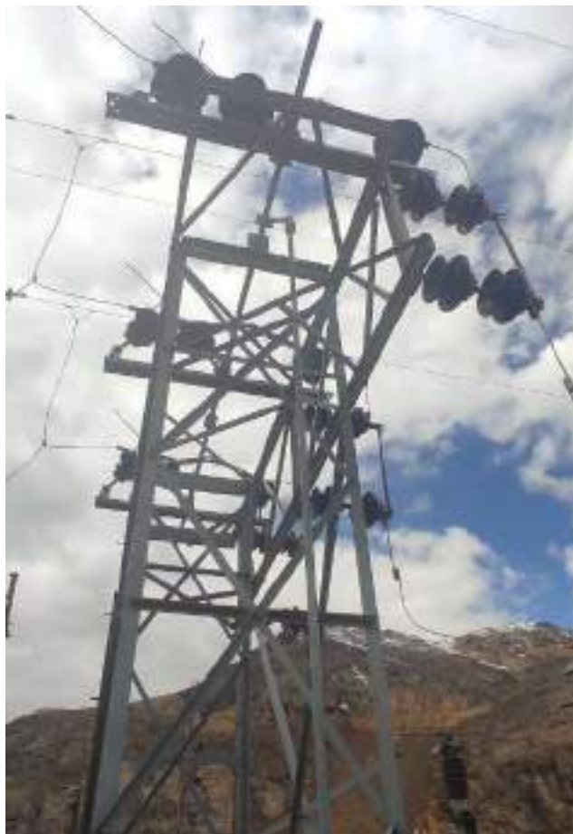
Fotografía 5-2 Seccionador de línea de 72.5 kV S.E. San Antonio
