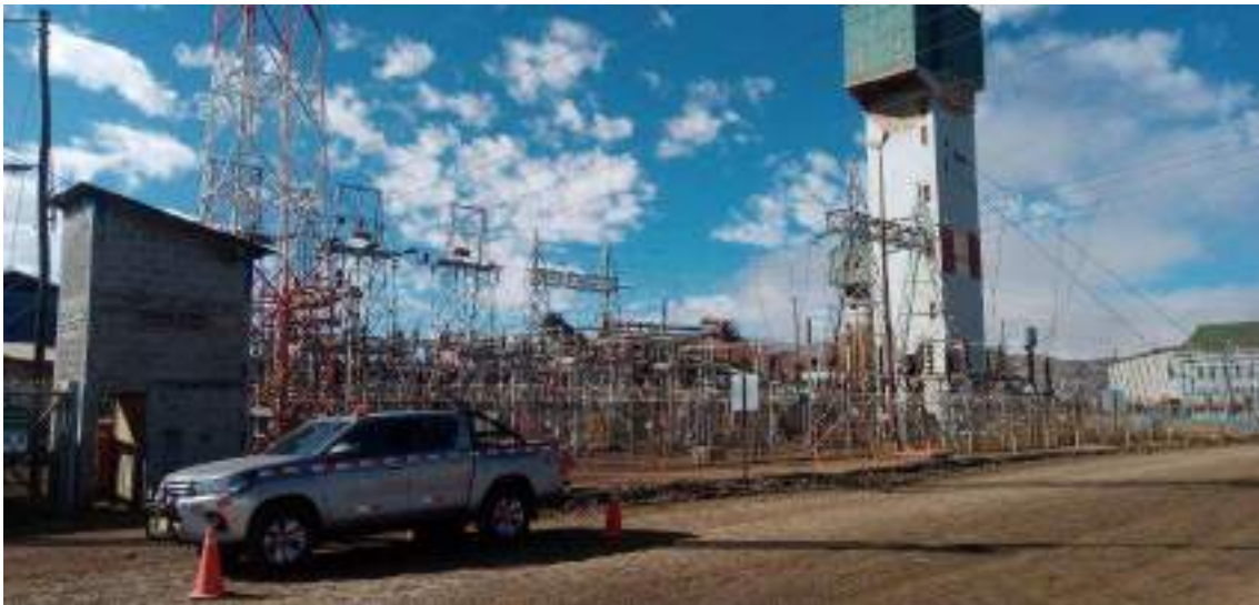
Fotografía 3.3-19 Vista actual 1 del componente
