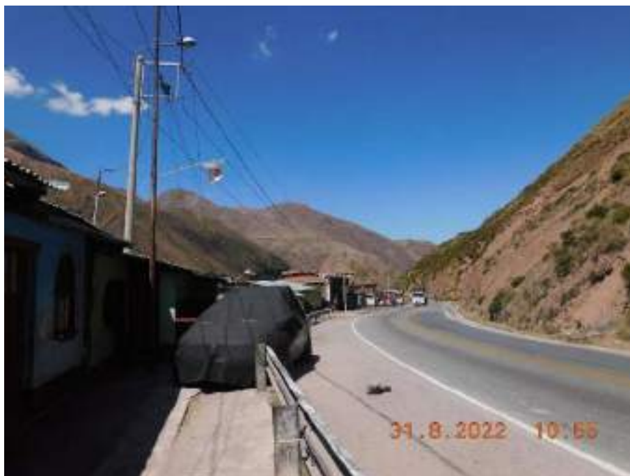
Fotografía 30: Tramo de la vía nacional PE – 22, Carretera Central, que atraviesa al Barrio Unión Progreso Embarcadero. Se observó que se encuentra asfaltada y en buenas condiciones.
