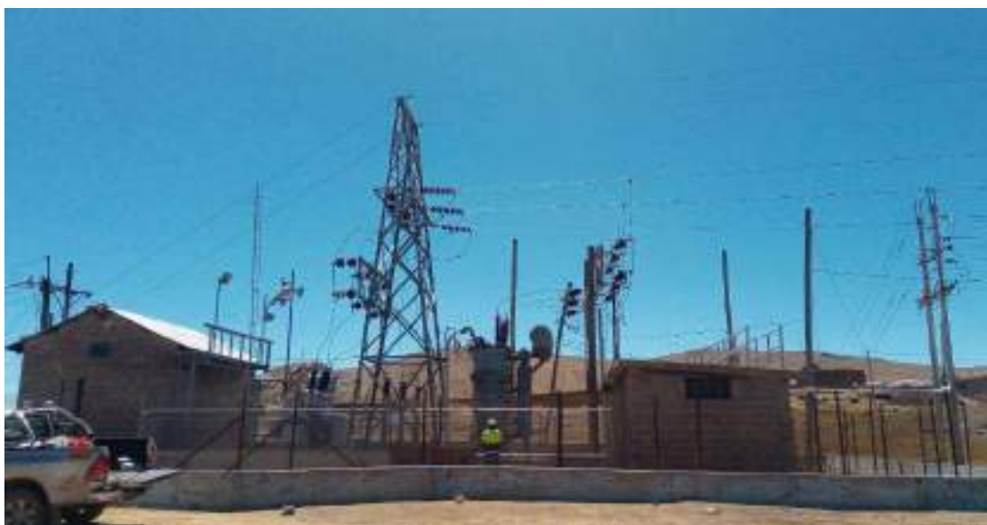
Fotografía 3.3-39 Vista actual del componente
