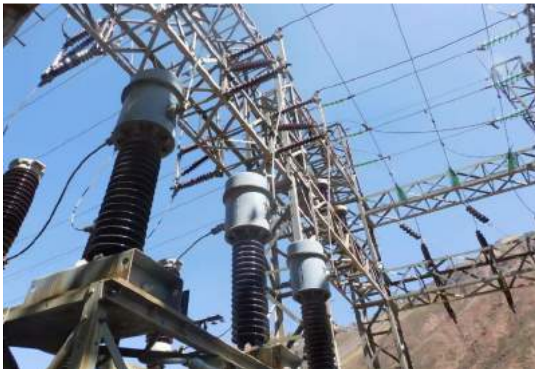
Fotografía 5-3 Transformadores de corriente en 50 kV
