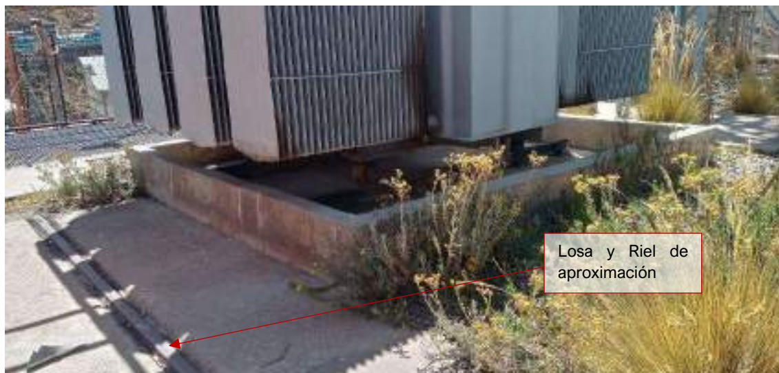
Fotografía 3.3-280 Vista de Rieles de aproximación
