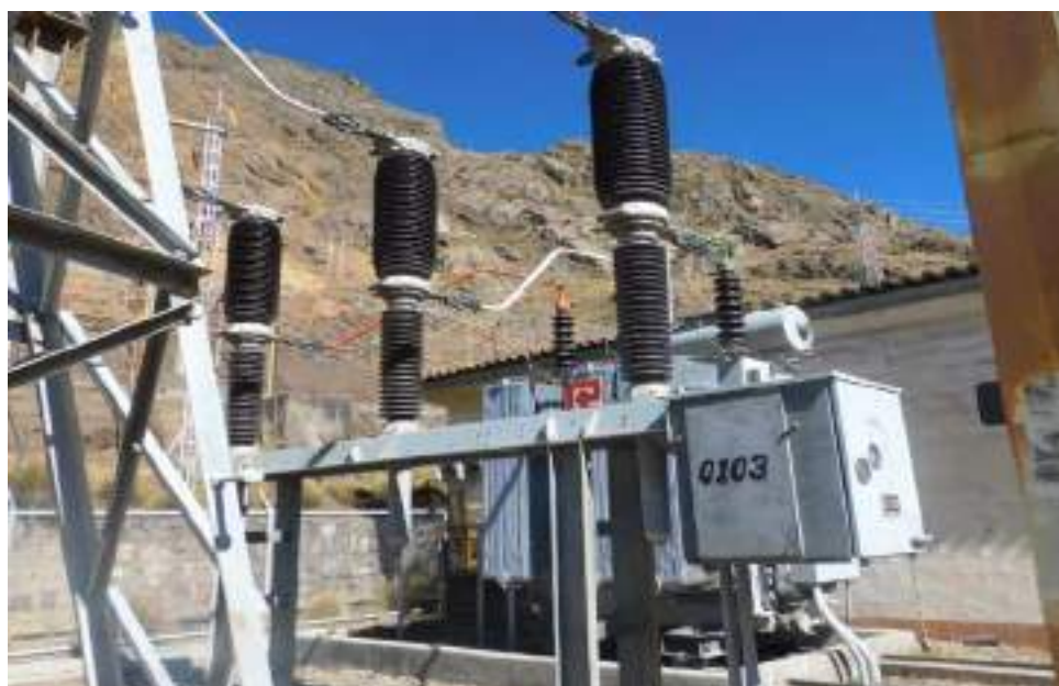
Fotografía 4-2 Interruptor de potencia S.E. San Cristóbal 72.5 kV
