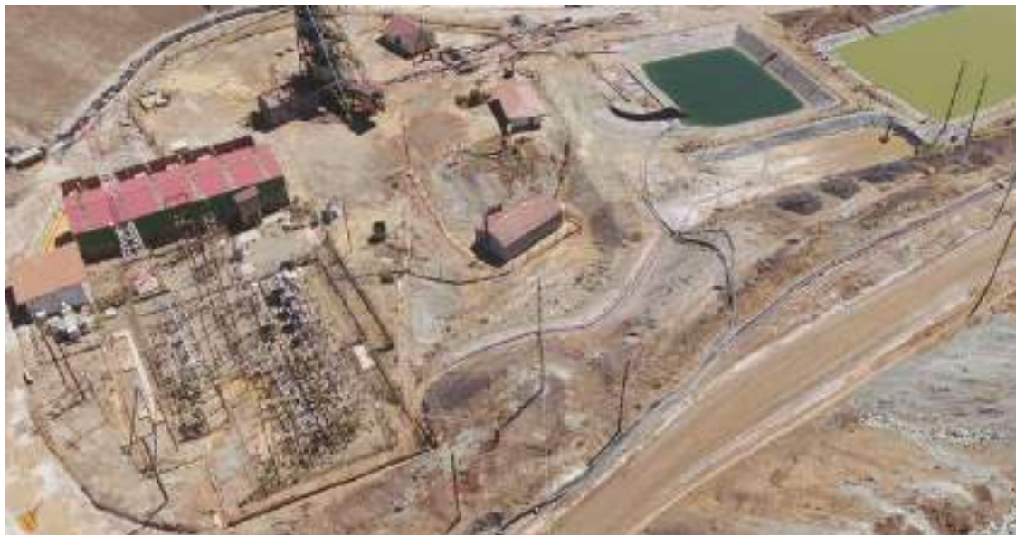
Fotografía 3.3-11 Vista exterior de Sala de Control
