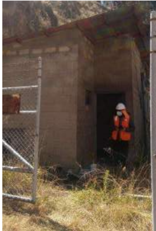
Fotografía 3.3-231 Vista exterior de Sala de Control
