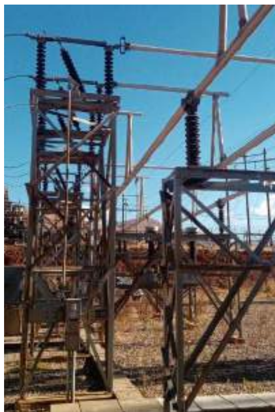
Fotografía 11-6 Seccionador de barra de 72.5 kV S.E. Oroya Nueva
