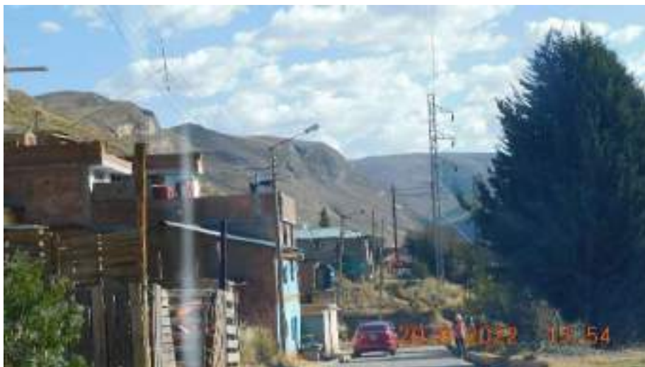
Fotografía 19: Pueblo Joven San Vicente de Paul, se observó la presencia de redes de alumbrado público desplegadas en todo el poblado.
