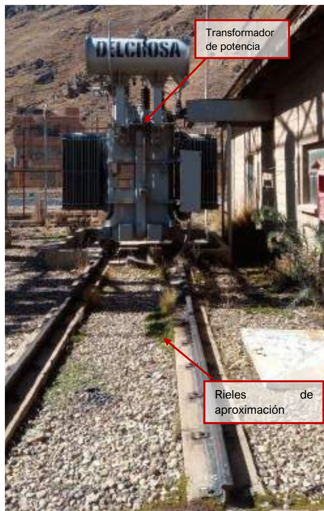
Fotografía 3.3-133 Vista de Rieles de aproximación
