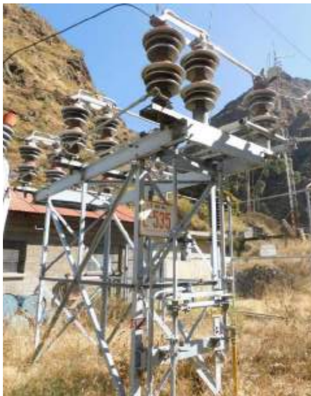
Fotografía 4-4 Interruptor de potencia en 72.5 kV
