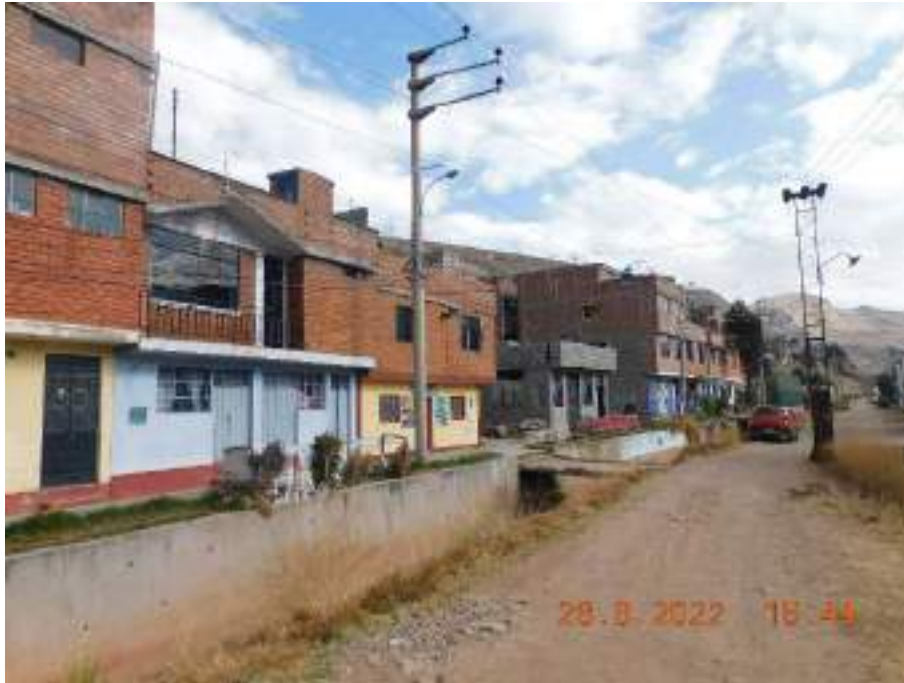
Fotografía 17: Pueblo Joven Micaela Bastidas, se aprecia la vía sin afirmar paralela a la Carretera Central que brinda el acceso principal al referido poblado, así como los cables de transmisión energética para alumbrado público y viviendas.
