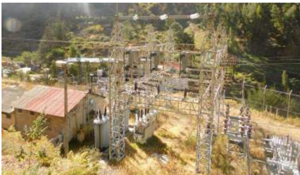
Fotografía 3.3-202 Vista actual 2 del componente
