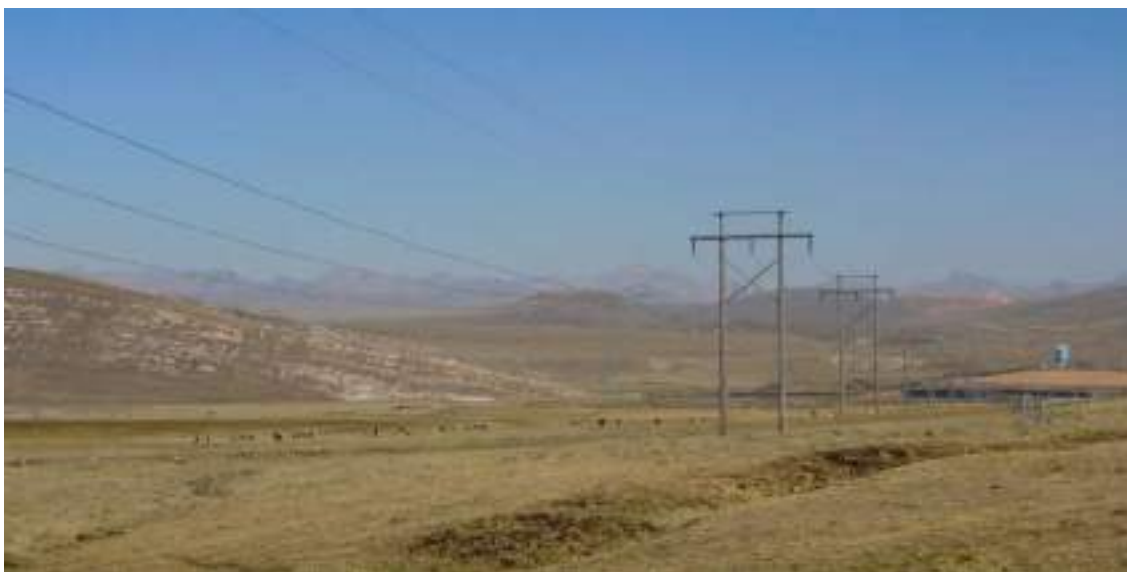
Fotografía 5-2 Pórtico de salida de LT 50 kV simple terna de la S.E Vista Alegre hacia la S.E. San Juan.
