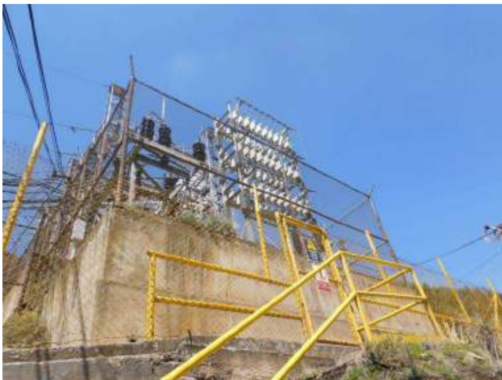
Fotografía 3.3-275 Vista actual 2 del componente
