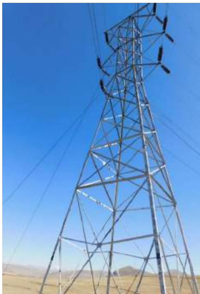
Fotografía 6-1 Torre de anclaje que sale de la S.E. Vista Alegre hacia la S.E. Shelby
