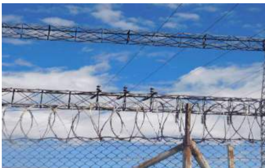
Fotografía 5-2 Pórtico de la L.T. de 50 kV simple terna a la llegada de S.E Paragsha I proveniente de la S.E. Derivación Milpo
