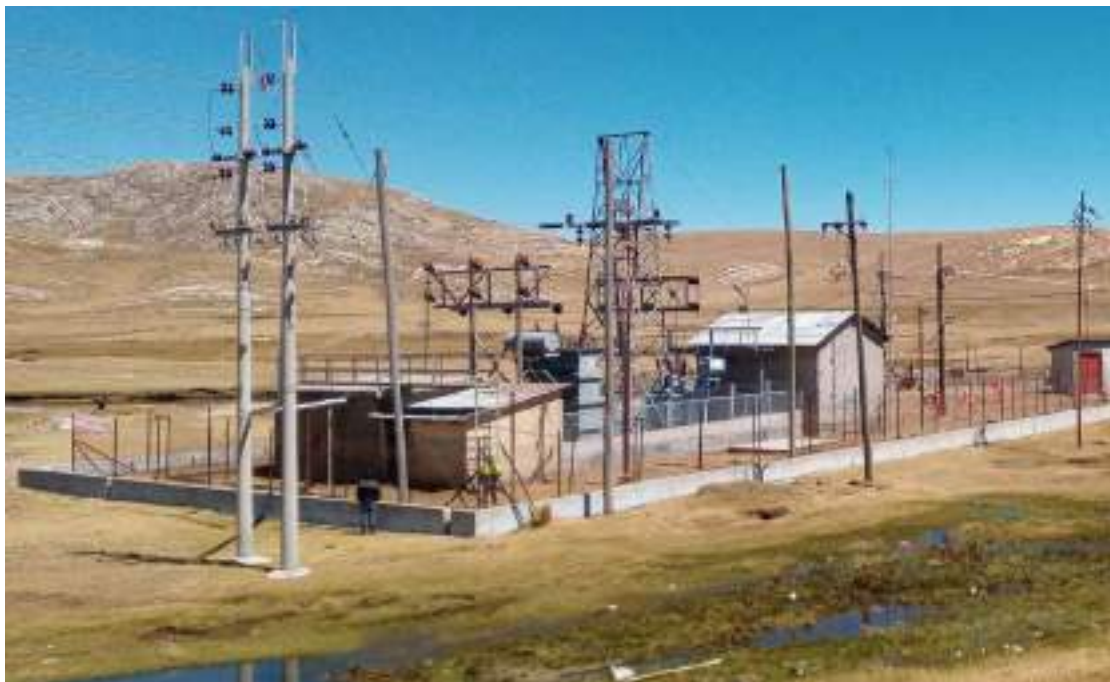
Fotografía 3.3-38 Vista actual del componente
