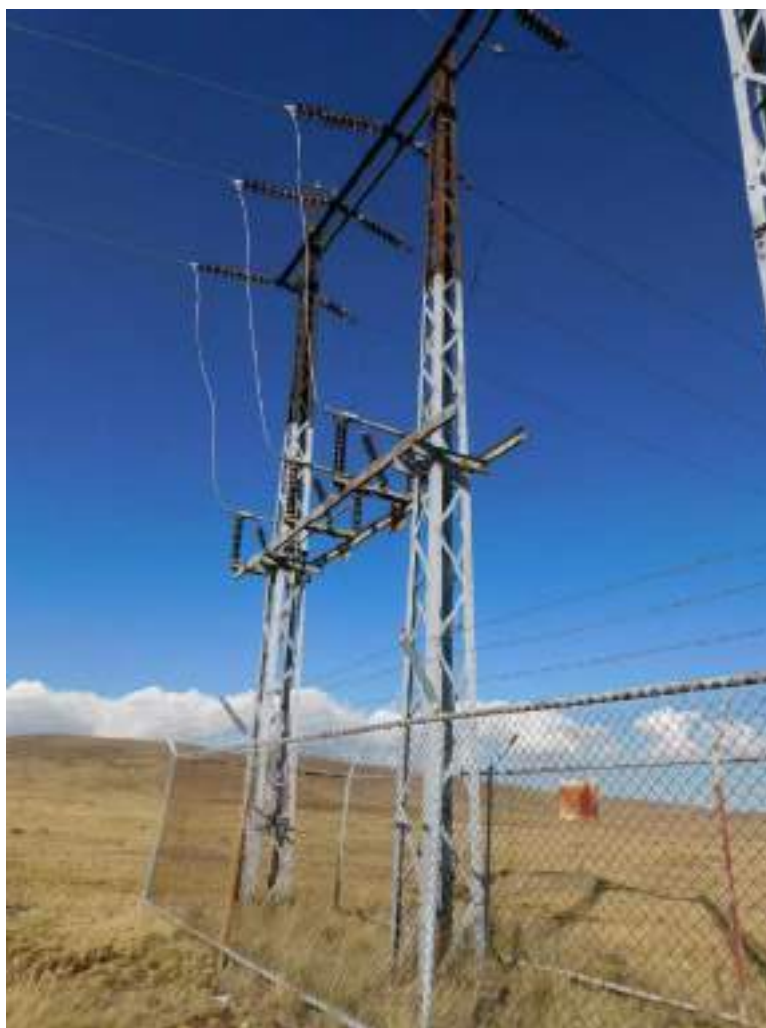
Fotografía 6-3 Seccionadores de línea de 50 kV hacia la S.E Vista Alegre
