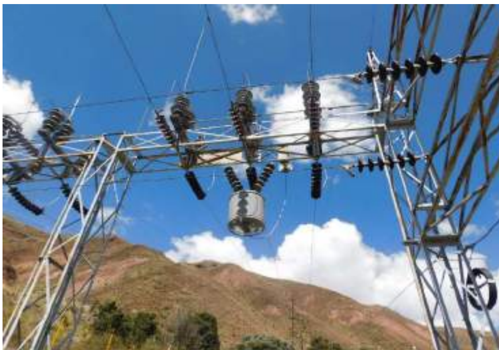
Fotografía 3-2 Estructura terminal de derivación hacia la S.E. Casapalca Norte
