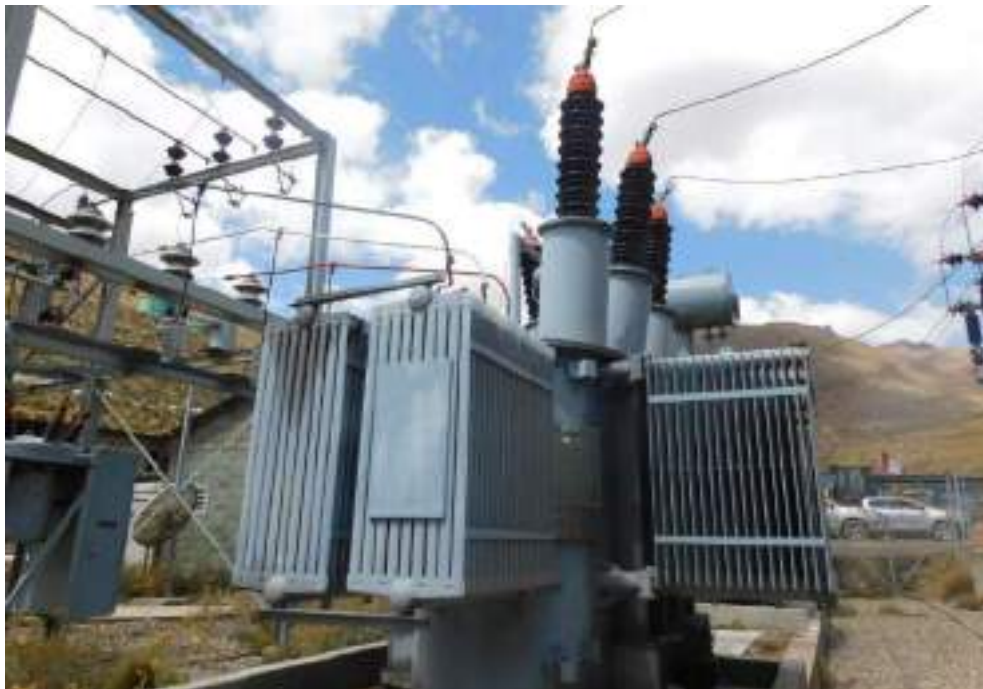
Fotografía 4-2 Transformador trifásico de potencia 6 MVA S.E. Chumpe 69/2.4 kV
