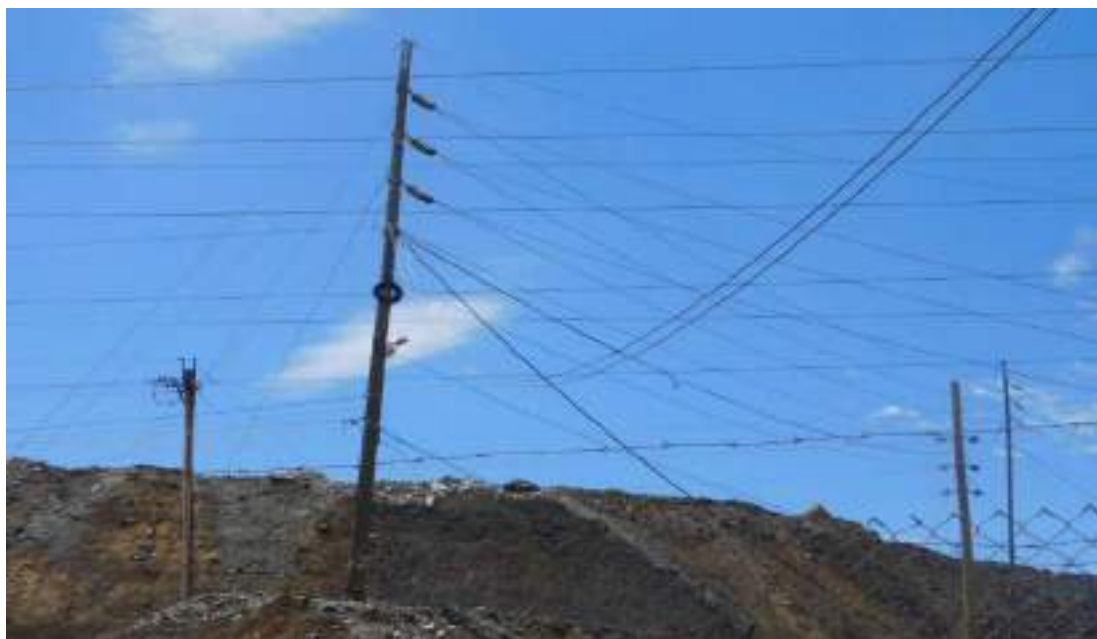
Fotografía 3-2 Pórtico de llegada de LT 50 kV simple terna a la S.E Excelsior desde la S.E Paragsha I.
