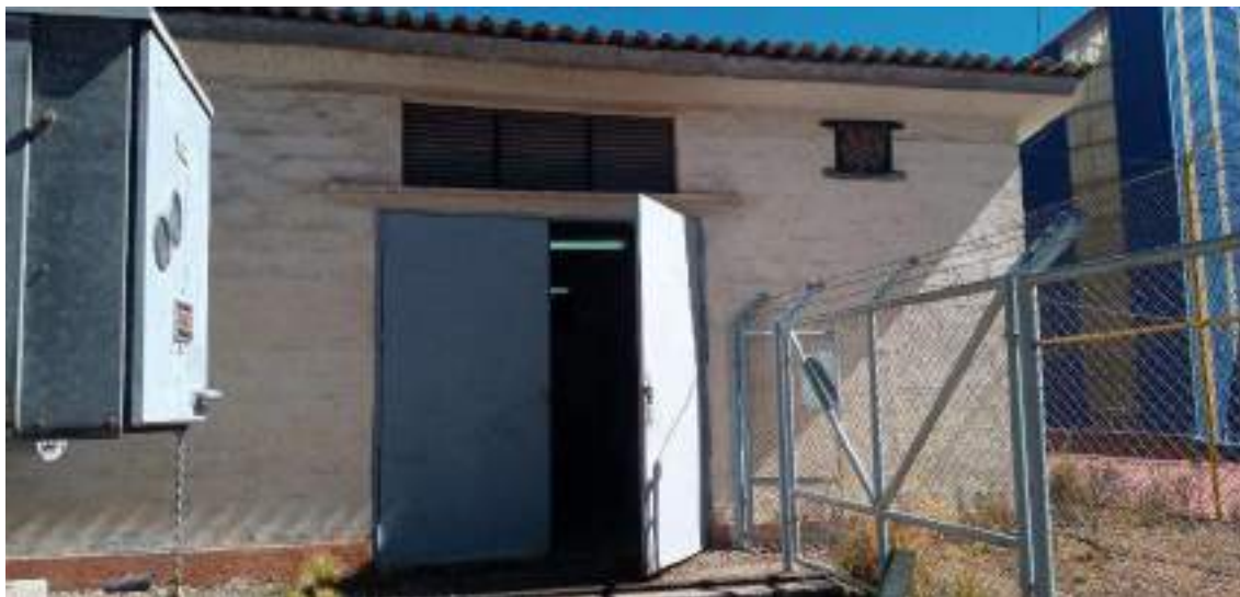
Fotografía 3.3-178 Vista exterior de Sala de Control
