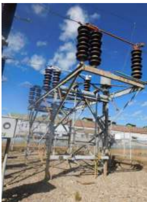
Fotografía 6-2 Seccionador de líneas 138 kV
