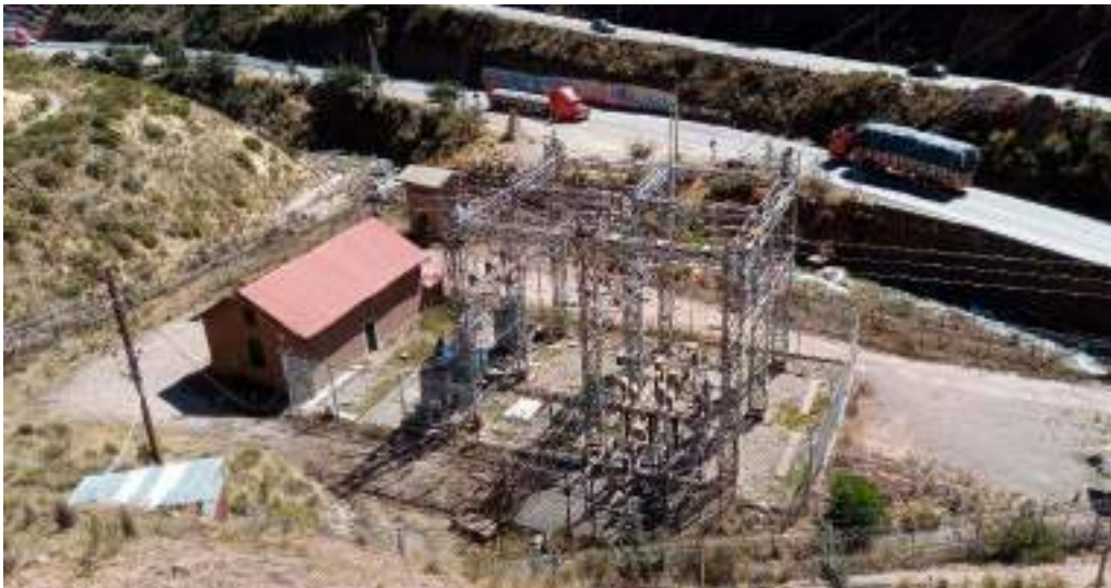
Fotografía 3.3-239 Vista actual 2 del componente
