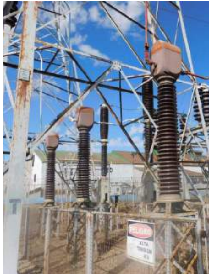
Fotografía 6-6 Interruptores de potencia en 50 kV.
