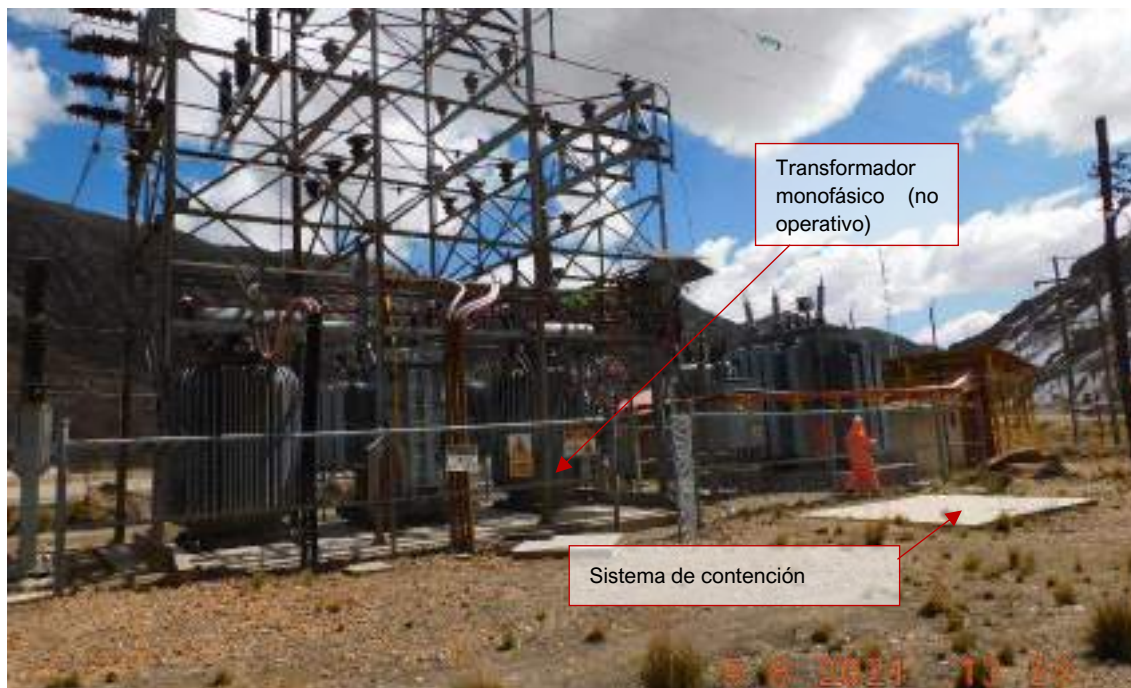
Fotografía 3.3-151 Vista del Buzón para recuperación de aceite.
