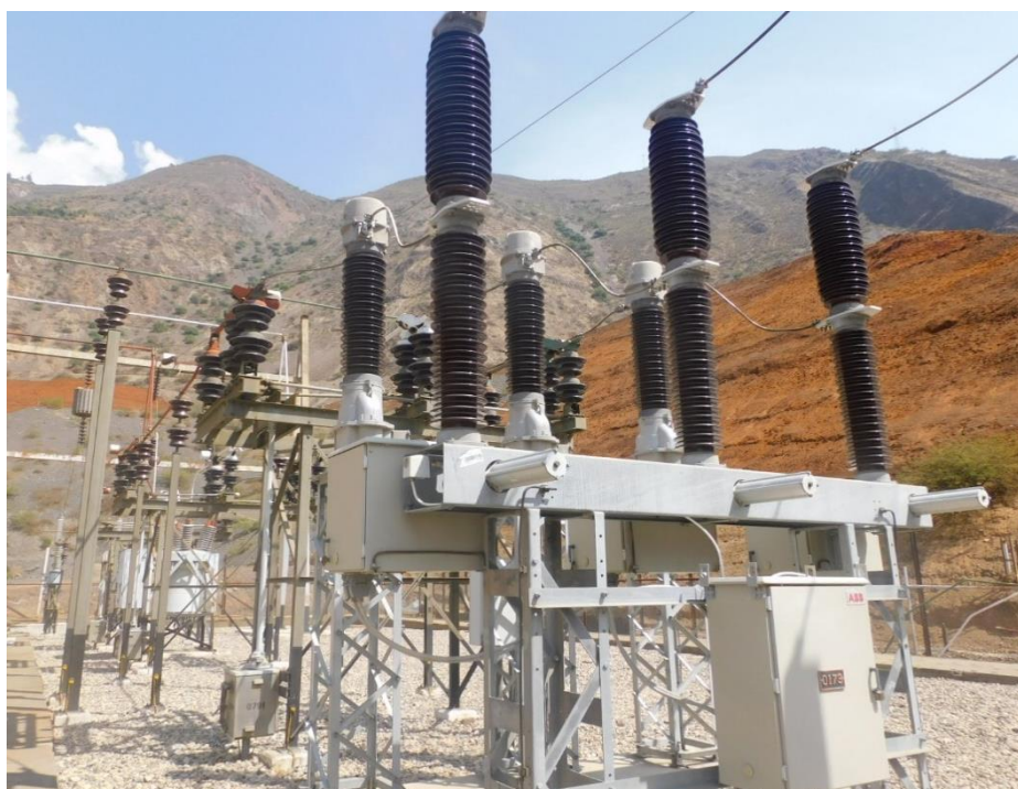
Fotografía 4-6 Interruptor de potencia en SF6 en 72.5 kV
