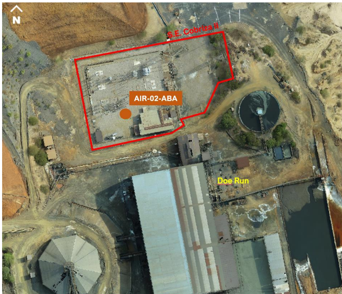
Figura 9.2-2 Estación de monitoreo de niveles de ruido ambiental – Cobriza II
