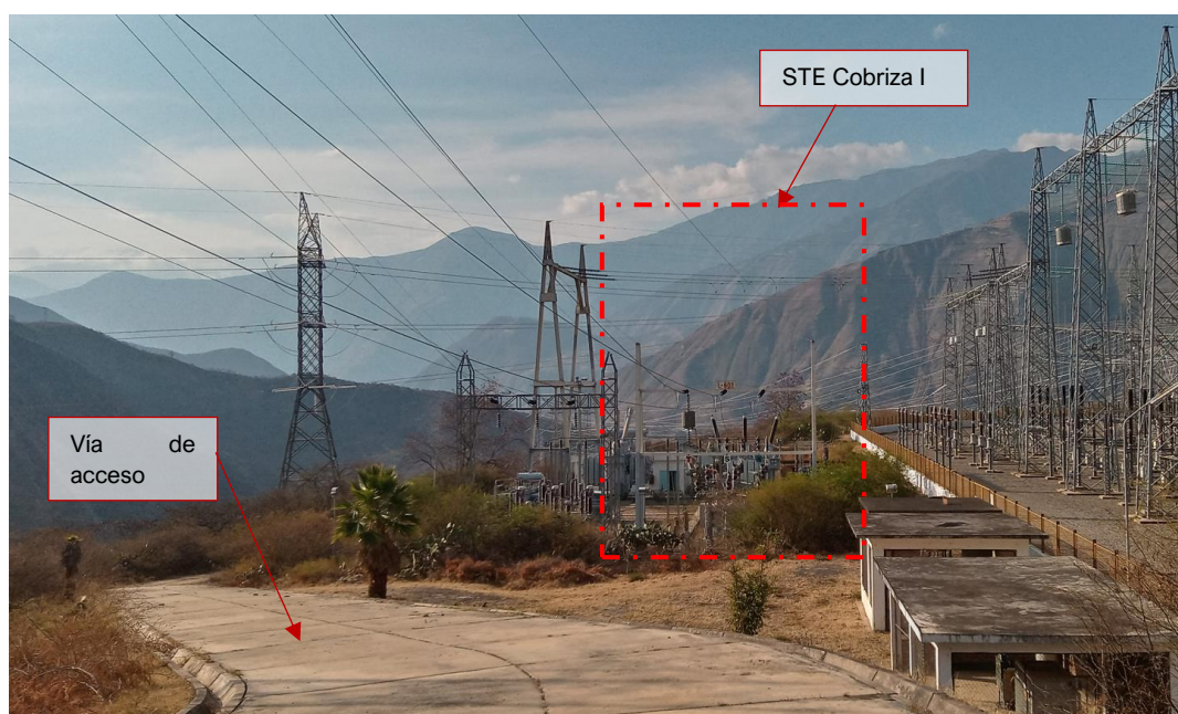
Fotografía 3.3-2 Vista actual 2 del componente
