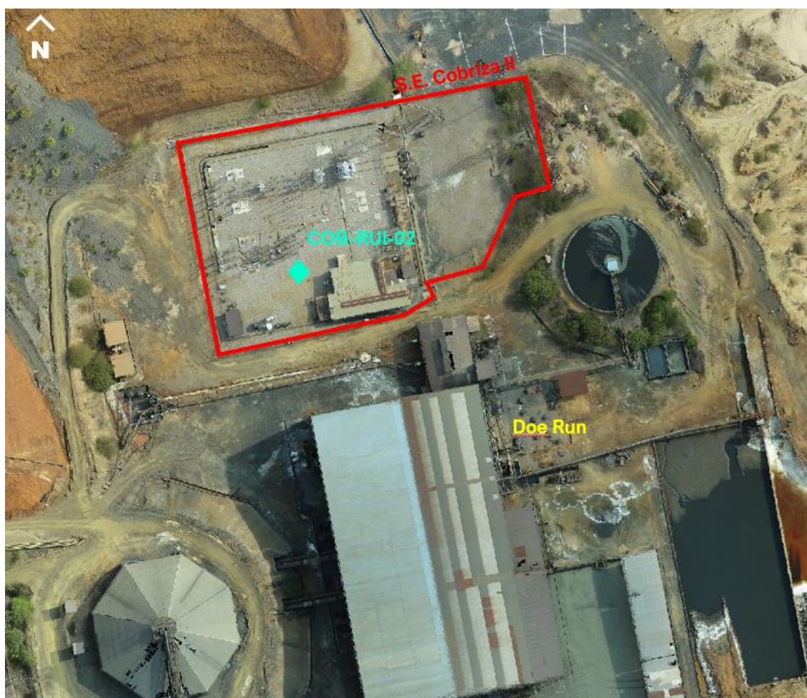
Figura 9.2-4 Estación de monitoreo de niveles de ruido ambiental – SET Cobriza II
