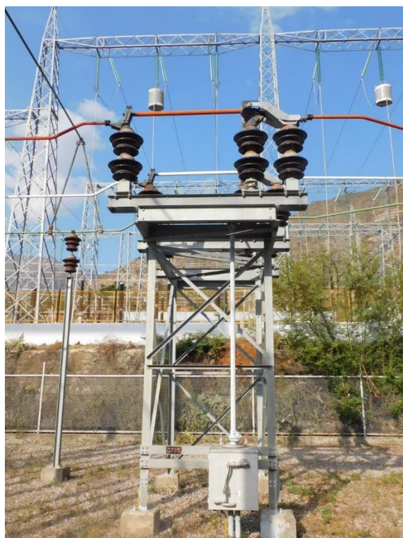
Fotografía 4-4 Seccionador de barra en 72.5 kV
