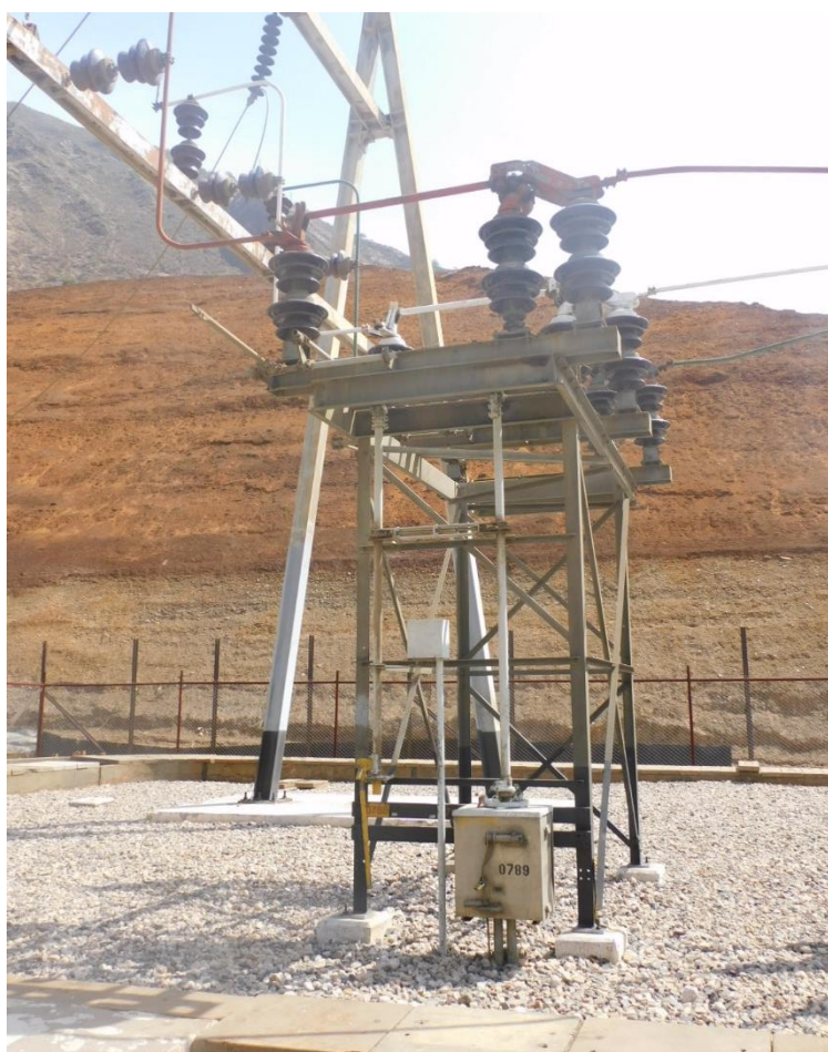
Fotografía 4-2 Seccionador de línea de 72.5 kV
