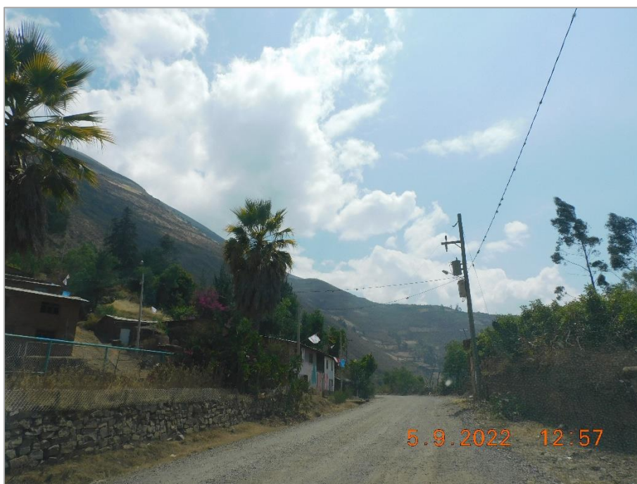
Fotografía 13: Vía departamental Emp. PE-3S D (Chonta), San Pedro de Coris-Dv. Cobriza, principal acceso a la localidad Machahuay, el cual presenta una superficie afirmada con material granular natural, aunque en estado regular debido a que algunos tramos presentan ligeros desgastes de la capa afirmada.
