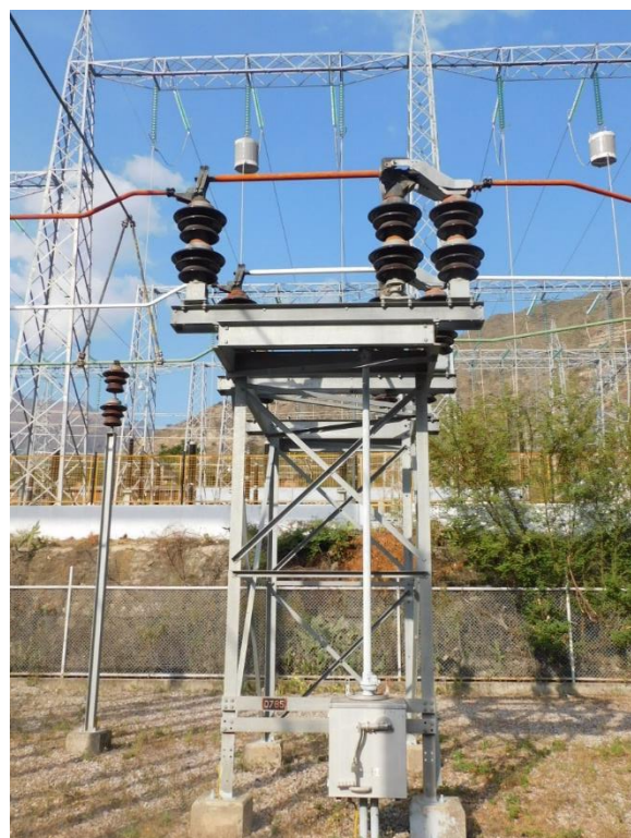
Fotografía 4-4 Seccionador de barra en 72.5 kV
