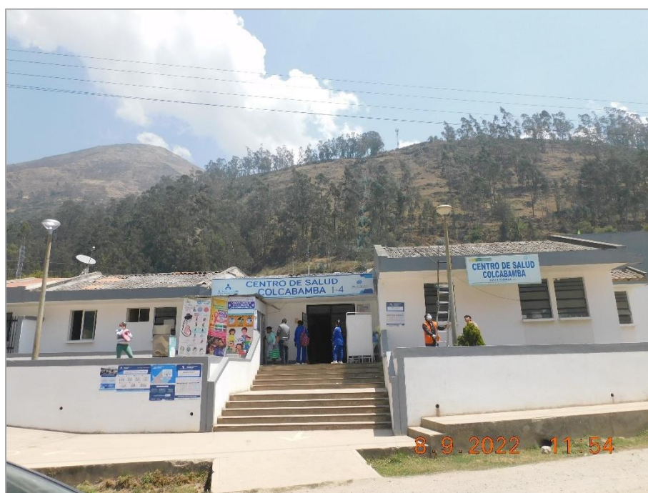
Fotografía 25: Centro de Salud Colcabamba (I-4), ubicado en el distrito del mismo nombre.
