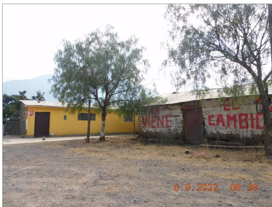
Fotografía 15: Localidad Machahuay (zona baja), se pudieron apreciar viviendas cuyo material de construcción predominante es la tapia.
