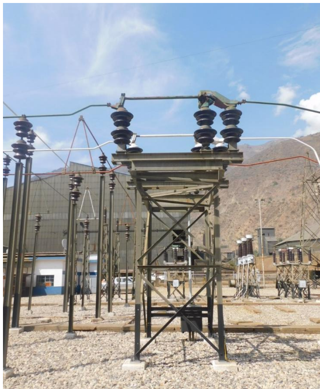
Fotografía 4-4 Seccionador de barra en 72.5 kV
