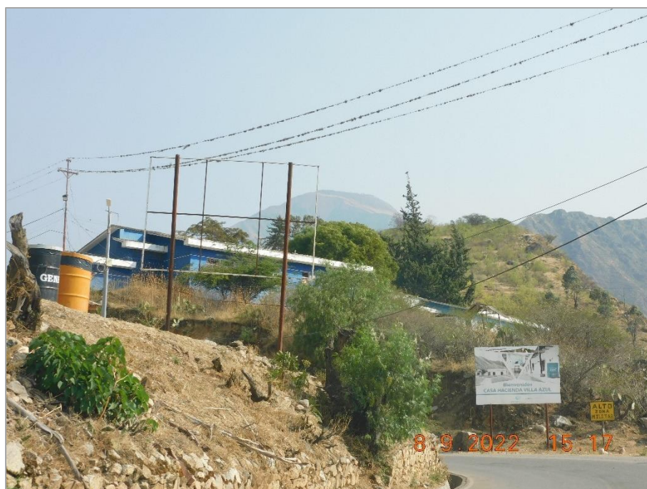
Fotografía 2: Casa Hacienda Villa Azul de la empresa Electroperú, la cual es utilizada para dar exposición sobre la historia de la generación de energía eléctrica en el Perú, según lo indicado por el personal de vigilancia de la empresa Electroperú.
