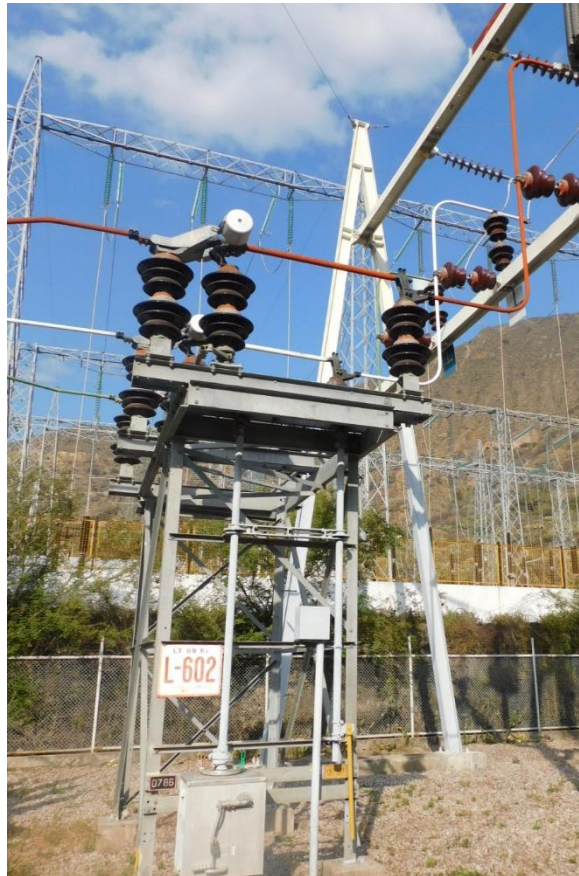
Fotografía 4-4 Seccionador de barra en 72.5 kV
