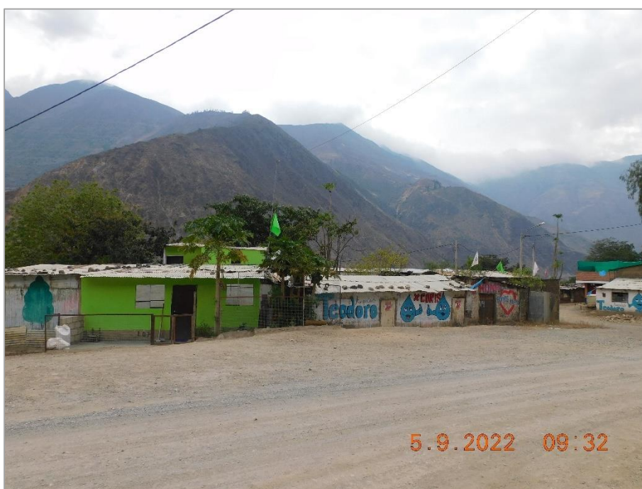
Fotografía 6: Anexo Expansión ubicado al sureste de la U. M. Expansión-Cobriza. Se puede apreciar que el material utilizado en las paredes de viviendas es, principalmente el tapial. Asimismo, se visualiza que los techos de las viviendas son de lamina, mayoritariamente.
