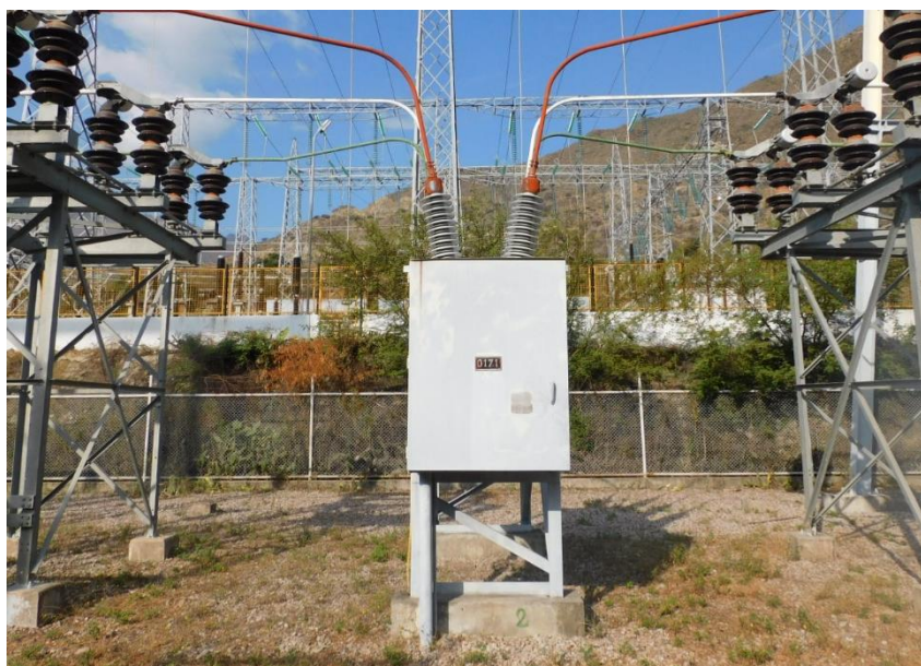
Fotografía 4-2 Interruptor de potencia de 72.5 kV
