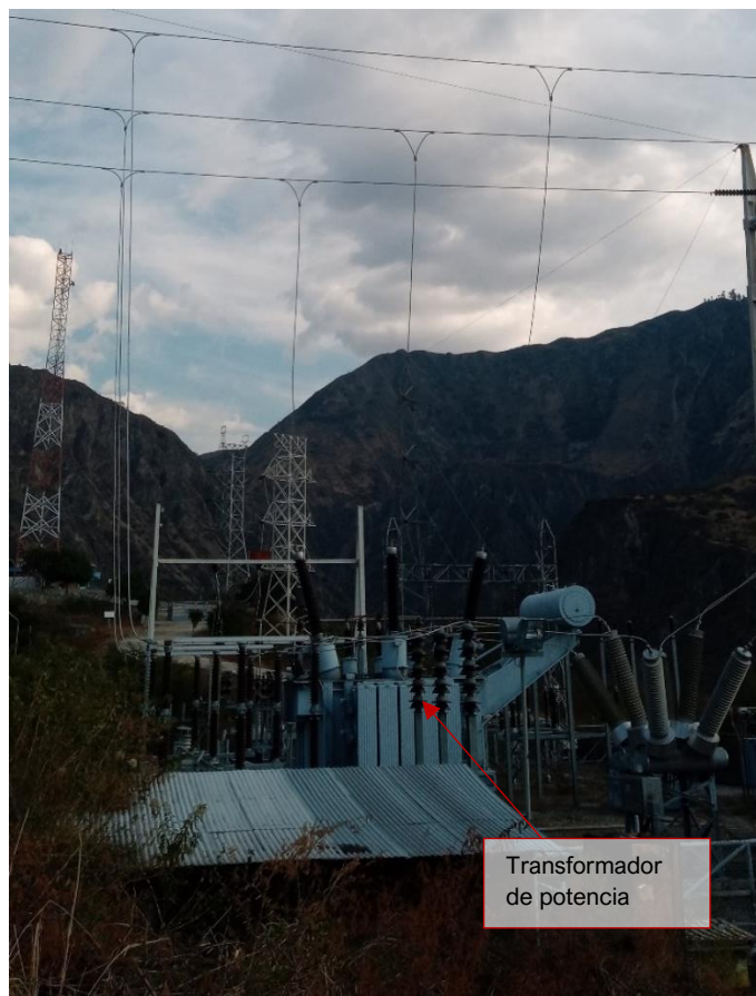
Fotografía 3.3-1 Vista actual 1 del componente
