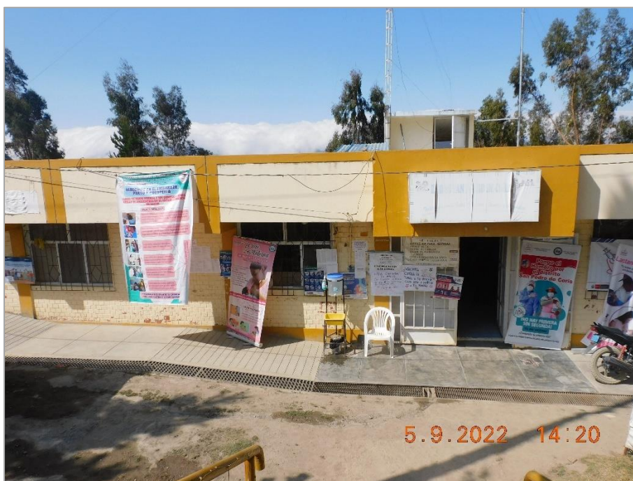
Fotografía 33: Centro de Salud San Pedro de Coris, ubicado en el distrito del mismo nombre.
