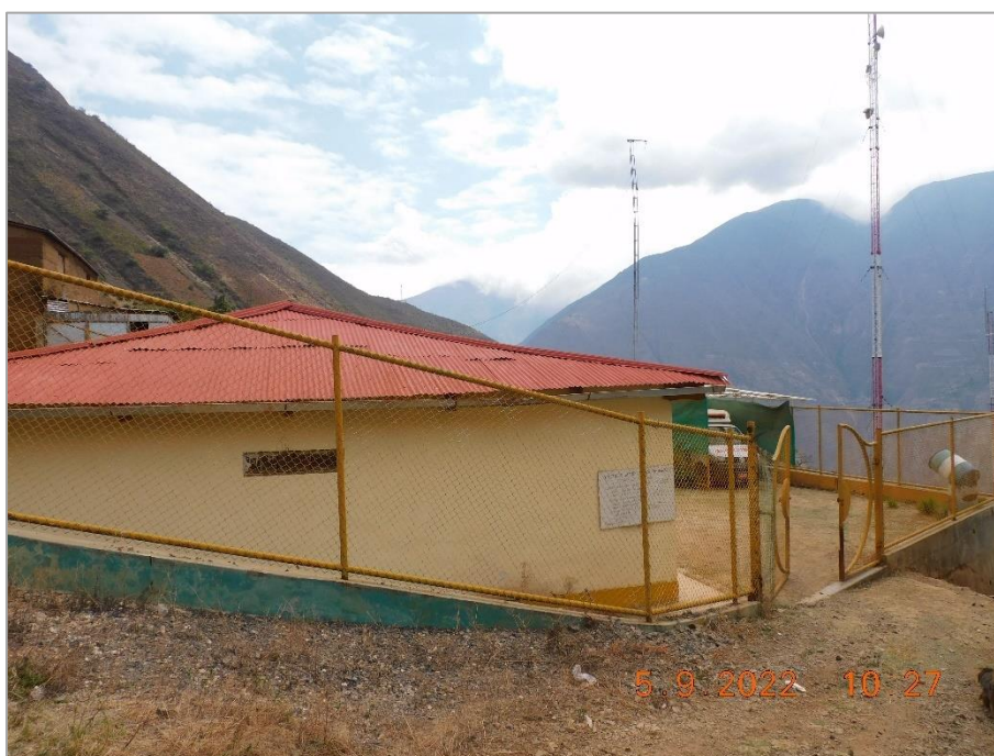
Fotografía 17: Puesto de Salud Cobriza-Machahuay, ubicado en la localidad Machahuay.
