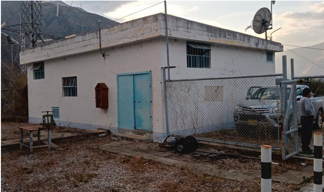
Fotografía 3.3-10 Vista exterior de Sala de Control
