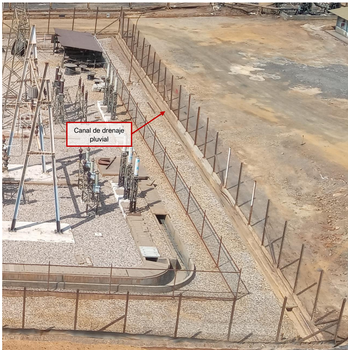
Fotografía 3.3-30 Vista de canal de drenaje pluvial abierto
