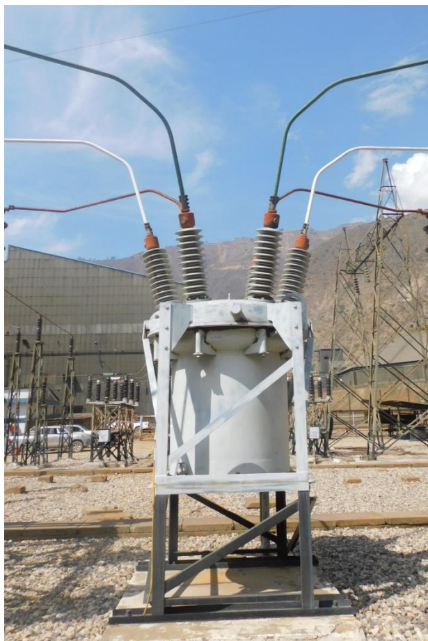
Fotografía 4-6 Interruptor de potencia en SF6 en 72.5 kV
