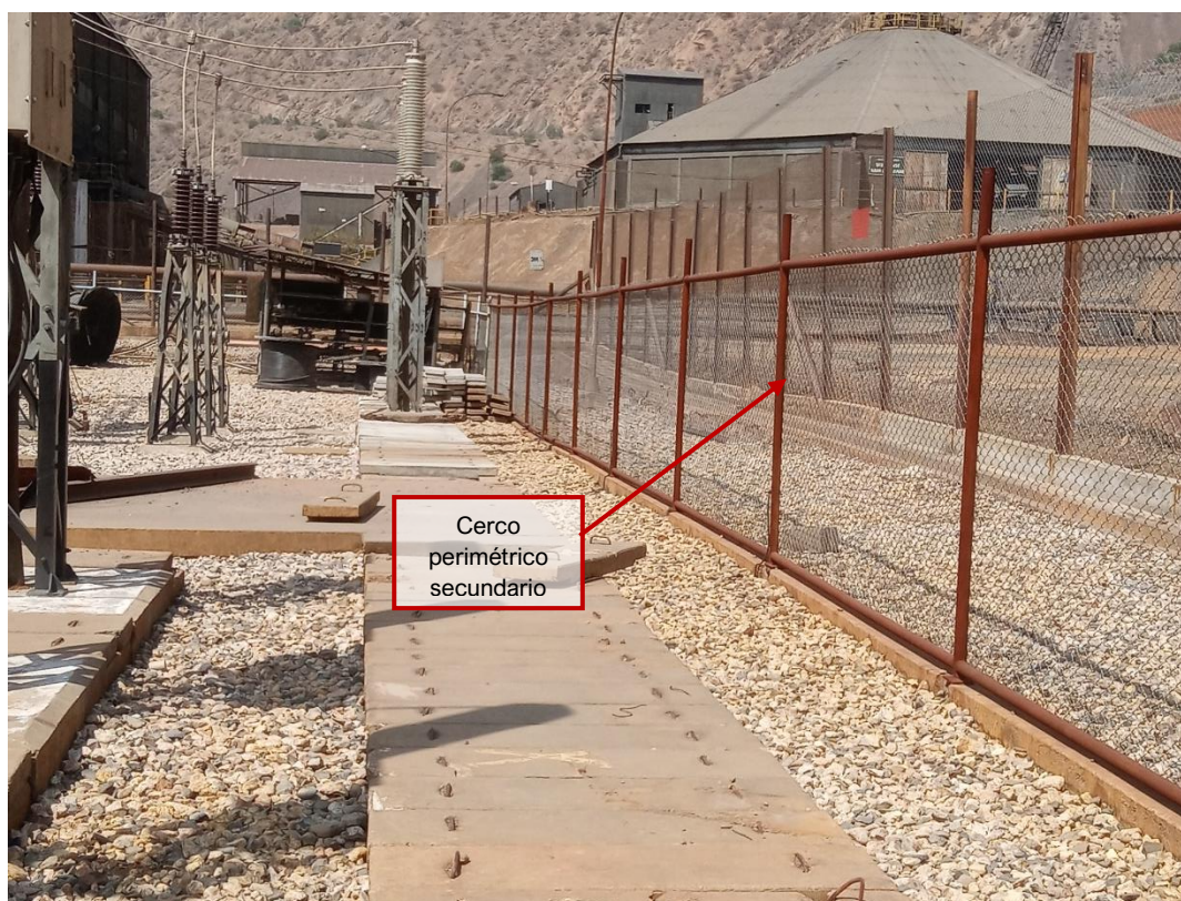
Fotografía 3.3-38 Vista de Cerco perimétrico secundario
