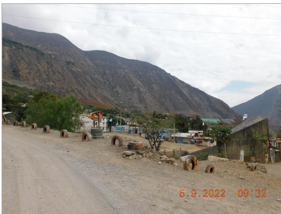
Fotografía 7: Anexo Expansión, se puede observar que el acceso al poblado es mediante una vía sin afirmar, de estado regular y con un ancho aproximado de 5 metros, la cual se conecta con la vía provincial Emp. PE-3S (Chonta), San Pedro de Coris-Dv. Cobriza.
