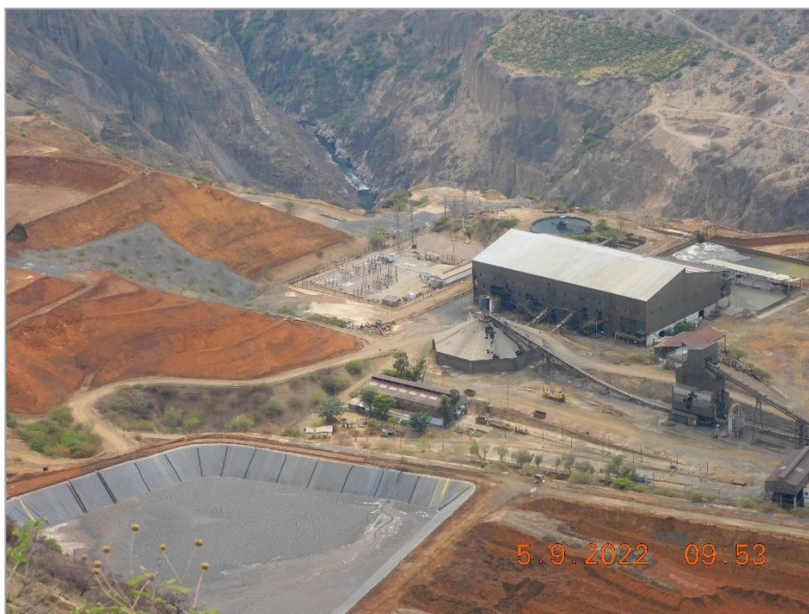
Fotografía 5: AIP Shaqsha 2 (subestación eléctrica Cobriza 2), se ubica dentro de la unidad minera Cobriza de la empresa Doe Run, no registrándose poblaciones en su entorno inmediato o a menos de 200 metros del área de influencia.
