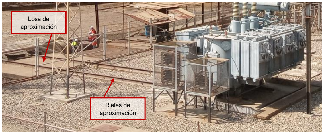
Fotografía 3.3-22 Vista de Rieles de aproximación
