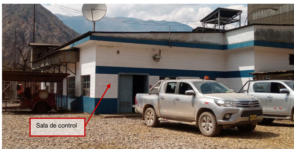
Fotografía 3.3-28 Vista Exterior de Sala de Control
