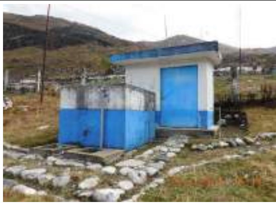
Fotografía 6.2-27 Plantas de tratamiento de agua potable (PTAP) (PAD-CHY-10d)
