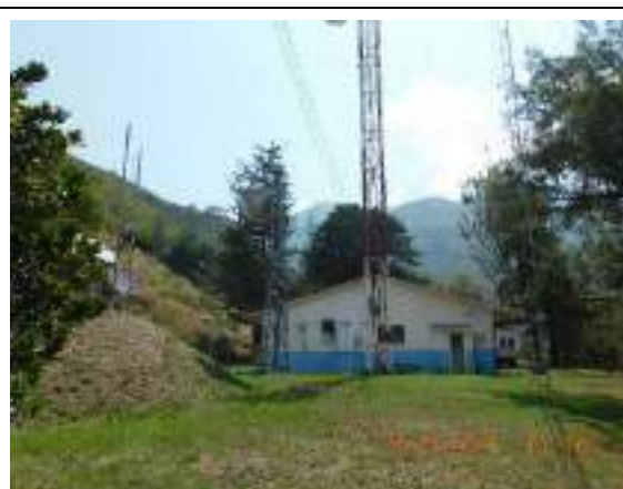
Fotografía 6.2-15 Estaciones de telecomunicación 2 (PAD-CHY-07b)
