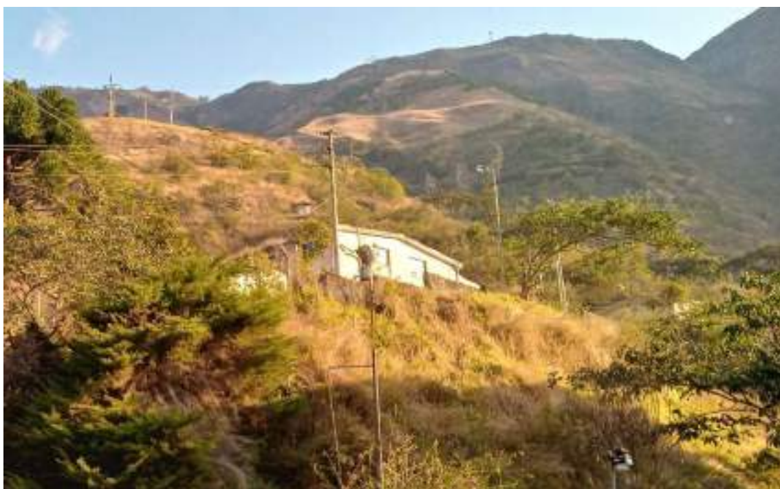
Fotografía 3-64 Estado actual del componente línea de media tensión
