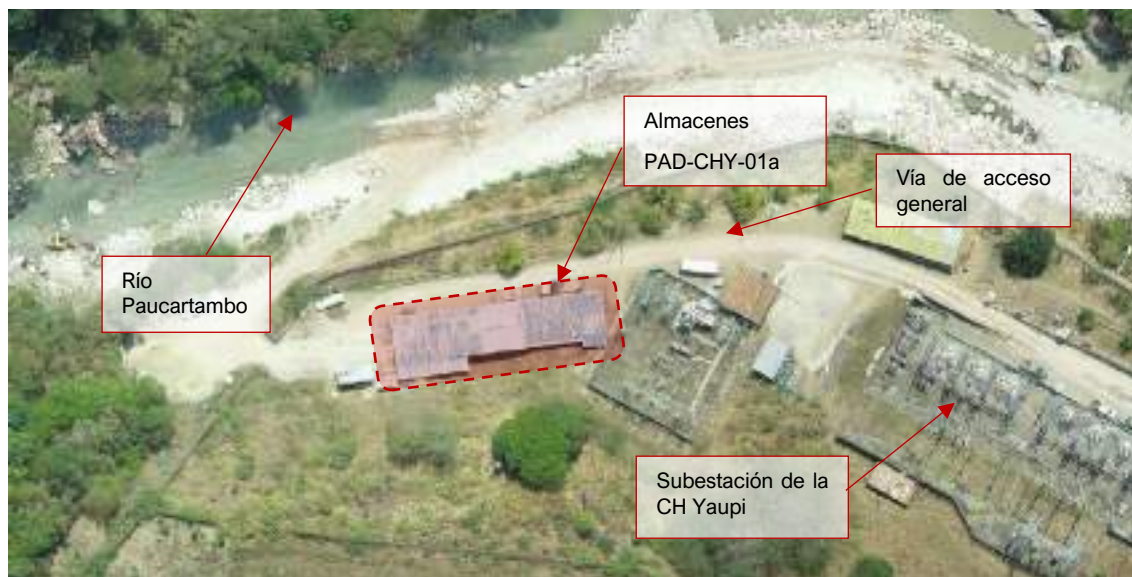
Figura 3-4 Ubicación de almacenes (en casa de máquinas de la CH Yaupi)
