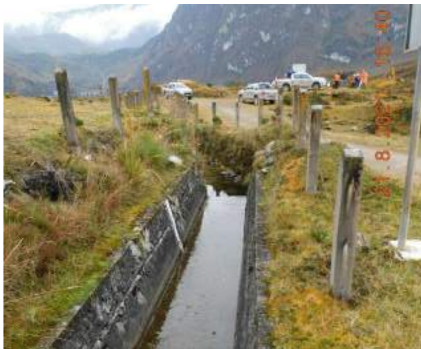
Fotografía 3-21 Sección canal tramo final
