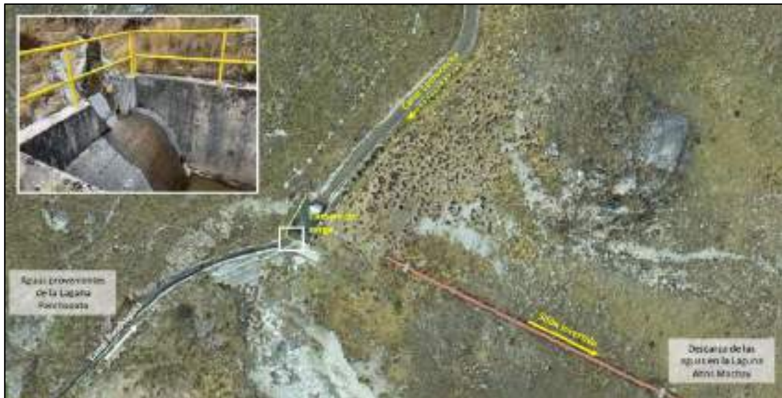
Figura 5-3 Llegada de las aguas de la laguna Lechecochoa a la cámara de carga – Zona I
