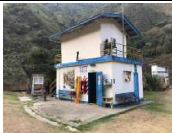
Fotografía 6.2-6 Caseta de control (PAD-CHY-05)
