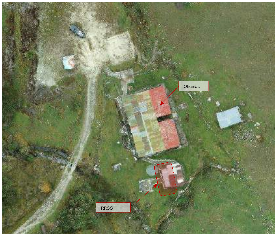
Figura 3-146 Ubicación del punto de acopio de residuos sólidos
