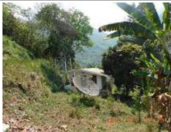
Fotografía 6.2-8 Estaciones de telecomunicación 1 (PAD-CHY-07a)
