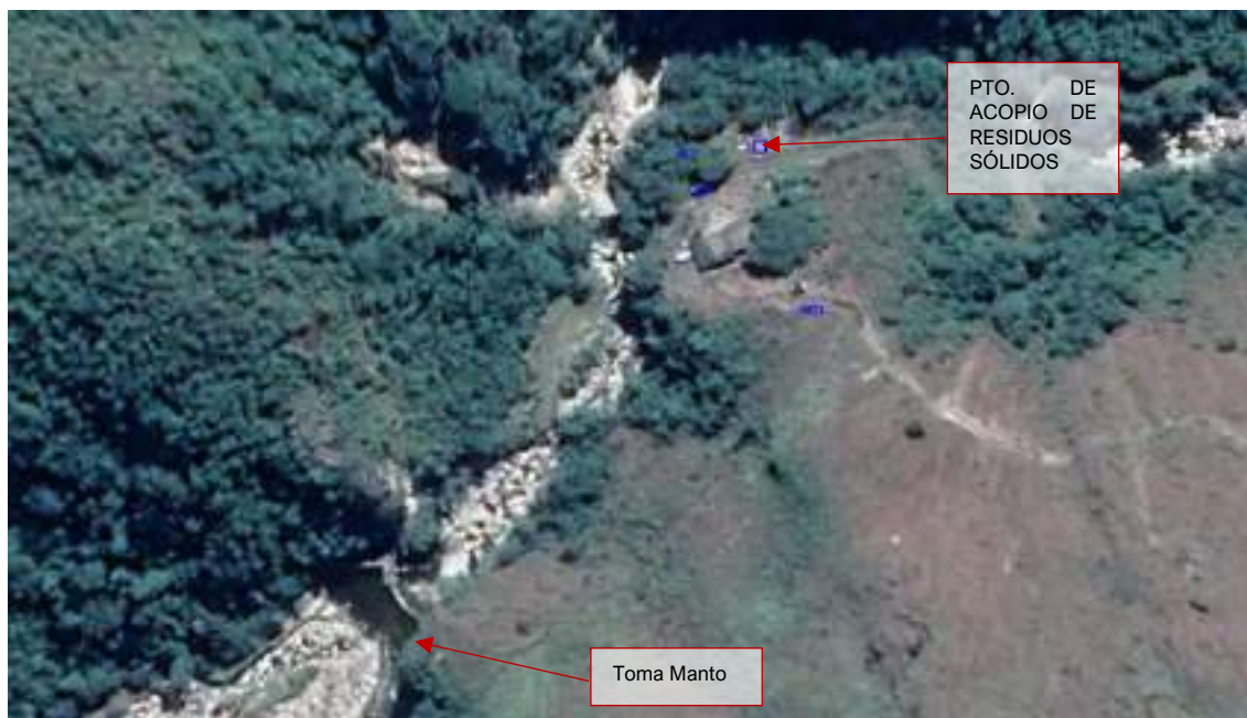
Figura 3-96 Vista planta de ubicación del componente punto de acopio de residuos sólidos
