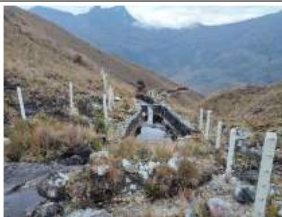
Fotografía 6.2-5 Canal Ushapata (PAD-CHY-04)
