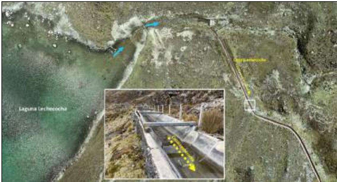
Figura 5-2 Conducción de las aguas de la laguna Lechecocha – Zona I
