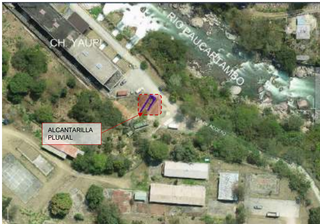
Figura 3-24 Ubicación de alcantarilla pluvial (casa de máquinas de la CH Yaupi)
