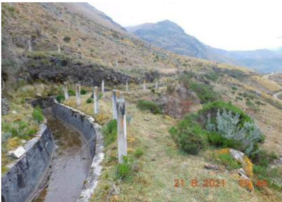
Fotografía 3-22 Sección típica del canal Ushapata
