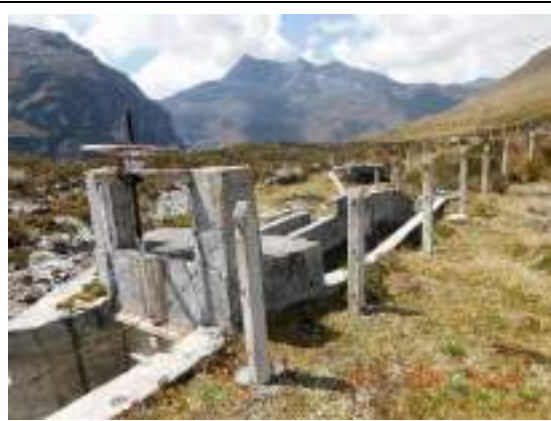
Fotografía 6.2-8 Canal Lechecochoa (PAD-CHY-03a)
