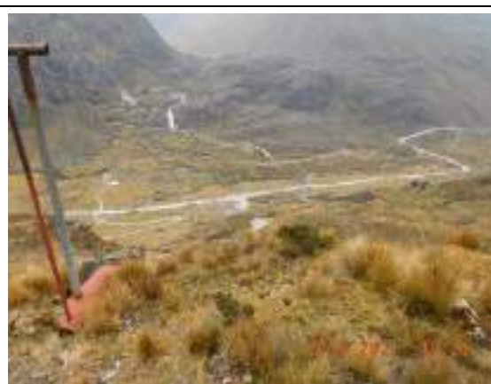
Fotografía 6.2-10 Sifón invertido (PAD-CHY-03c)
