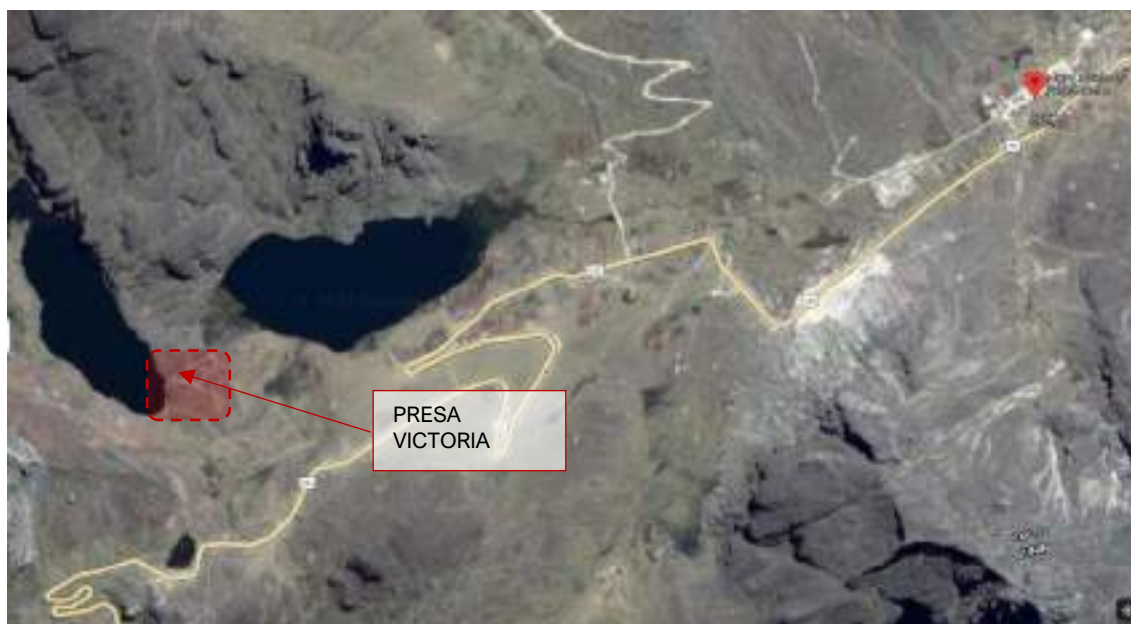
Figura 3-45 Ubicación de la Presa Victoria
