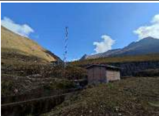
Fotografía 6.2-41 Estaciones de telecomunicación (PAD-HGB-01)
