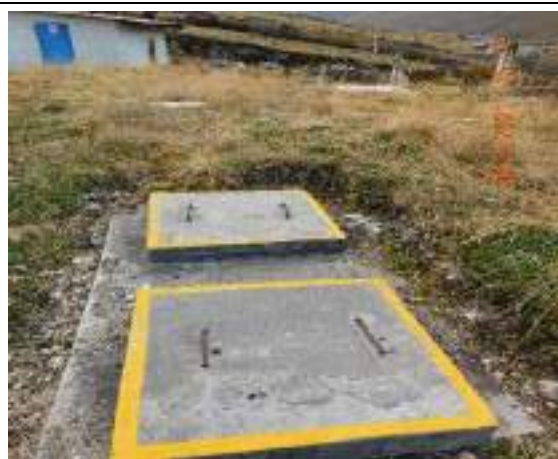
Fotografía 6.2-23 Pozos sépticos 4 (PAD-CHY-09d)
