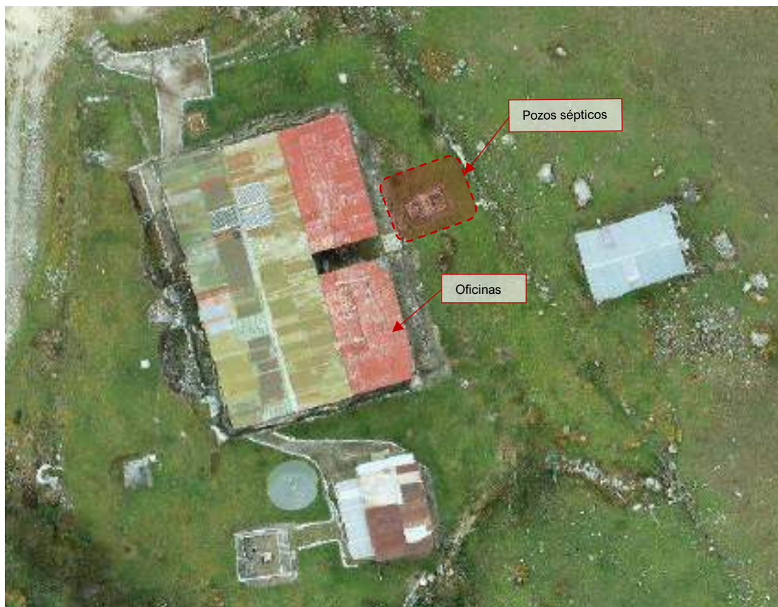
Figura 3-139 Ubicación del pozo séptico
