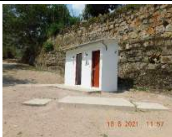
Fotografía 6.2-10 Pozos sépticos 1 (PAD-CHY-09a)
