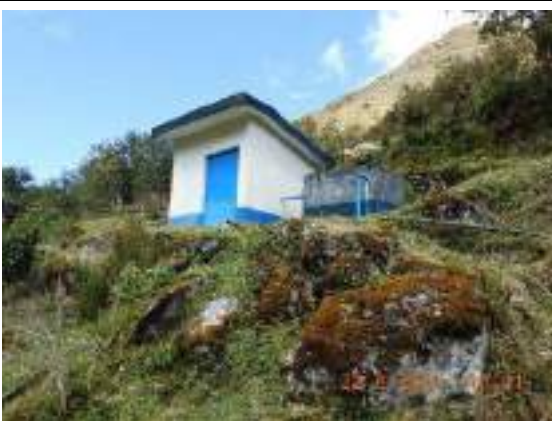
Fotografía 6.2-43 Plantas de tratamiento de agua potable (PTAP) (PAD-HGB-03)
