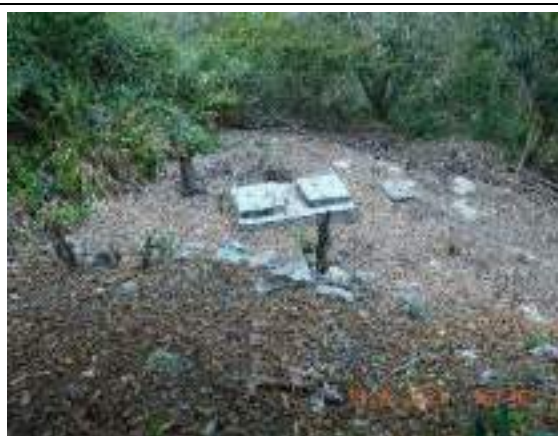
Fotografía 6.2-21 Pozos sépticos 2 (PAD-CHY-09b)
