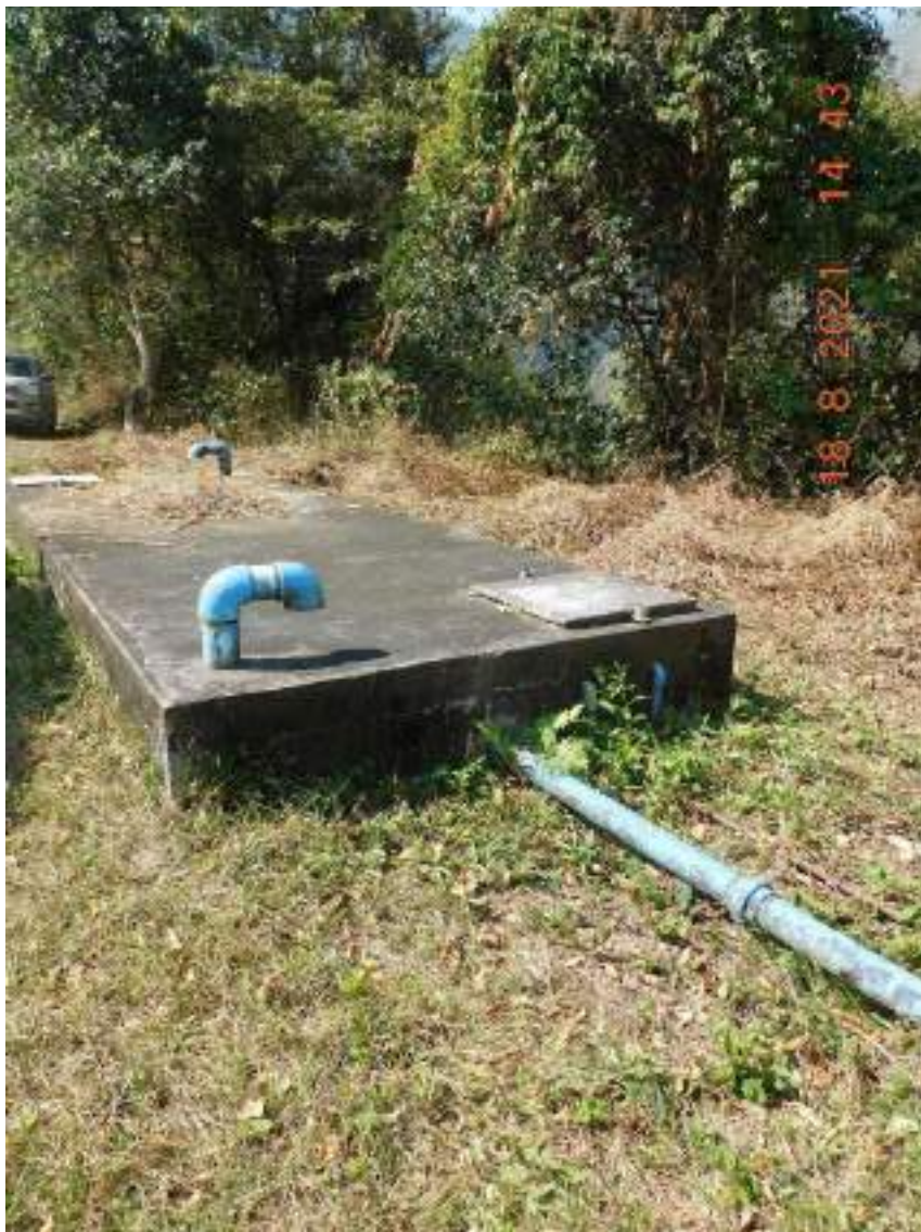
Fotografía 3-44 Estado actual del reservorio de almacenamiento
