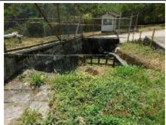
Fotografía 6.2-4 Alcantarilla pluvial (PAD-CHY-02)
