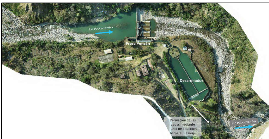
Figura 5-7 Llegada de las aguas del río Paucartambo a la presa Yuncán
