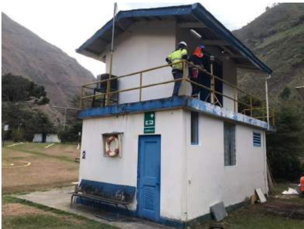
Fotografía 3-24 Vista exterior del componente caseta de control
