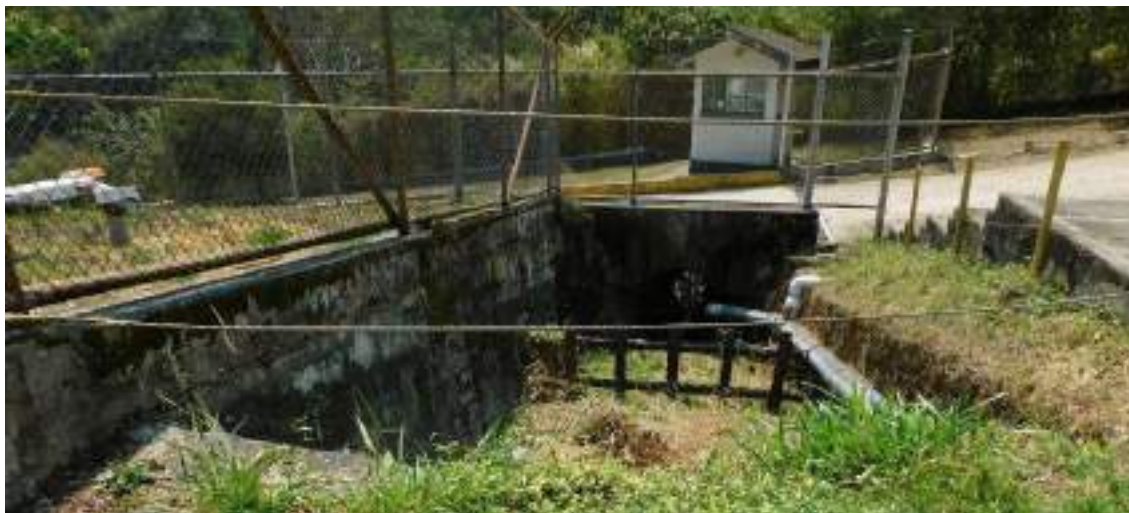
Fotografía 3-14 Vista actual de la alcantarilla pluvial
