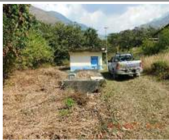
Fotografía 6.2-24 Plantas de tratamiento de agua potable (PTAP) (PAD-CHY-10a)
