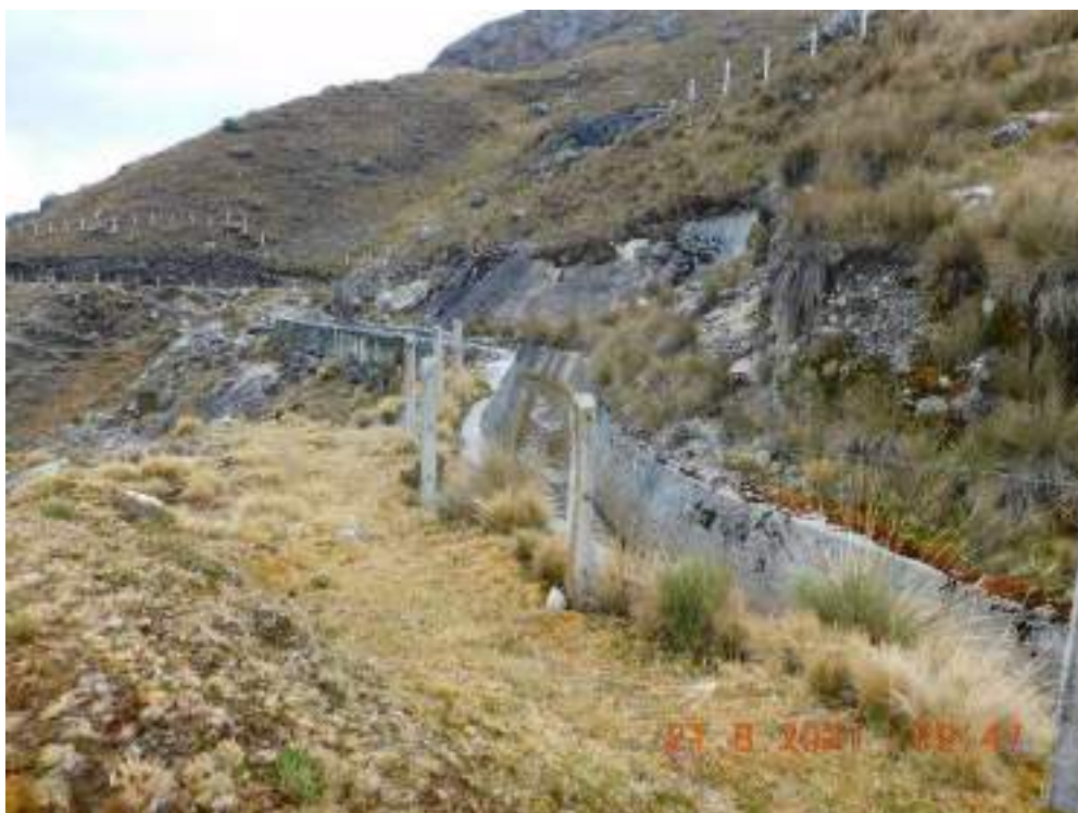
Fotografía 3-16 Sección del canal Lechecochoa
