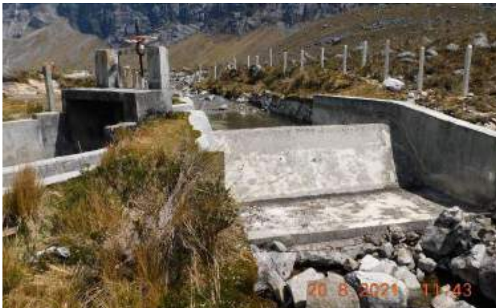
Fotografía 3-15 Captación y compuerta de apertura del canal
