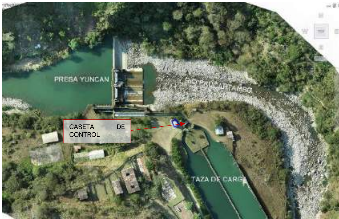
Figura 3-42 Ubicación de la caseta de control (Toma Yuncán)
