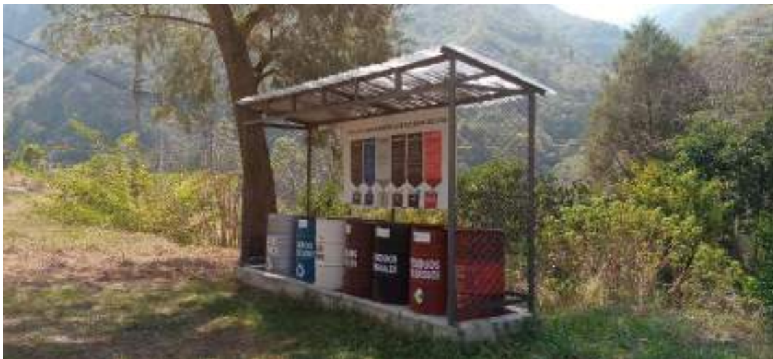
Fotografía 3-52 Estado actual del componente punto de acopio de residuos sólidos
