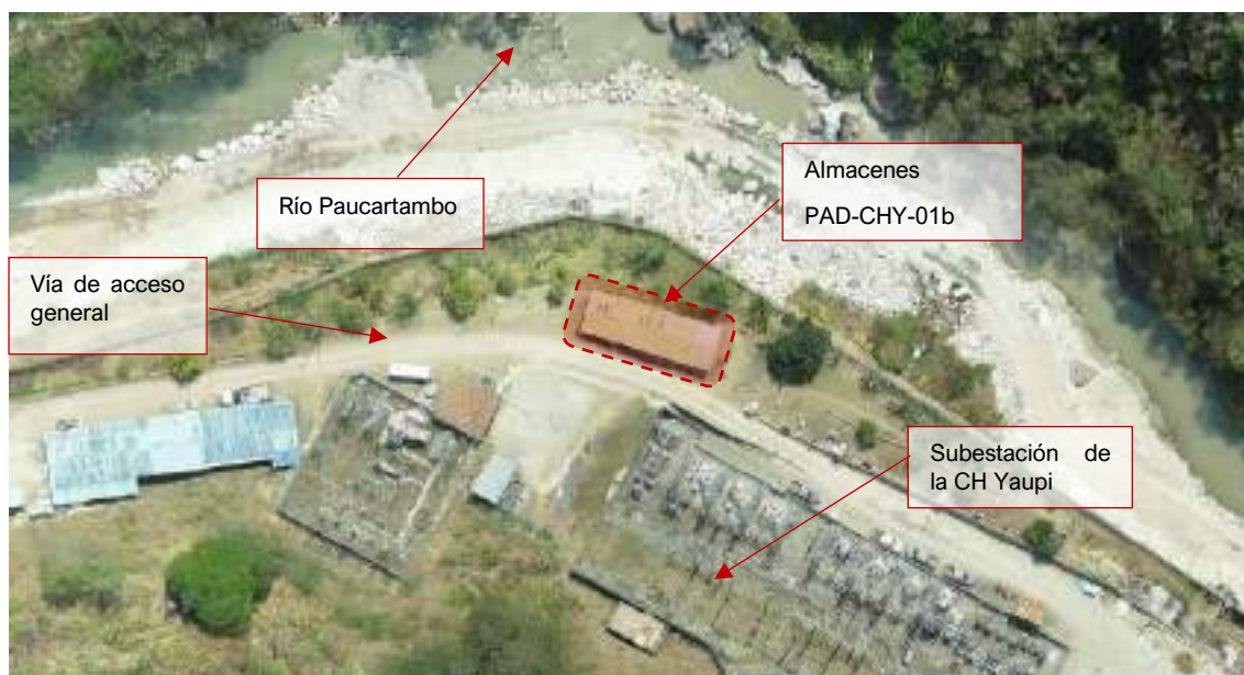
Figura 3-5 Ubicación de almacenes (en casa de máquinas de la CH Yaupi)
