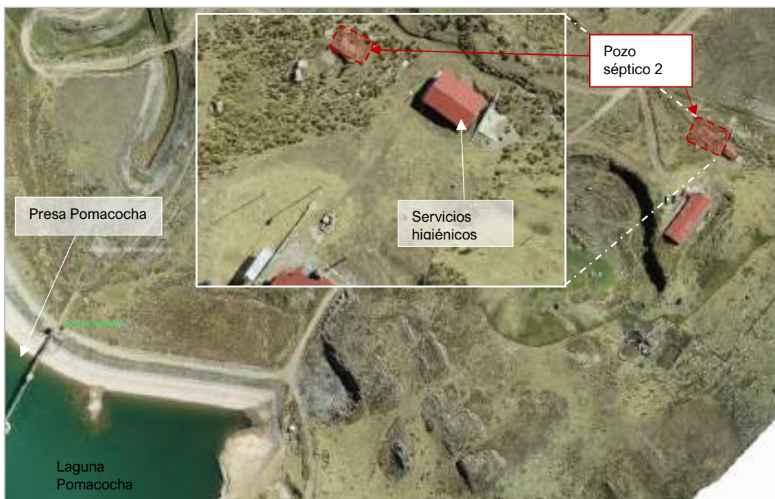
Figura 3-26 Ubicación del componente pozo séptico 2 (en campamento Pomacocha)
