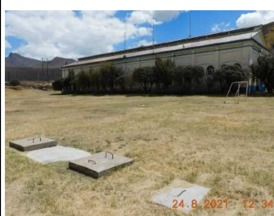
Fotografía 6.2-4 Pozos sépticos 1 (PAD-CHP-06a)
