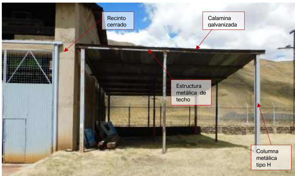
Fotografía 3-6 Vista frontal del almacén 3
