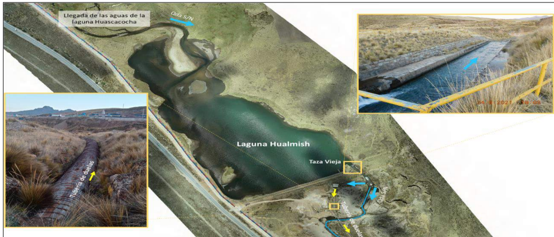
Figura 5-2 Derivación de las aguas de Taza Vieja por tubería de duelas
