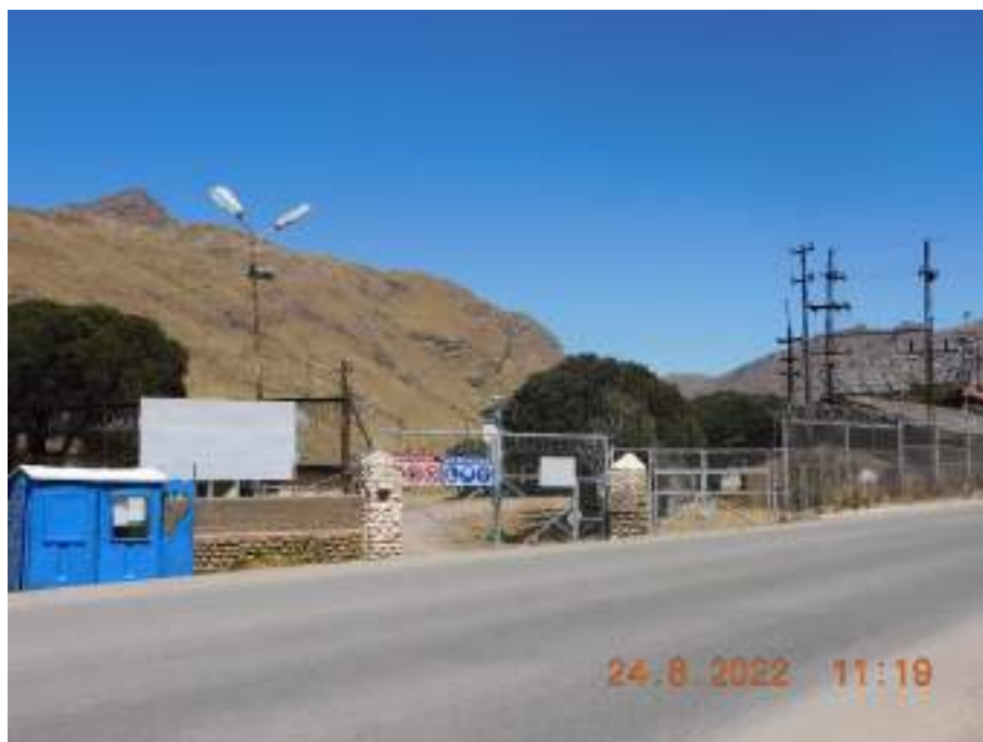
Fotografía 6: Vía departamental JU – 102, la cual se desprende de un tramo de la Carretera Central, PE – 22, que parte del distrito de La Oroya en dirección al distrito de Morococha. Además, la ruta JU – 102 es una vía asfaltada y se encuentra en estado regular.
