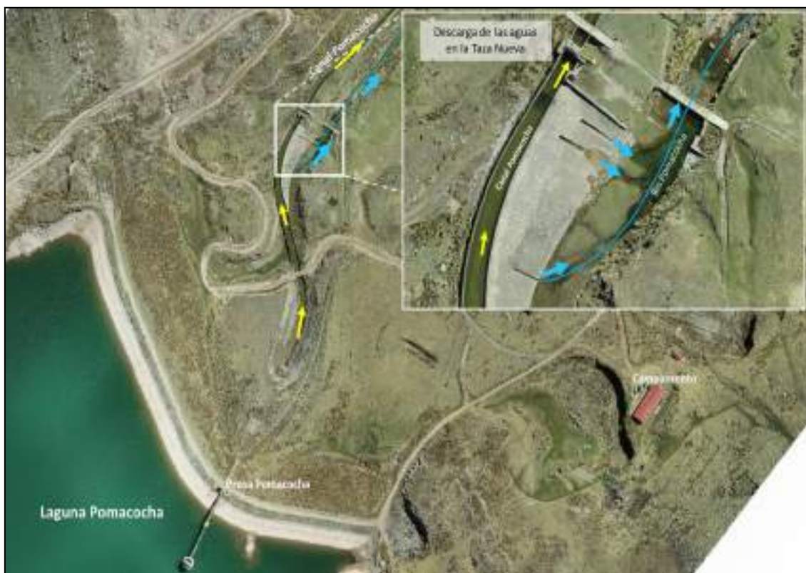
Figura 5-4 Derivación de las aguas captadas de la laguna Pomacocha por canal hacia la Taza nueva
