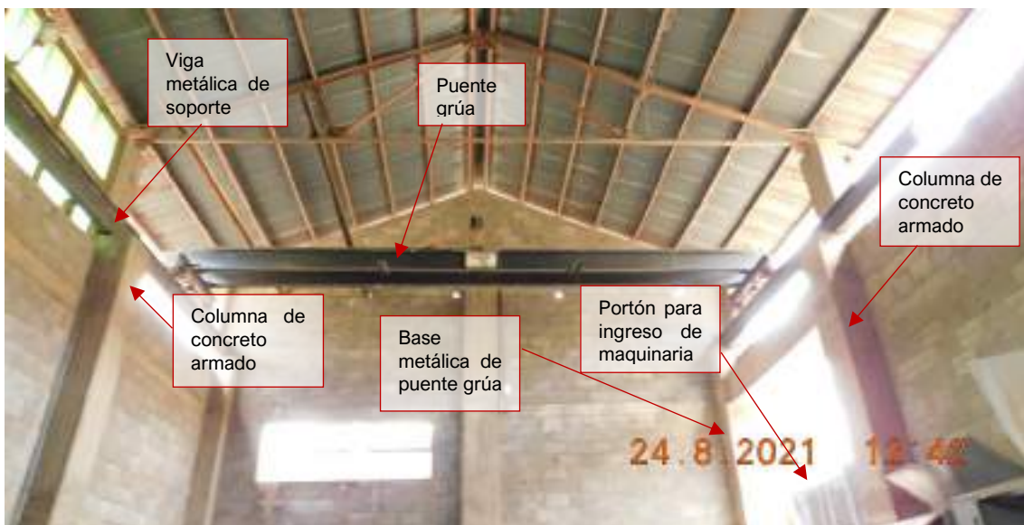
Fotografía 3-4 Vista puente grúa en sector interior de ambiente Almacén 2
