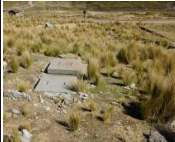
Fotografía 6.2-30 Pozos sépticos 2 (PAD-CHP-06b)
