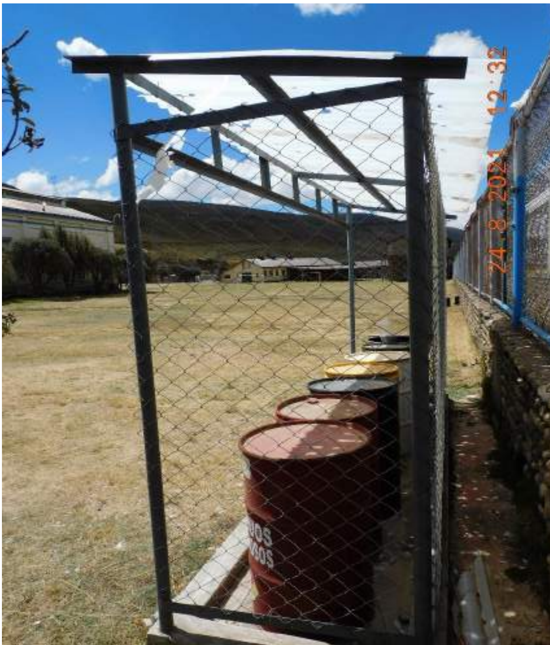
Fotografía 3-26 Vista de estructura metálica del componente punto de acopio de residuos sólidos 1
