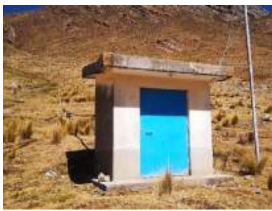
Fotografía 6.2-7 Plantas de tratamiento de agua potable (PTAP) (PAD-CHP-05a)
