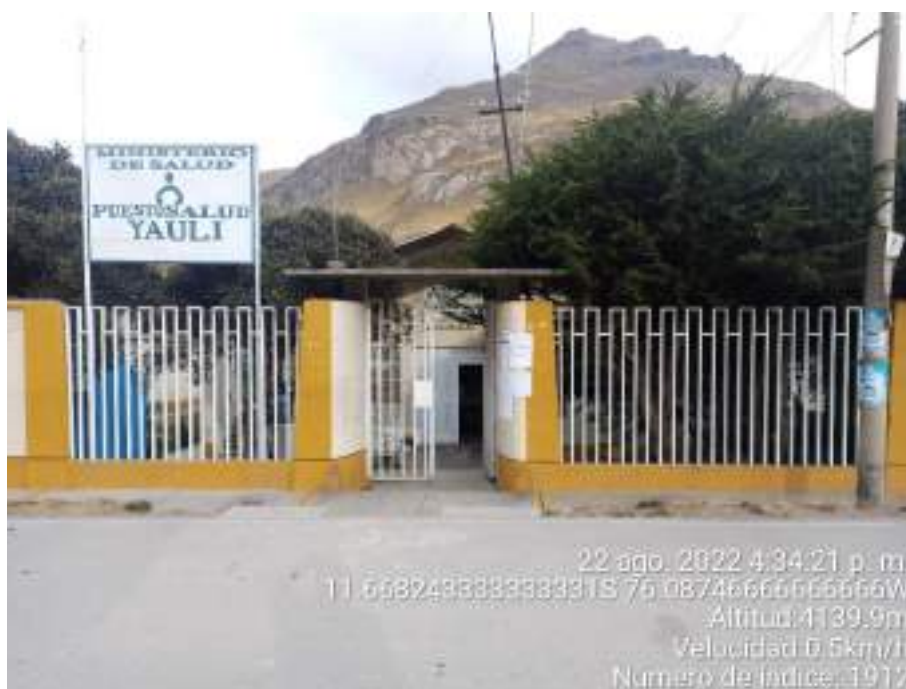
Fotografía 42: Puesto de Salud Yauli del Ministerio de Salud ubicado en el distrito de Yauli, sede distrital de la zona CH Oroya 1.
