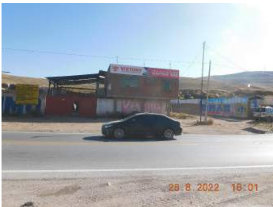
Fotografía 21: Vía nacional PE – 22, Carretera Central, se observó el estado regular en el que se encuentra este tramo de la vía nacional, además de identificar la presencia de actividades de transporte desarrolladas por automóviles colectivos, principalmente.
