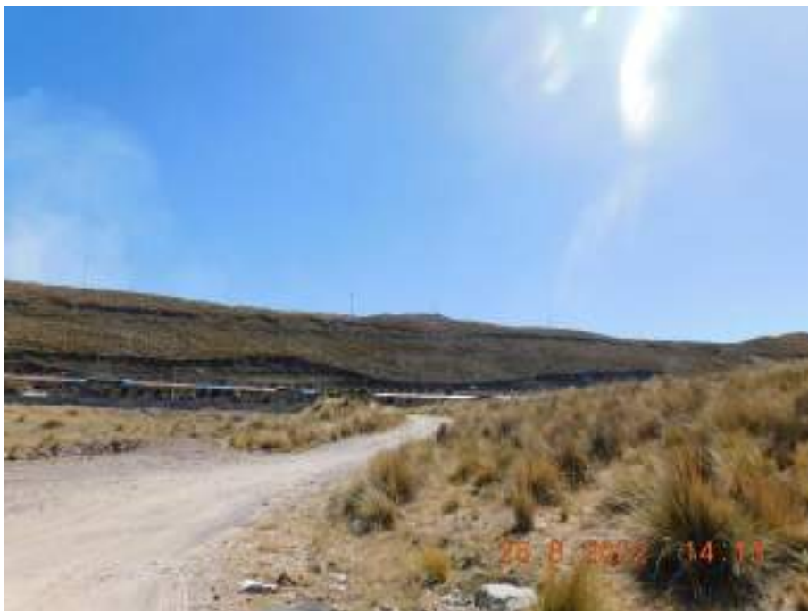
Fotografía 17: Vía de acceso sin afirmar a la zona CH Pachachaca 2, la cual se desprende de la vía nacional PE – 22, Carretera Central, en dirección a la sede distrital Morococha.
