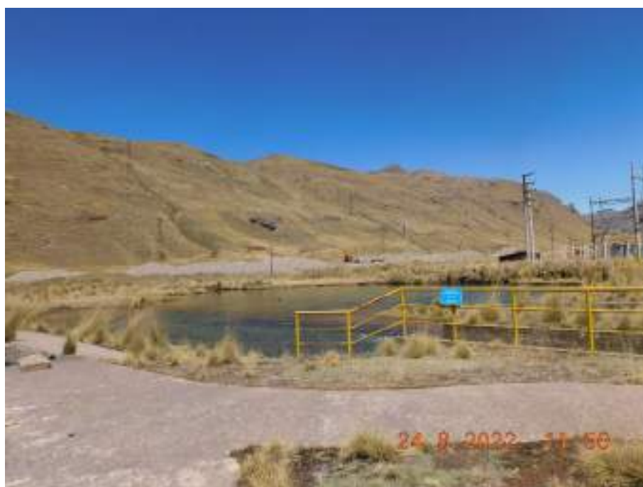
Fotografía 3: Zona CH Pachachaca 1, se puede observar la estación de monitoreo de agua próxima las instalaciones. Al fondo se puede divisar extracciones de mineral no metálico por parte de la empresa Volcan.
