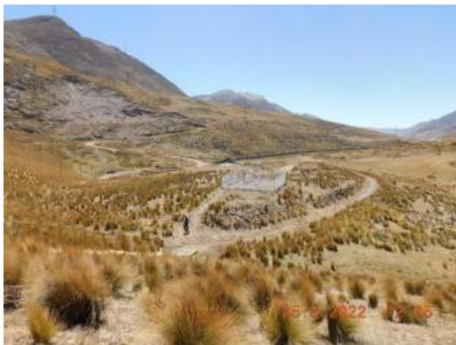
Fotografía 24: Vista general de la zona CH Pachachaca 3. Se observa que el principal acceso al área es una vía sin afirmar que se desprende de la vía departamental JU – 102.
