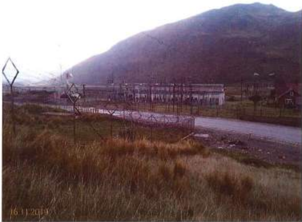
Línea de media tensión 2.4 kV
