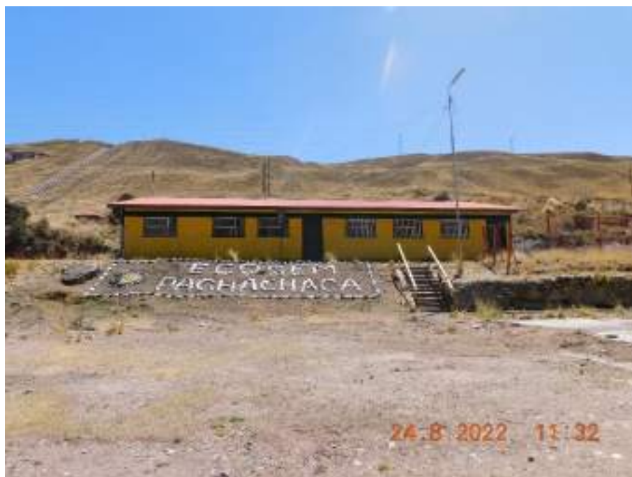
Fotografía 8: Empresa Comunal de Servicios Múltiples Pachachaca, cuyas instalaciones se encuentran frente a la zona CH Pachachaca 1.
