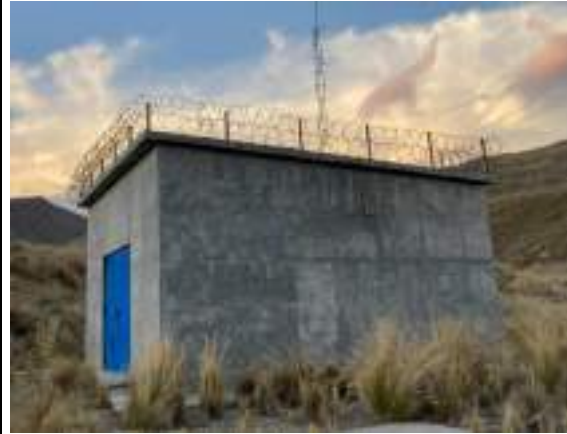
Fotografía 6.2-8 Caseta de válvula de seguridad (PAD-CHP-02)
