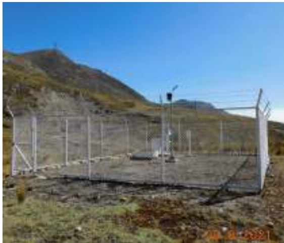
Fotografía 6.2-9 Estación Meteorológica (PAD-CHP-04)
