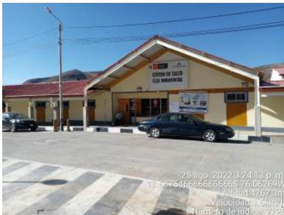
Fotografía 34: Centro de Salud CLAS Morococha, ubicado en la sede distrital Morococha.
