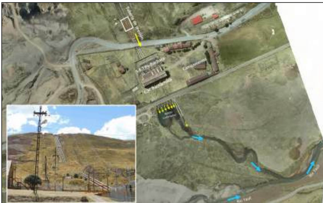
Figura 5-5 Llegada de las aguas por tubería de presión a la casa de máquinas de la CH Pachachaca
