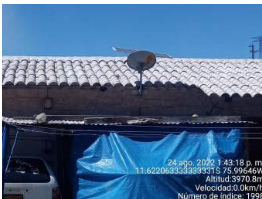
Fotografía 10: Vivienda del poblado Calera Cut Off próximo a la zona CH Oroya 1. Se puede apreciar, en el techo de tejas de la vivienda, la presencia de un panel solar para el abastecimiento de energía eléctrica, así como de una antena receptora de señal satelital de televisión.
