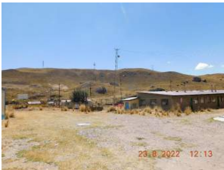
Fotografía 2: Anexo San Miguel, ubicado a menos de 200 m del ámbito de evaluación social CH Oroya 1. Asimismo, el mencionado poblado pertenece al distrito de Yauli, provincia de Yauli, departamento de Junín.
