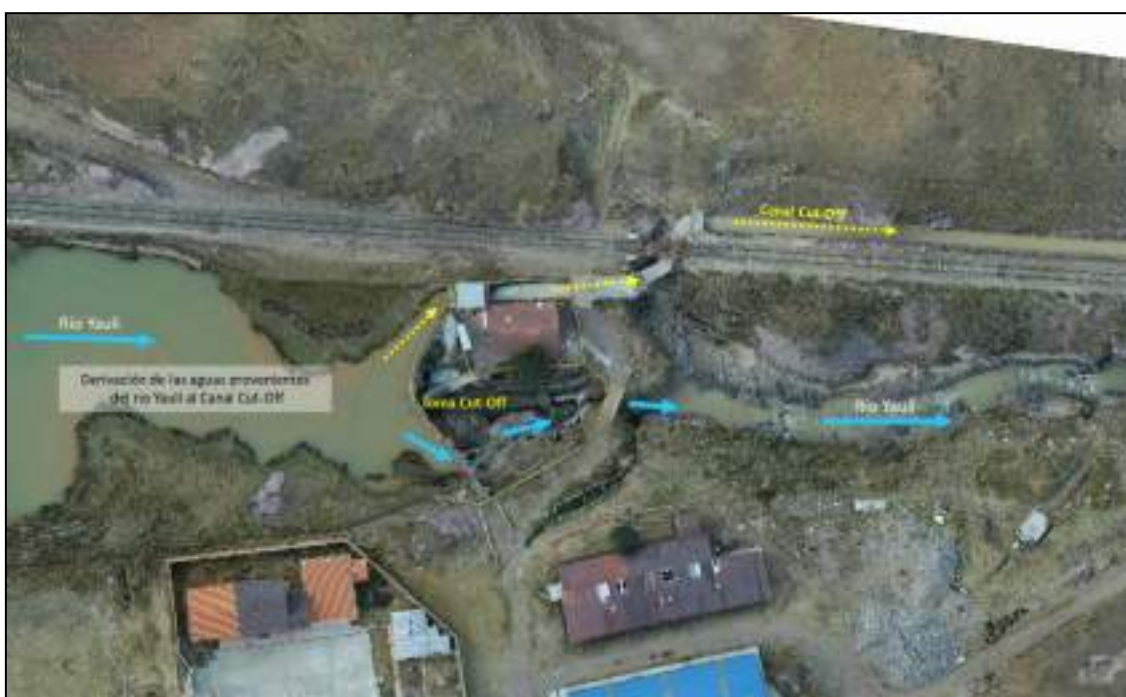
Figura 5-1 Captación de las aguas del río Yauli a la Toma Cut-off
