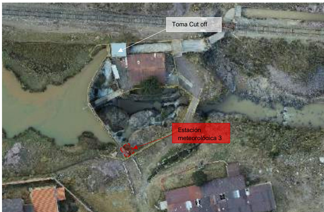
Figura 3.3-96 Ubicación de componente Estación meteorológica 3 en Toma Cut Off
