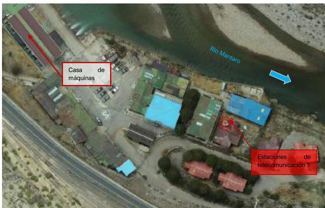
Figura 3.3-16 Ubicación de componente Estaciones de telecomunicación 1 en CH Oroya
