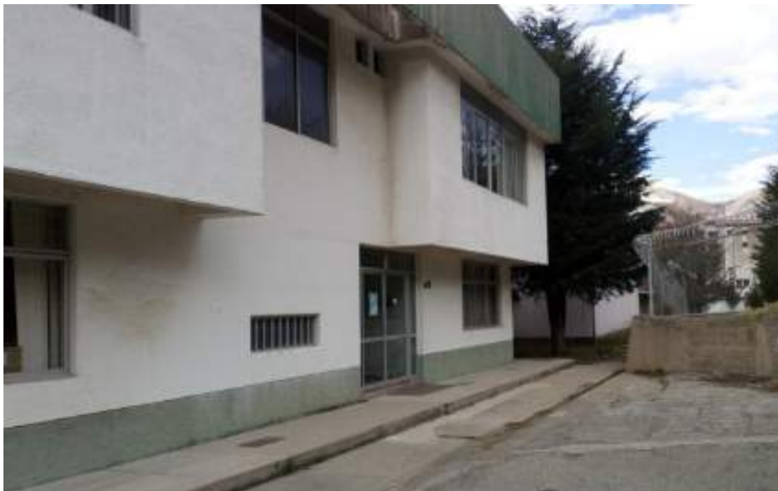
Fotografía 3.3-17 Vista actual de la Oficina 04c (oficina India)
