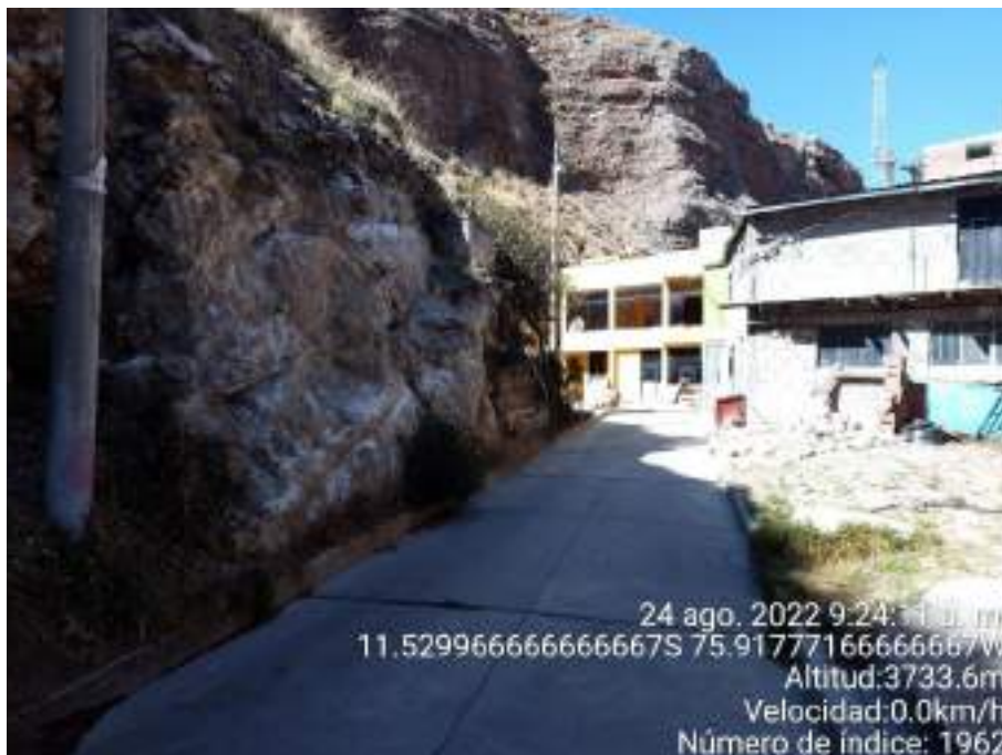
Fotografía 32: Asociación de Vivienda Ex Enafer de Huaymanta, se puede apreciar diversos accesos contruidos con cemento para facilitar el traslado de los pobladores de la asociación.
