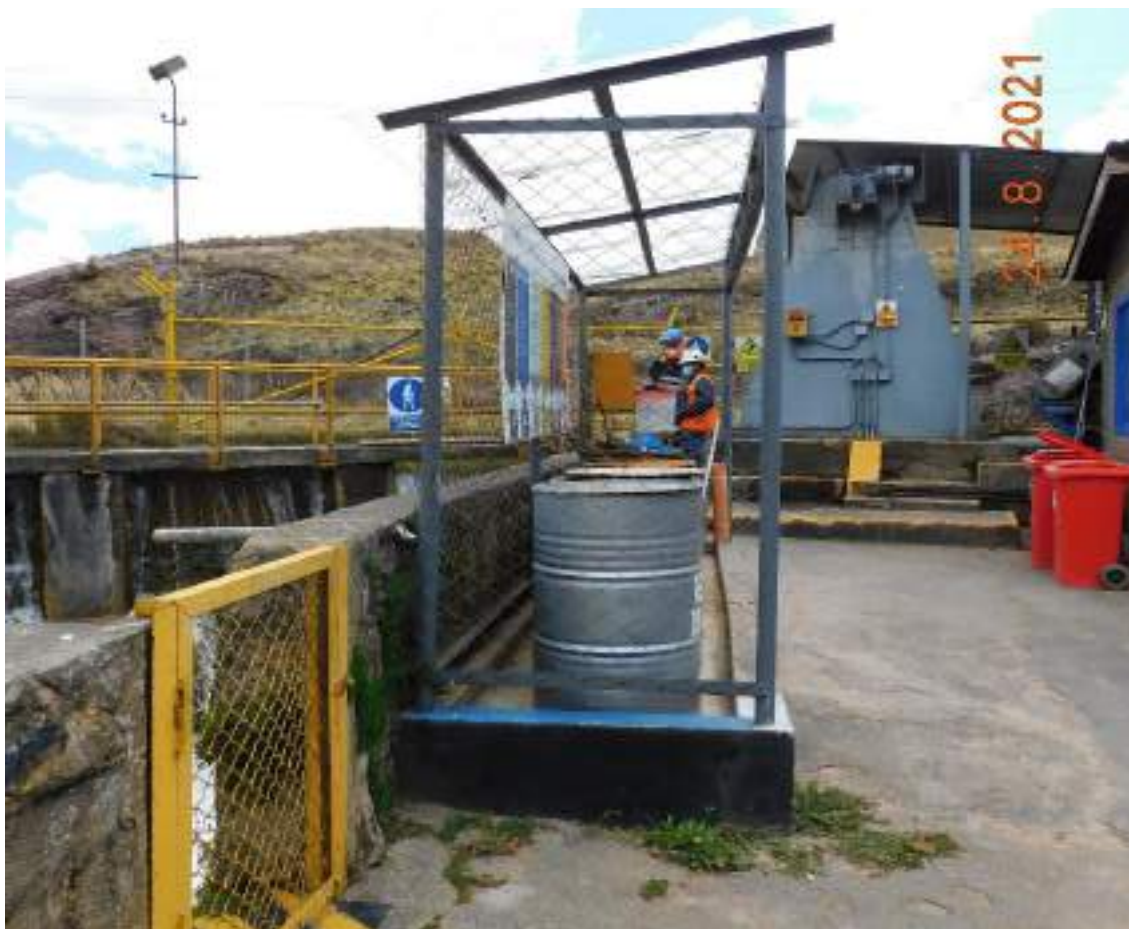
Fotografía 3.3-32 Vista actual del punto de acopio de Residuos Sólidos 1 (PAD-CHO-08a)
