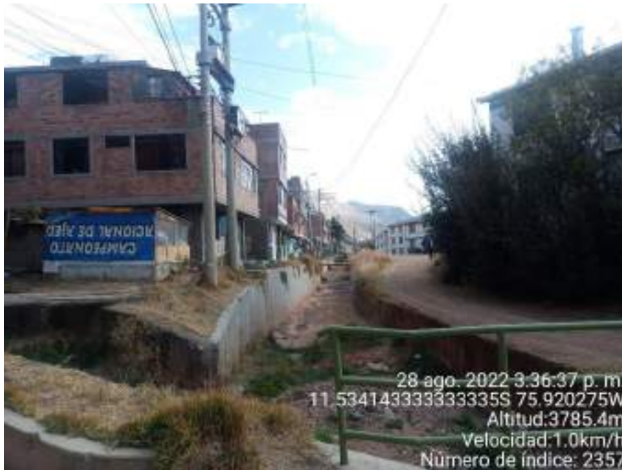
Fotografía 21: Pueblo Joven Santa Rosa, ubicado a menos de 200 m de la zona CH Oroya 3. Se aprecia que una importante cantidad de viviendas se encuentran construida con ladrillo y cementos, además, se pueden observar postes que permiten el traslado de cables de transmisión de energía eléctrica tanto para alumbrado público como a viviendas.
