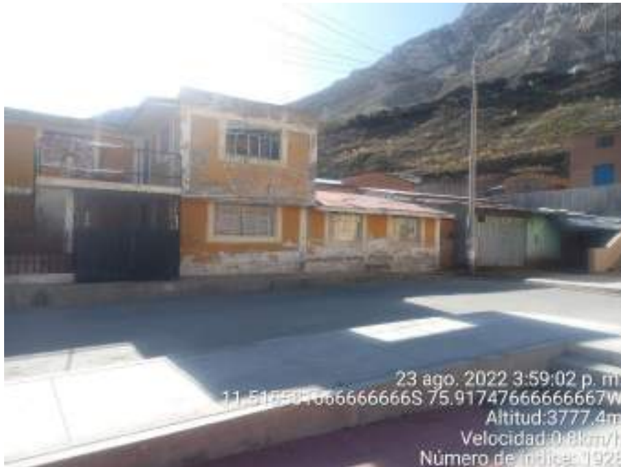
Fotografía 53: Pueblo Joven El Porvenir, se aprecian viviendas construidas mayoritariamente con ladrillo y cemento, además, en algunos casos se aprecian techos de calamina. Cabe destacar que algunas viviendas no se encuentran en un estado óptimo de conservación.
