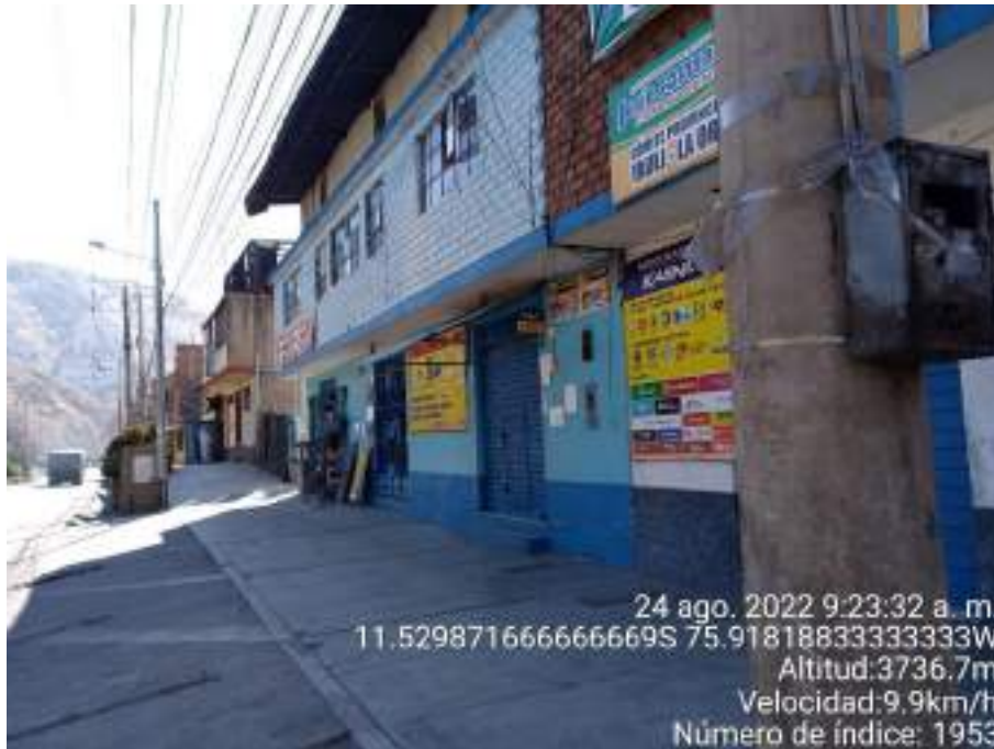
Fotografía 31: Asociación de Vivienda Ex Enafer de Huaymanta, se puede apreciar la presencia de postes que brindan soporte a la red de transmisión de energía eléctrica para alumbrado público y viviendas.
