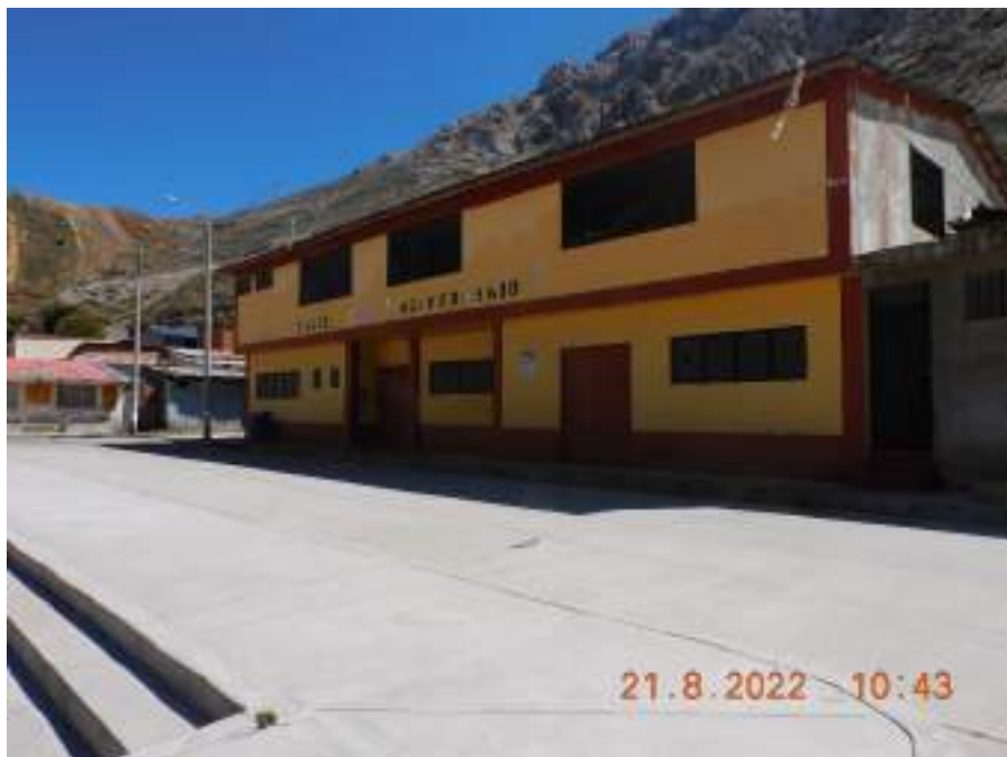
Fotografía 56: Pueblo Joven El Porvenir, se aprecia el Local Multiusos de El Porvenir ubicado próximo a la plaza principal del citado poblado.
