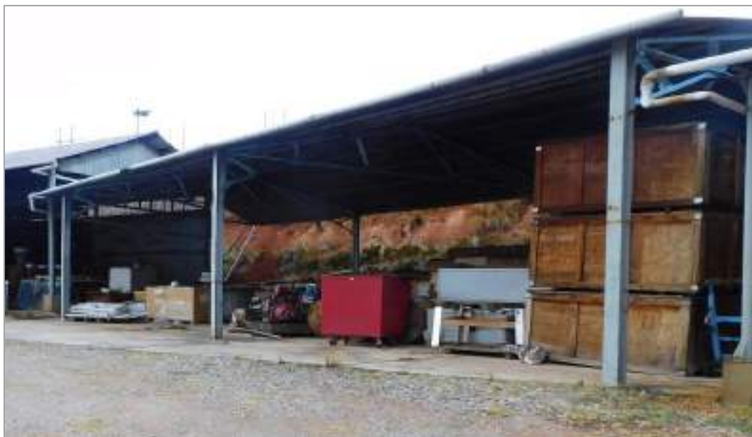
Fotografía 3.3-6 Vista del Almacén 2c
