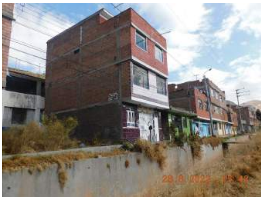
Fotografía 26: Pueblo Joven Micaela Bastidas, ubicado a una distancia aproximada de 250 m respecto al ámbito de evaluación CH Oroya 3. Se pudo apreciar que las viviendas, en su mayoría, están construidas con ladrillo y cemento.
