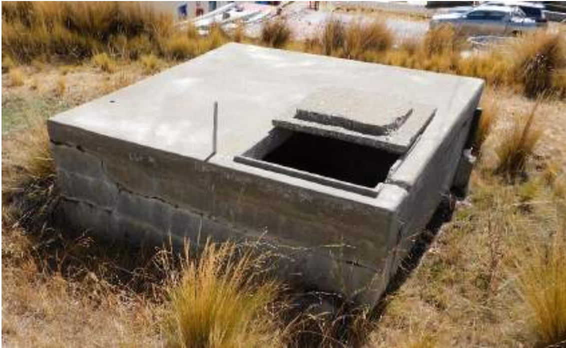
Fotografía 3.3-20 Vista actual del reservorio del componente PTAP 1
