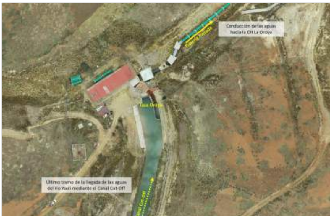
Figura 5-2 Llegada de las aguas mediante canal Cut Off a la Taza Oroya
