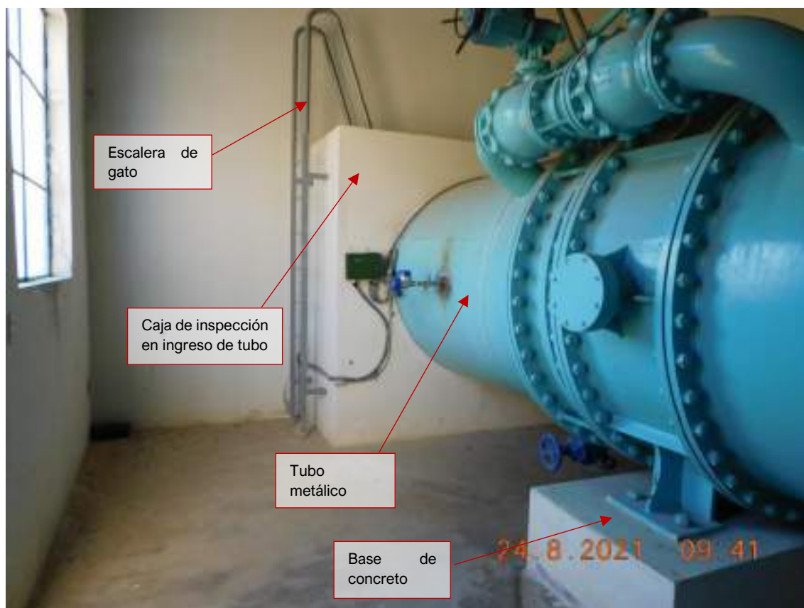
Fotografía 3.3-9 Vista interior de la Caseta de control/vigilancia 1
