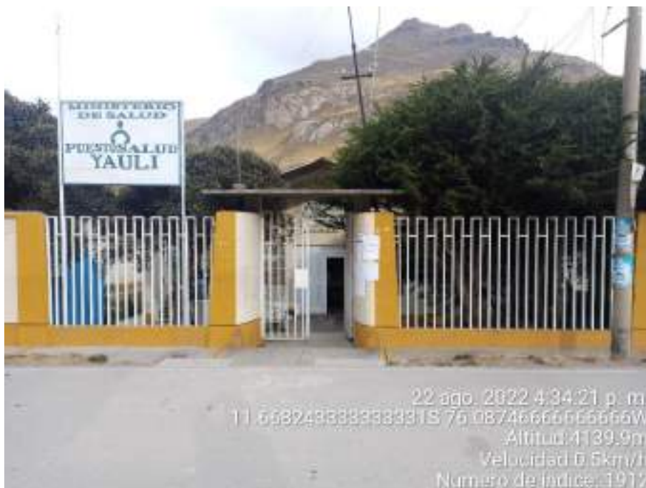
Fotografía 59: Puesto de Salud Yauli del Ministerio de Salud ubicado en el distrito de Yauli, sede distrital de la zona CH Oroya 1.
