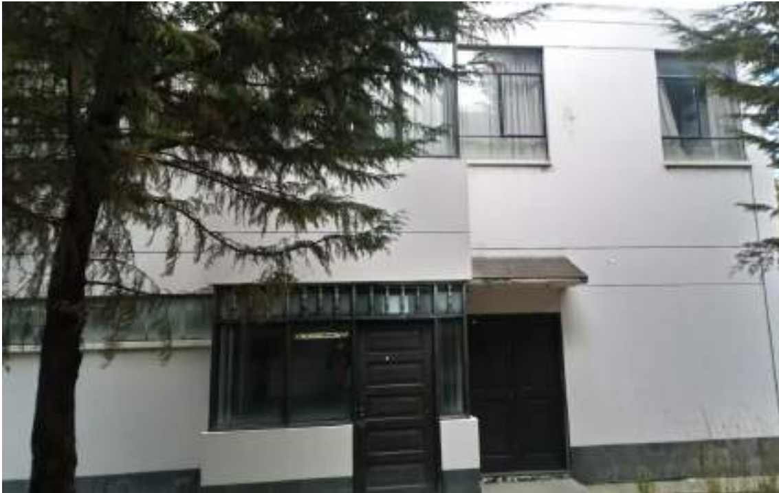
Fotografía 3.3-18 Vista actual de la Oficina 04d (oficina Filipinas)
