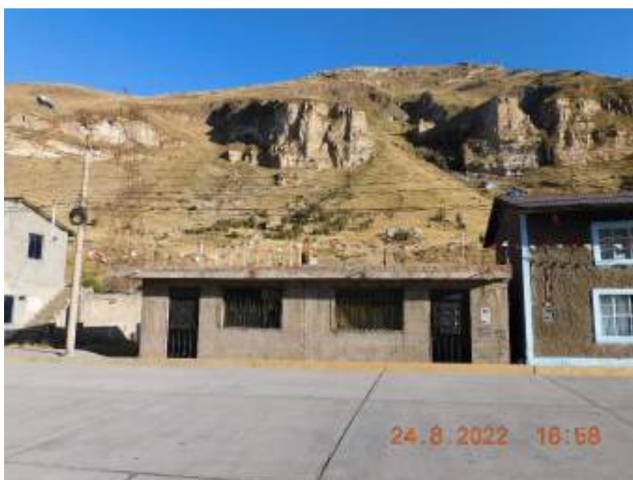
Fotografía 8: Anexo San Miguel, se pueden apreciar los postes de alumbrado público desplegados en todo el territorio que abarca el citado anexo.
