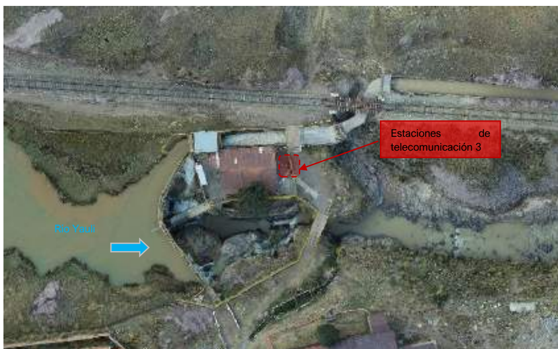
Figura 3.3-22 Ubicación de componente Estaciones de telecomunicación 3, en Toma Cut off
