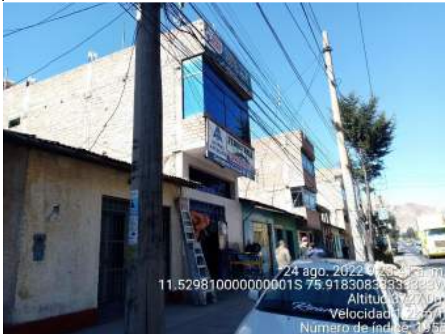
Fotografía 30: Asociación de Vivienda Ex Enafer de Huaymanta, ubicado a menos de 300 m de la zona CH Oroya 3, se puede apreciar viviendas mayoritariamente construidas con ladrillo y cementos tanto en techos y paredes, aunque también se observaron viviendas cuyos techos eran de calamina.
