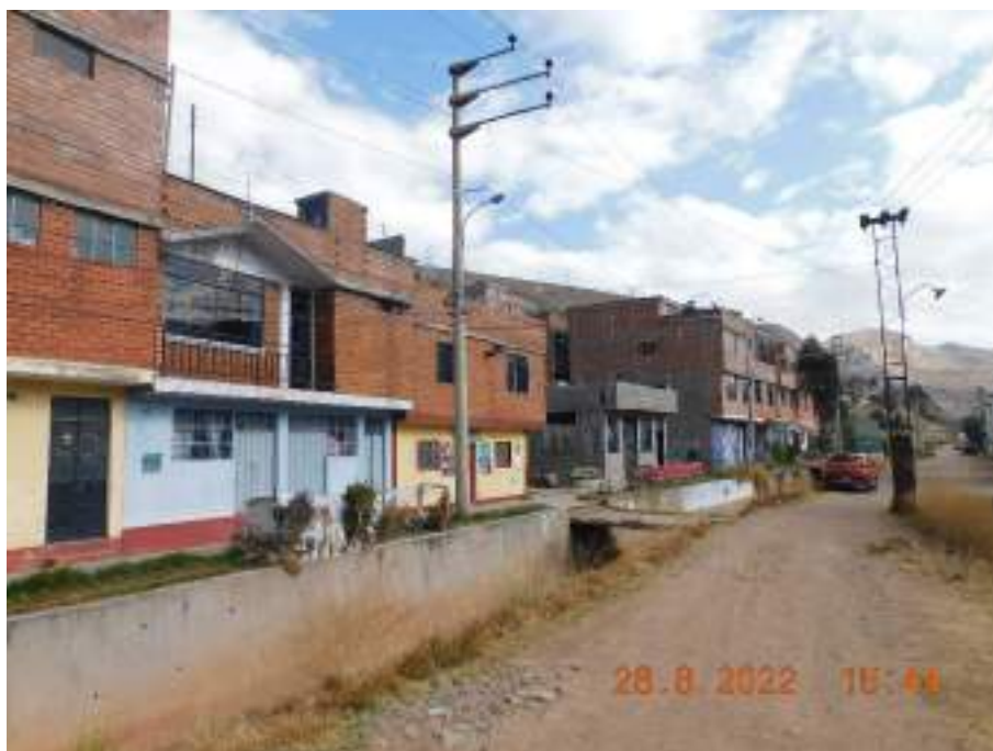
Fotografía 27: Pueblo Joven Micaela Bastidas, se aprecia la vía sin afirmar paralela a la Carretera Central que brinda el acceso principal al referido poblado, así como los cables de transmisión energética para alumbrado público y viviendas.
