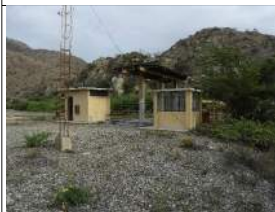
Fotografía 6.2-3 Caseta de control/vigilancia (PAD-CHG-02b)
