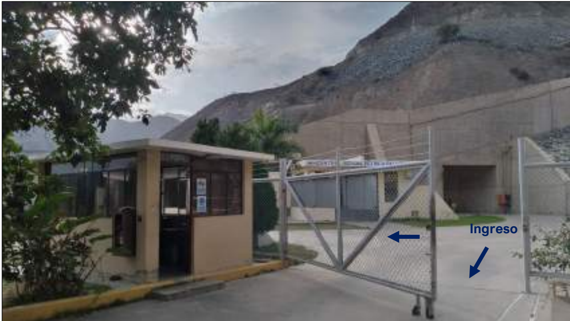
Fotografía 3.3-2 Vista actual de Caseta de control/vigilancia 1
