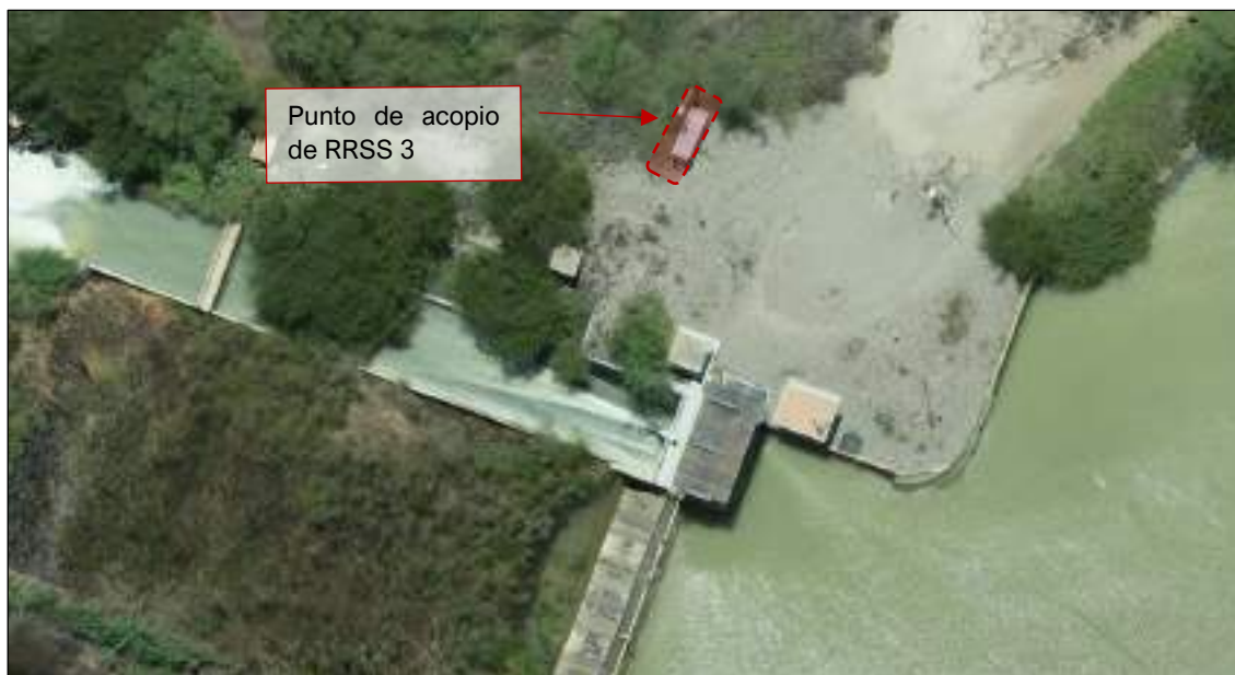
Figura 3.3-14 Ubicación del Punto de acopio de RRSS 3 (PAD-CHG-05c)
