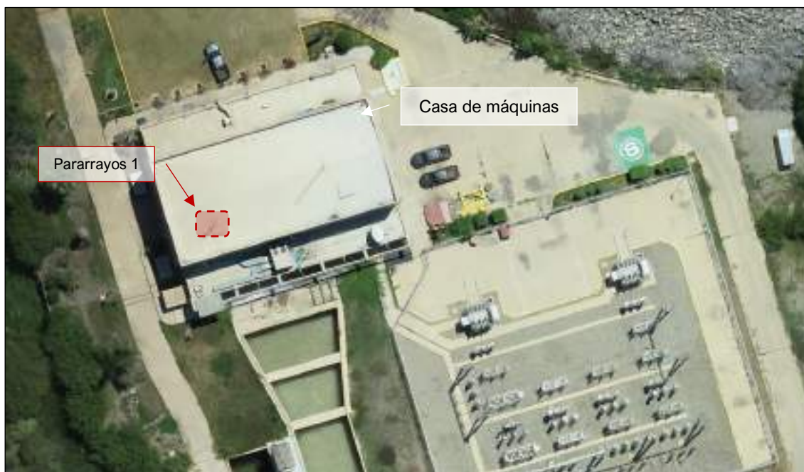
Figura 3.3-21 Ubicación del Pararrayos 1 en la casa de máquinas
