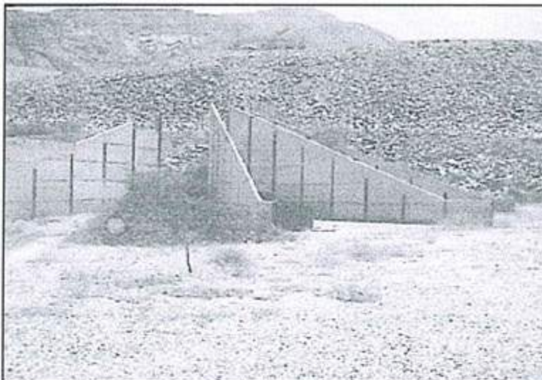
Vista 11. Paredes de concreto y área deforestada
