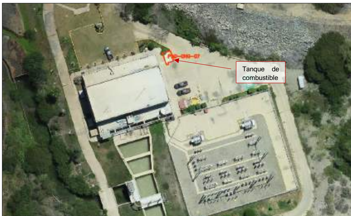
Figura 3.3-19 Ubicación de Tanque de combustible
