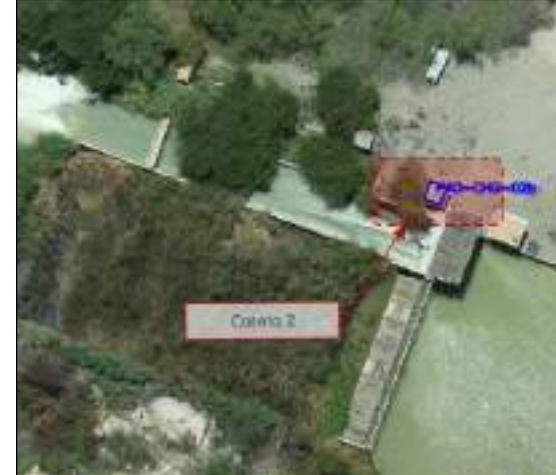
Componente: Caseta de compuertas Superficie: 7.00 m 2
