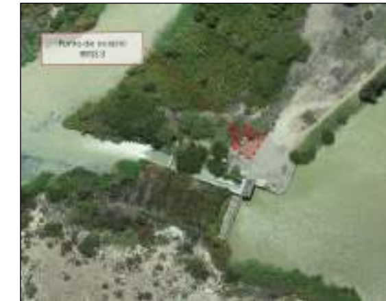
Componente: Punto de acopio de RR.SS 3: Reservorio de compensación Superficie: 5.64 m 2
