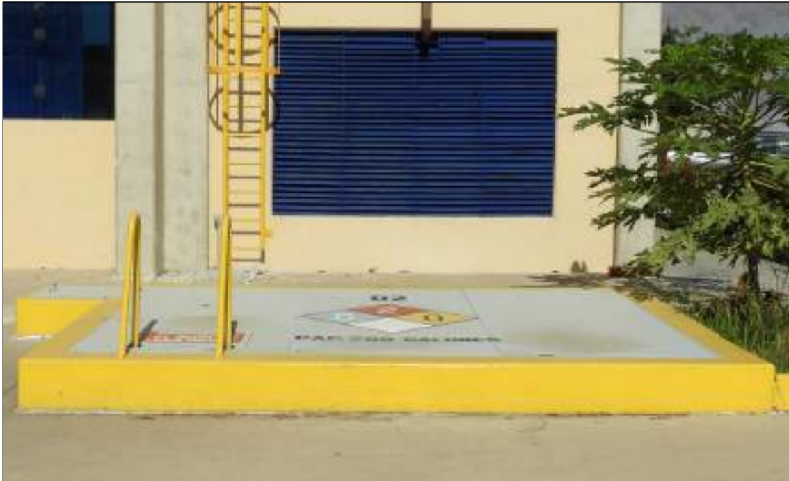
Fotografía 3.3-11 Vista actual del Tanque de combustible
