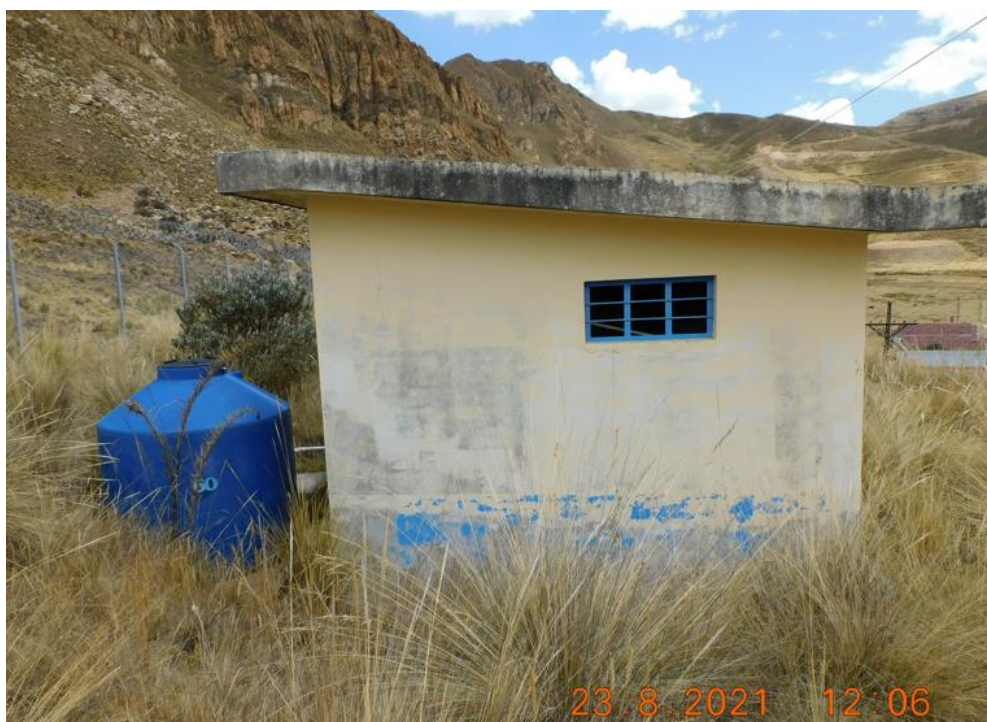
Fotografía 3.3-8 Planta de tratamiento de agua potable (PTAP)
