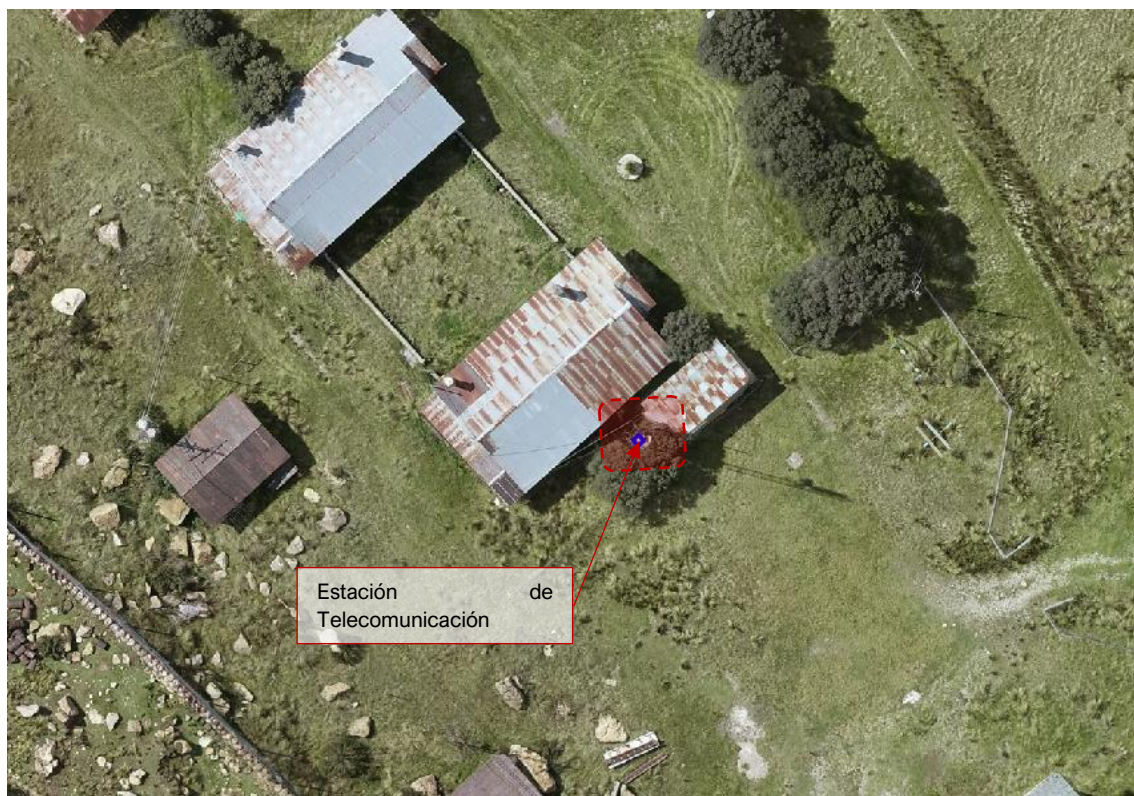
Figura 3.3-4 Vista planta del componente
