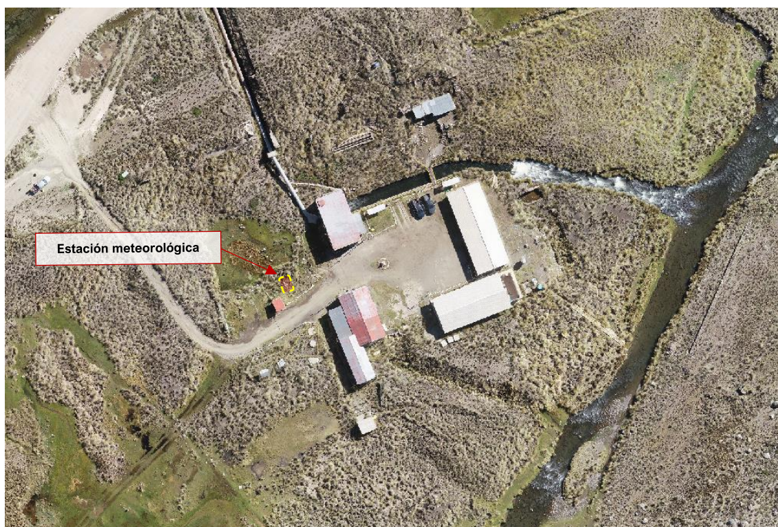
Figura 3-42 Vista planta de ubicación: estación meteorológica
