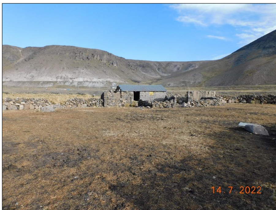
Fotografía 9: Vista general en estancia Tica Tica. En la imagen se aprecian dos edificaciones de piedra y corrales con cerco de piedra.
