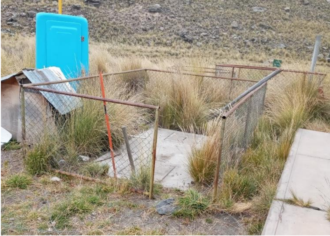
Fotografía 3-23 Vista actual de pozo séptico
