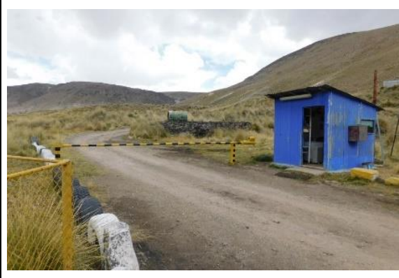
Fotografía 6.2-6 Caseta de control y vigilancia (PAD-CSI-06)
