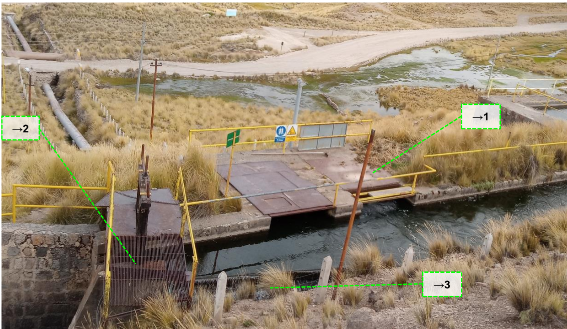
Fotografía 3-1 Vista de la cámara de carga
