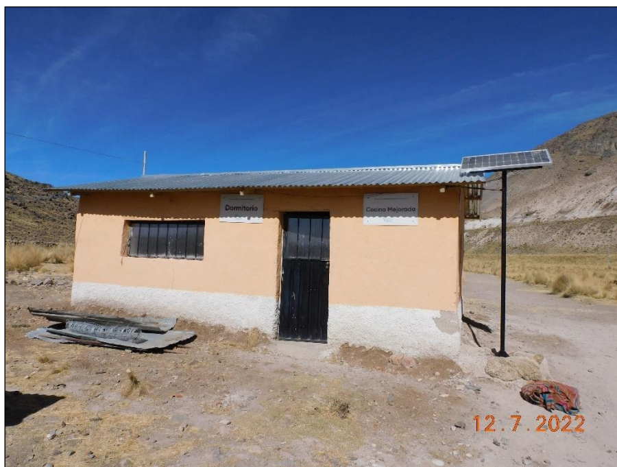
Fotografía 6: Edificaciones en estancia San Antonio. Espacio que cumple la función de dormitorio y cocina, mantiene paredes de adobe y techo de calamina. Asimismo, cuenta con un panel solar.
