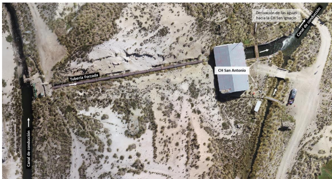
Figura 5-1 Salida de las aguas turbinadas de la CH San Antonio al canal de conducción de la CH San Ignacio
