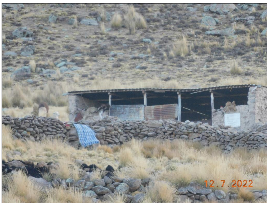
Fotografía 13: Infraestructura a estancia Potosí. Cobertizo de adobe con techo de calamina y corral con cerco de piedra.
