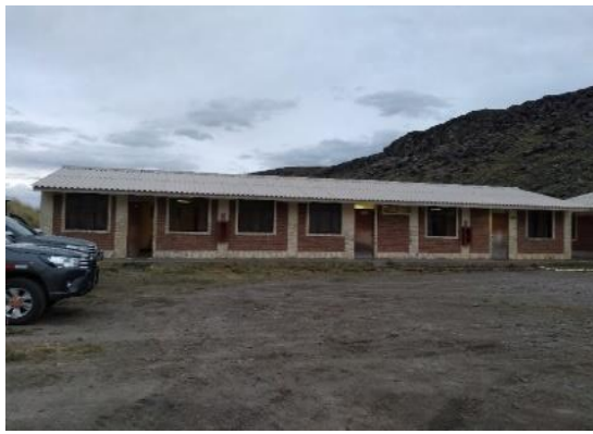
Fotografía 6.2-5 Campamento y comedor (PAD-CSI-05)
