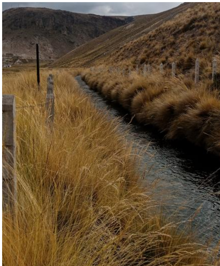
Fotografía 3-7 Vista actual de estación del canal de conducción
