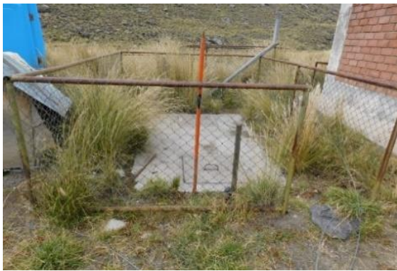
Fotografía 6.2-9 Pozo séptico (PAD-CSI-08)
