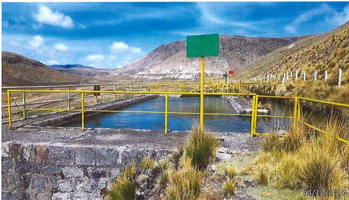
Tubería forzada CH San Ignacio
