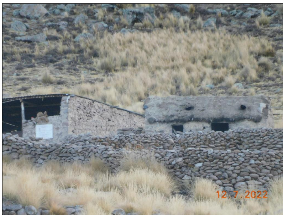
Fotografía 12: Infraestructura a estancia Potosí. Vivienda de adobe con techo de paja junto a cobertizo.
