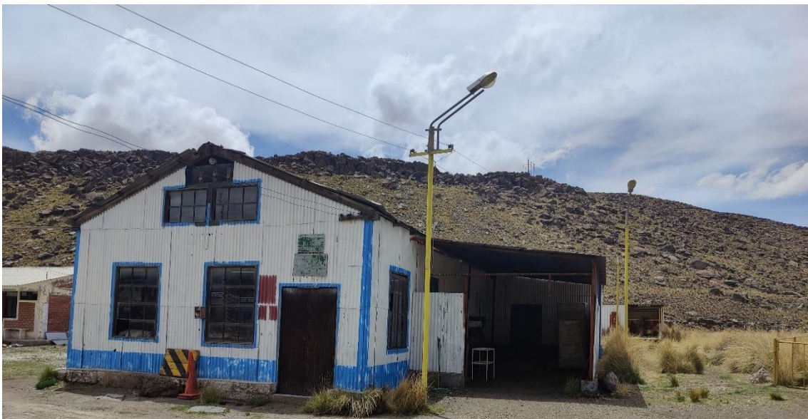
Fotografía 3-16 Vista actual del almacén y taller
