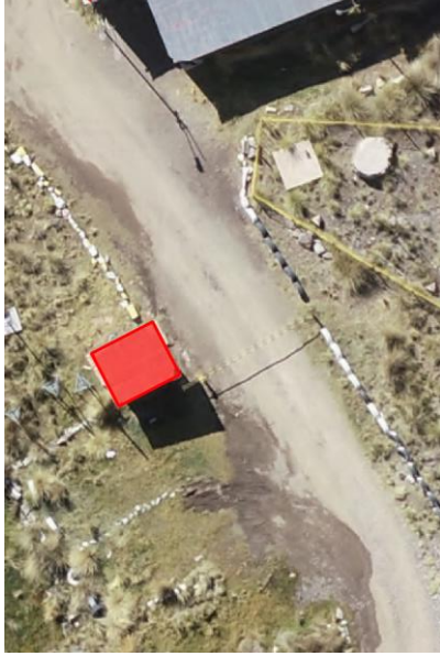
Componente = Caseta de control/vigilancia Superficie total = 7.52 m 2
