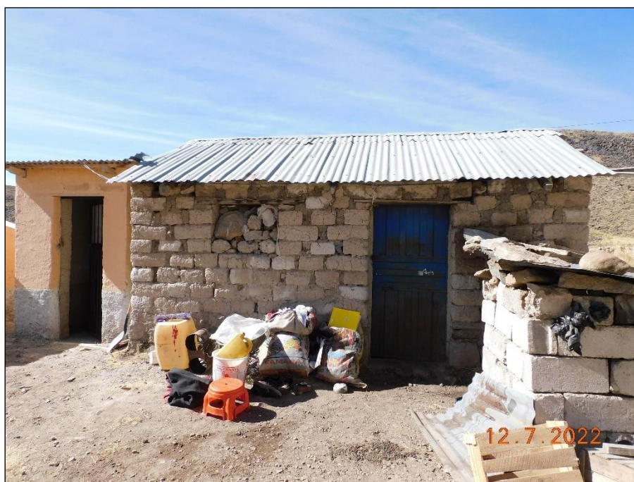
Fotografía 5: Edificaciones en estancia San Antonio. Vivienda y letrina, ambas con paredes de adobe y techo de calamina.
