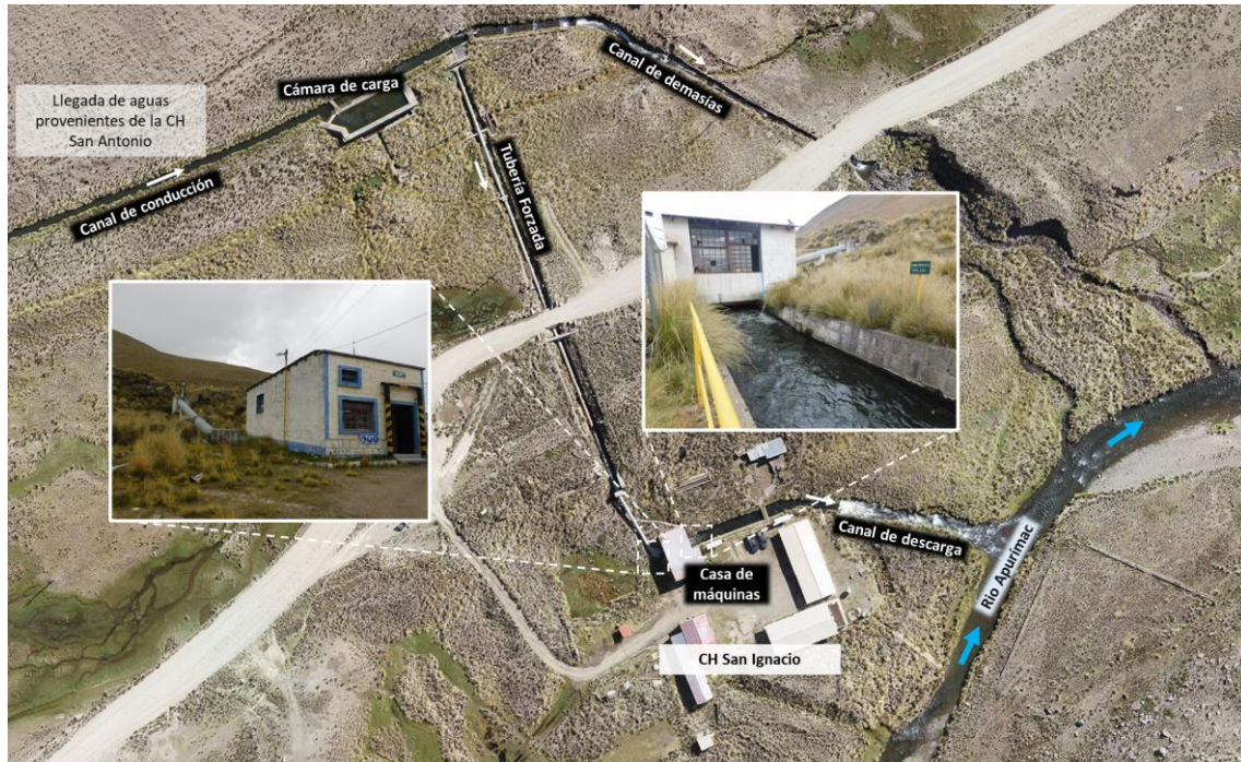
Figura 5-2 Llegada de las aguas a la CH San Ignacio
