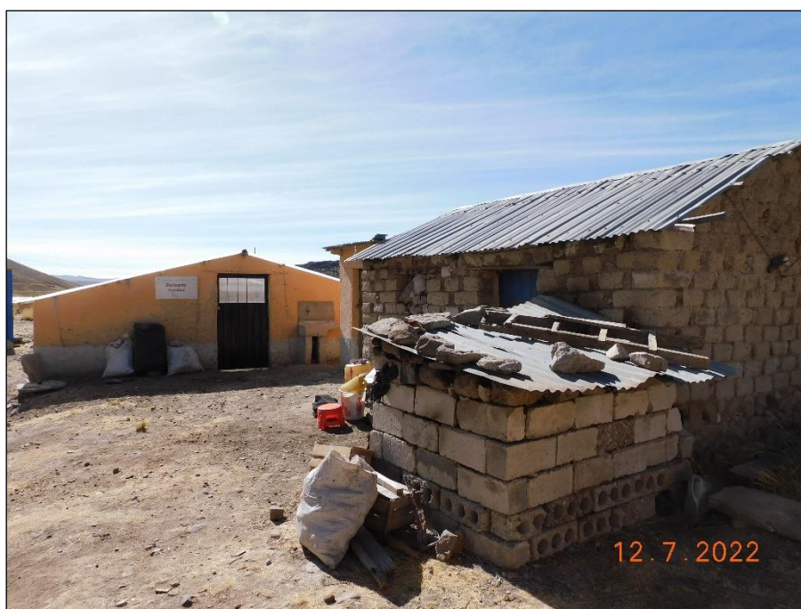
Fotografía 4: Edificaciones a estancia San Antonio. Vivienda y biohuerto de la estancia, paredes de adobe y techo de calamina.
