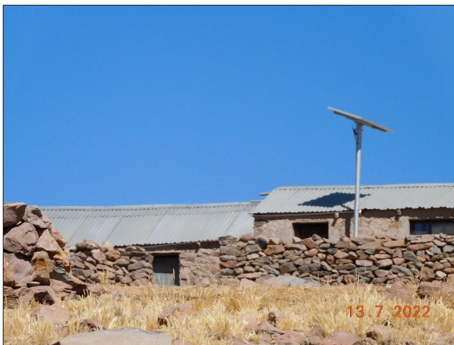
Fotografía 19: Infraestructura de la estancia Parihuana. Vista de viviendas con paredes de piedra y techo de calamina.
