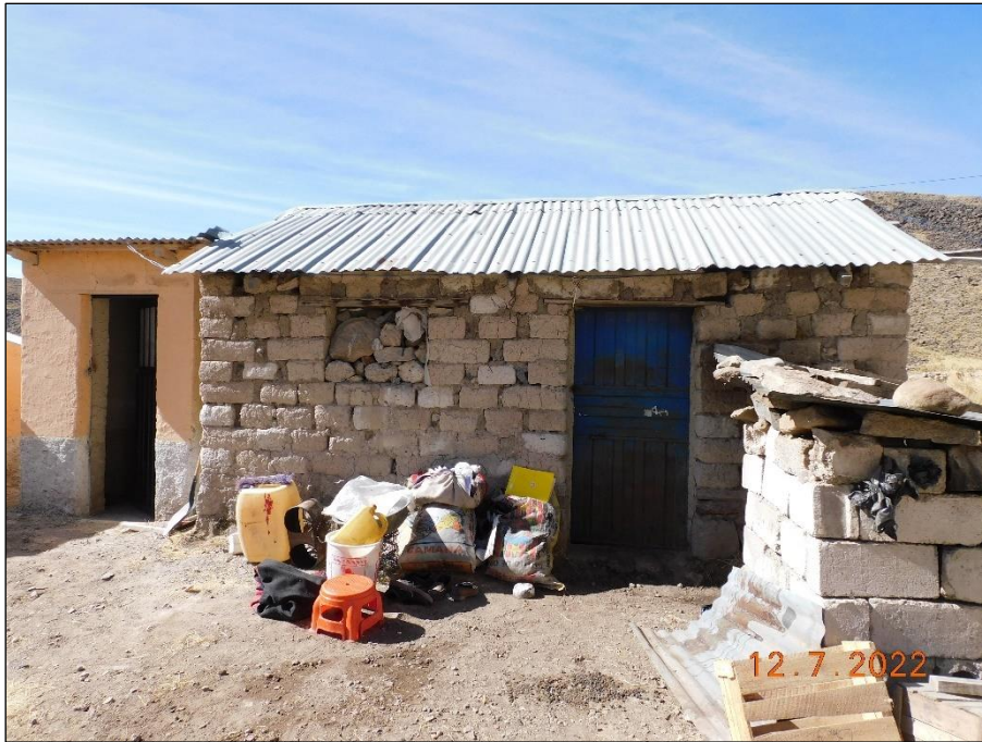
Fotografía 5: Edificaciones en la estancia San Antonio. Vivienda y letrina, ambas con paredes de adobe y techo de calamina.
