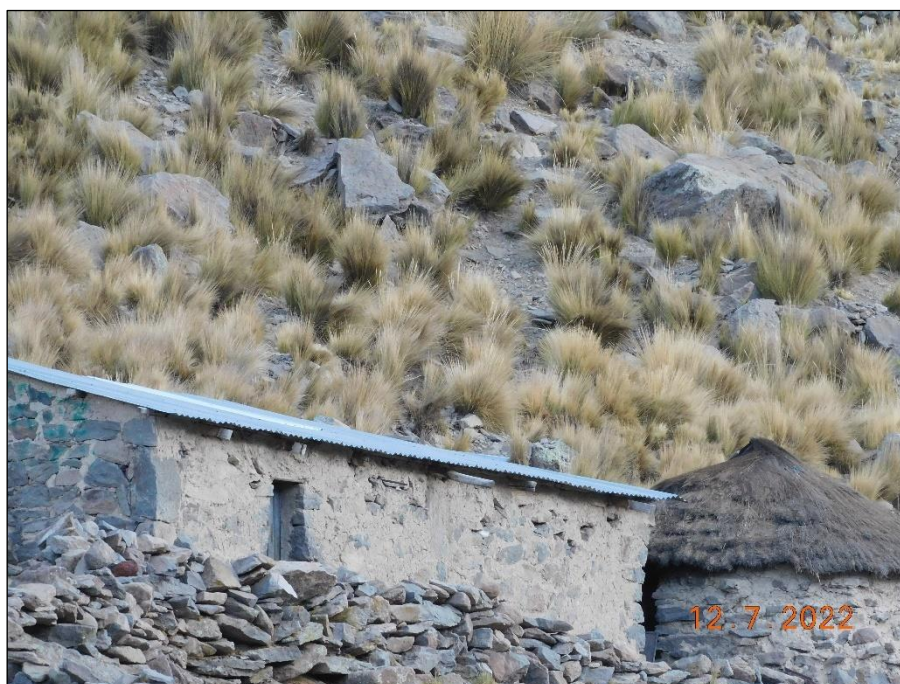
Fotografía 10: Infraestructura en la estancia Qquisi. En la imagen se aprecian dos estructuras, una vivienda con techo de calamina, una cocina con techa de paja, ambas edificaciones cuentan con paredes de piedra.
