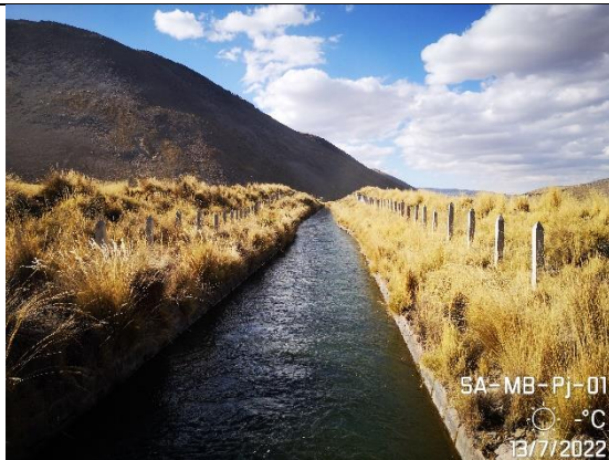
Fotografía 6.2-9 Toma Jacancuyo/Canal de aducción
