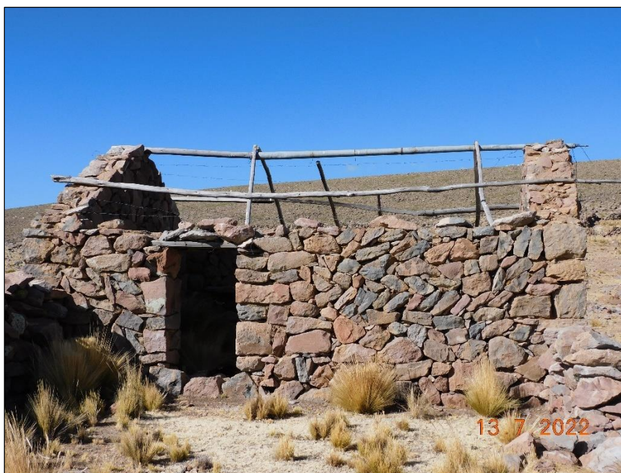
Fotografía 16: Infraestructura de la estancia Achachorco. Vivienda de piedra abandonada en la estancia.
