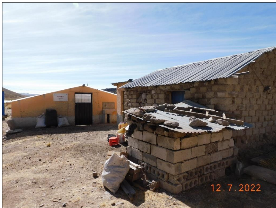
Fotografía 4: Edificaciones en la estancia San Antonio. Vivienda y biohuerto de la estancia, paredes de adobe y techo de calamina.
