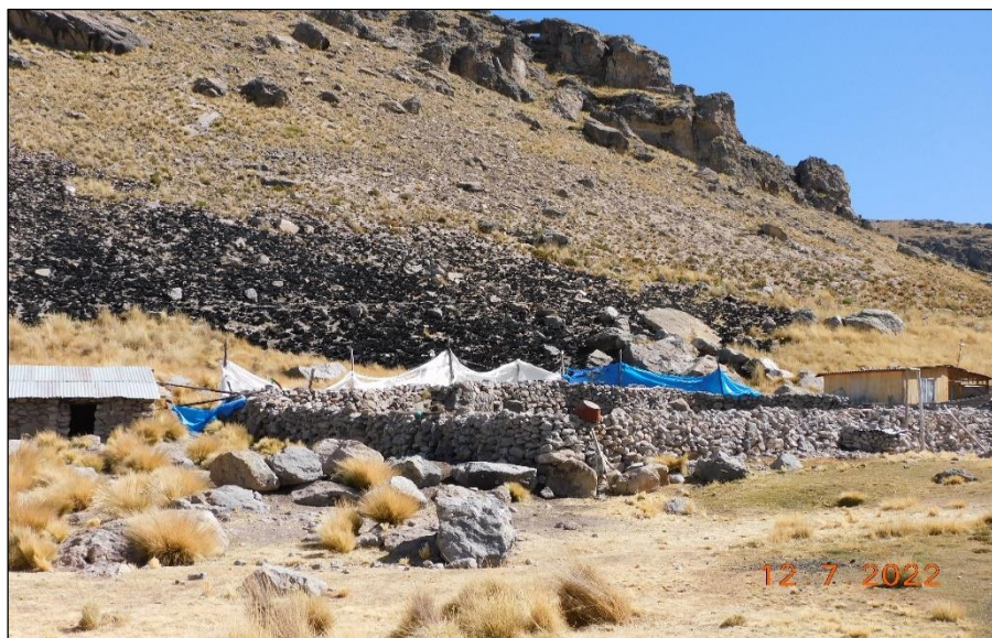
Fotografía 1: Vista general de la estancia Cupirite. Se puede observar a las dos viviendas de la estancia, una de madera y una de piedra, ambas con techo de piedra; además se puede visualizar un corral de piedra.
