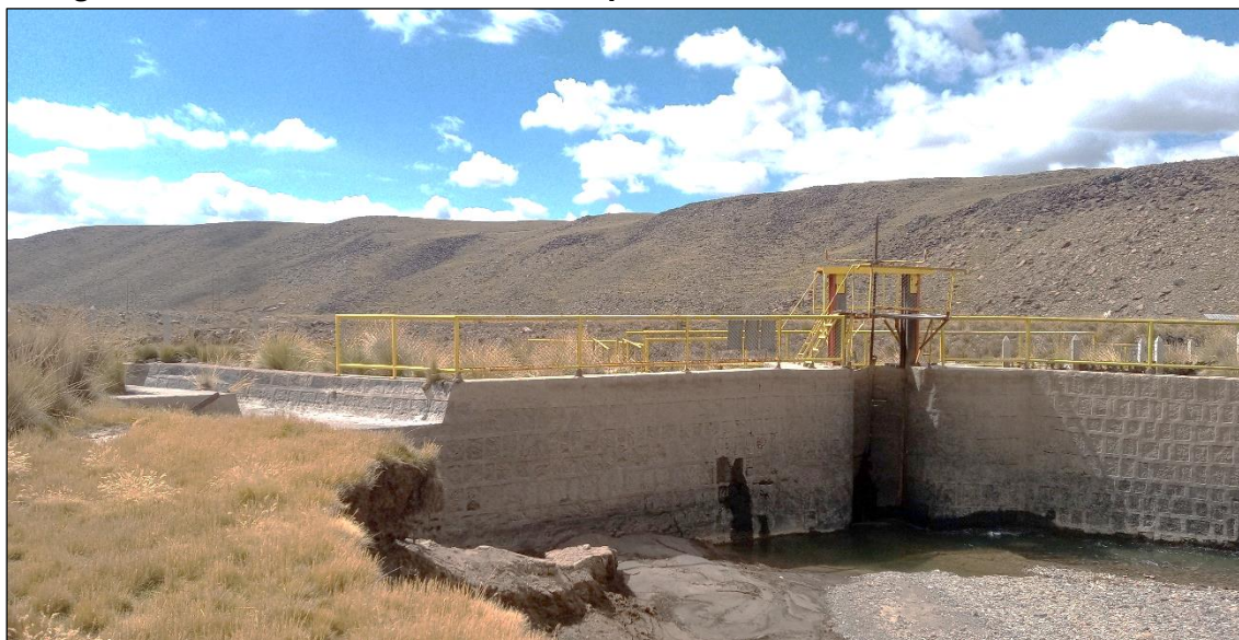
Fotografía 3.2-1 Vista actual de la Compuerta Chuncho
