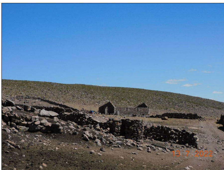
Fotografía 24: Infraestructura de la estancia Huañaccaya. Vista de vivienda en desuso.
