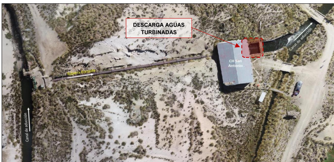
Figura 3.4-26 Vista de la descarga de las aguas turbinadas
