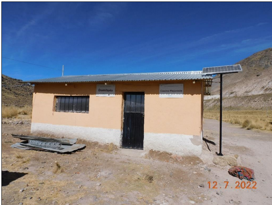
Fotografía 6: Edificaciones en la estancia San Antonio. Espacio que cumple la función de dormitorio y cocina, mantiene paredes de adobe y techo de calamina. Asimismo, cuenta con un panel solar.
