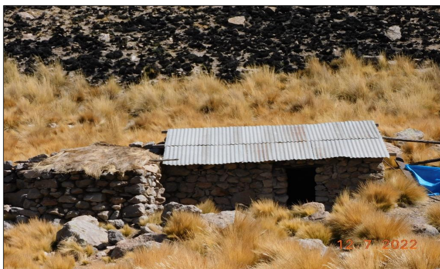
Fotografía 2: Vivienda en la estancia Cupirite. En esta imagen se pueden visualizar a una vivienda de piedra con techo de calamina y un espacio que funcionaría como cocina, el cual es de piedra con techo de paja.
