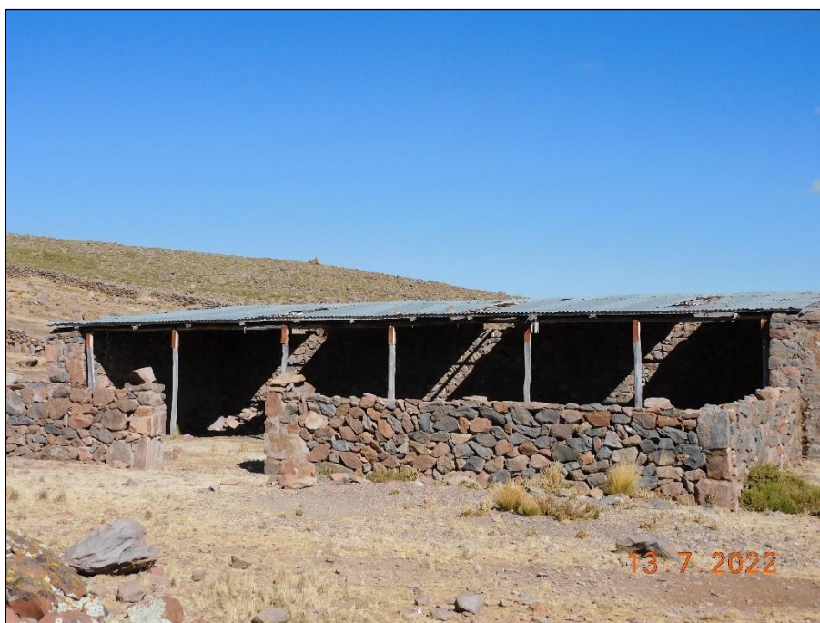
Fotografía 18: Infraestructura de la estancia Achachorco. Vista del cobertizo con paredes de piedra y techo de calamina.
