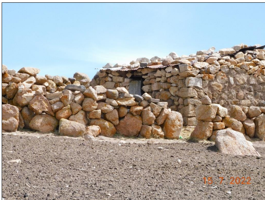
Fotografía 26: Infraestructura de la estancia Tojrollo. Vivienda de piedra con techo de calamina.
