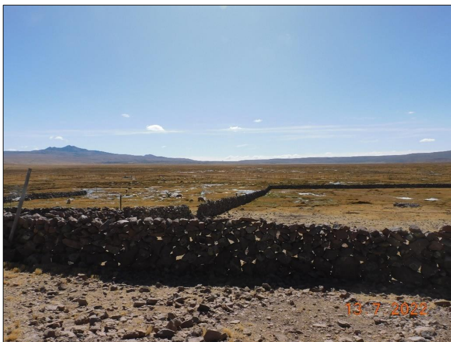
Fotografía 17: infraestructura de la estancia Achachorco. Vista de los corrales con cerco de piedra.
