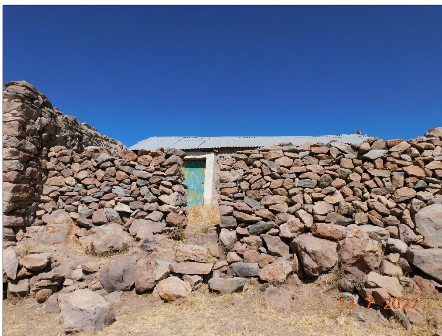
Fotografía 20: Infraestructura de la estancia Parihuana. Vivienda con paredes de piedra y techo de calamina.
