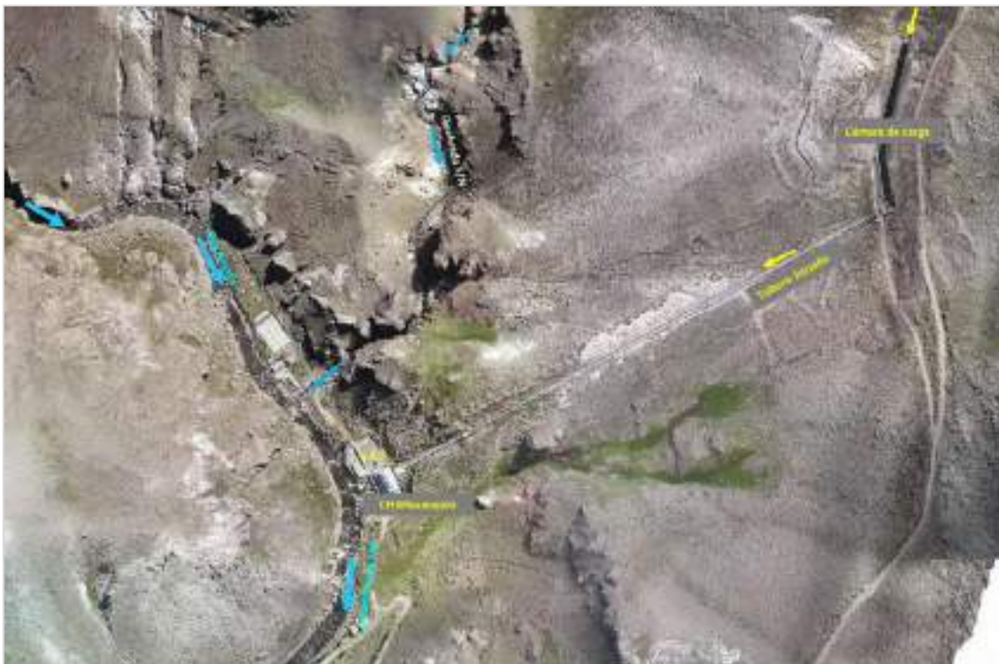
Figura 5-5 Ingreso de las aguas a la casa de máquinas de la CH Misapuquio
