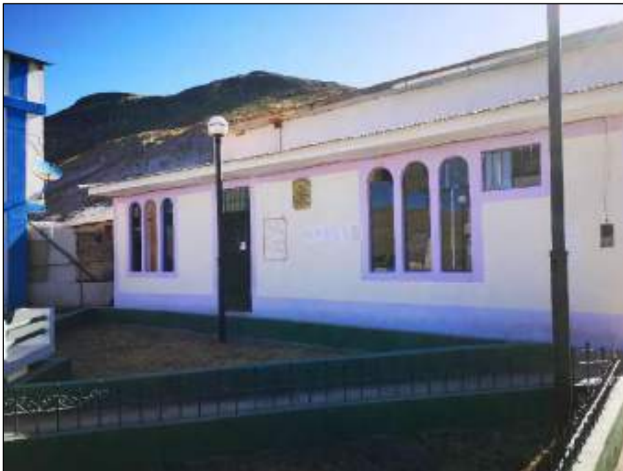
Fotografía 8: Frontis de la Sede Municipalidad del Centro Poblado Arcata.
