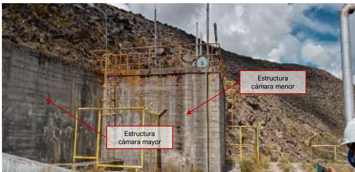
Fotografía 3.3-6 Vista de las estructuras de la Cámara de carga
