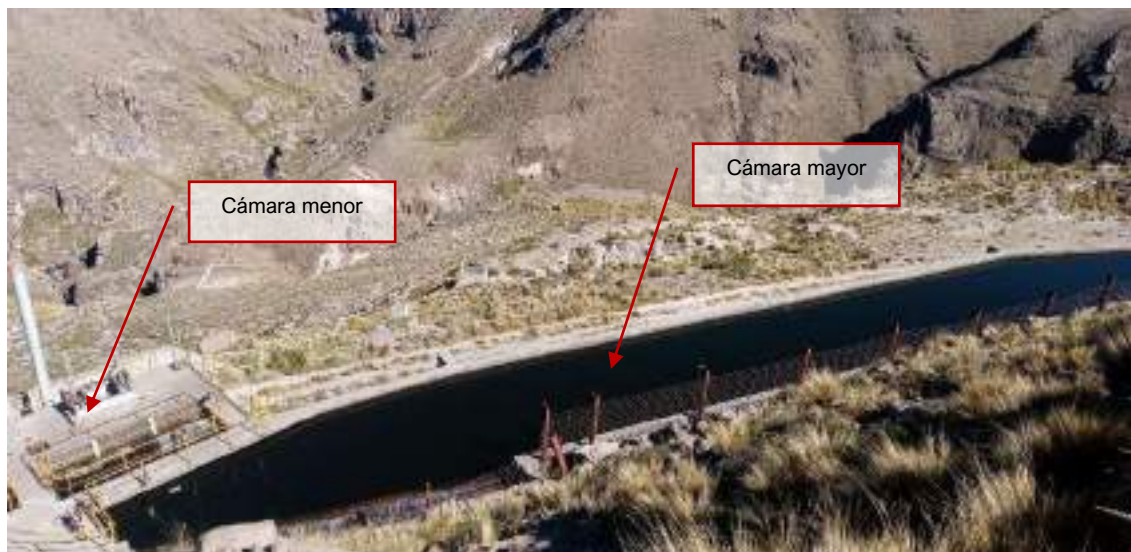
Fotografía 3.3-4 Vista actual de la Cámara de carga
