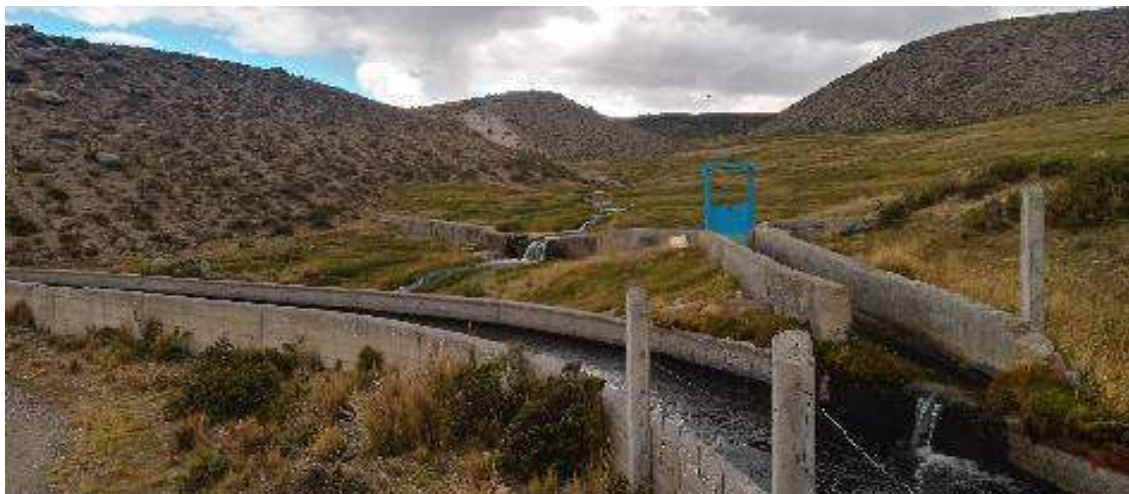
Fotografía 3.3-29 Toma Udjo 3/Toma 5: Aporte km 7+620
