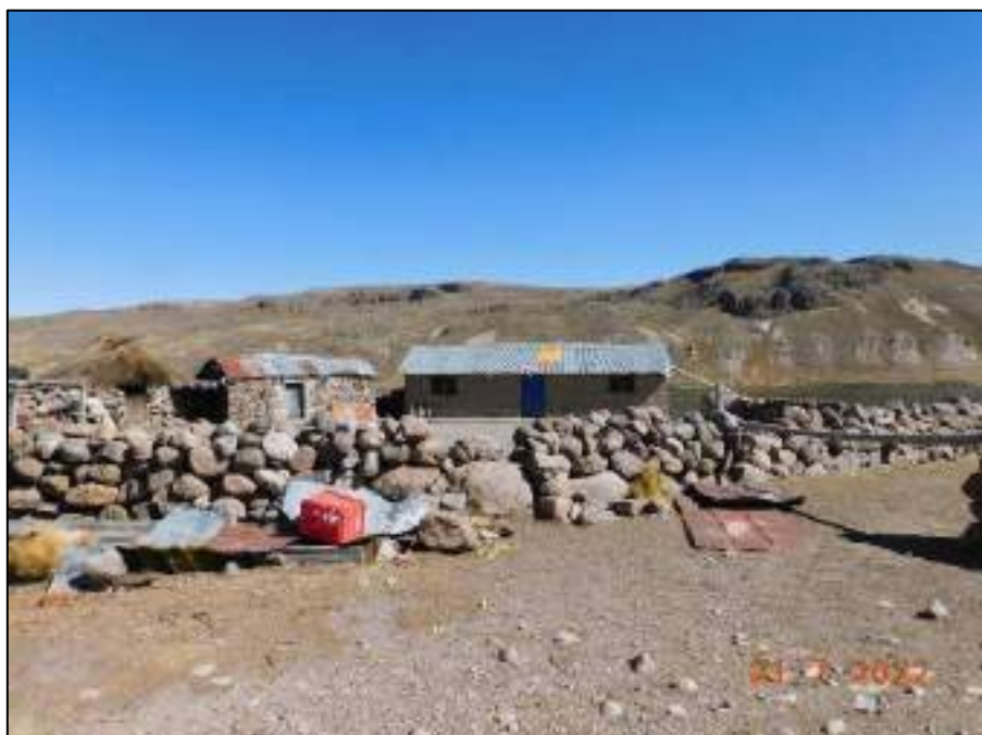
Fotografía 30: Infraestructura de la estancia Machacoyo. Viviendas, una con paredes de adobe y la otra con paredes de piedra, ambas con techo de calamina.
