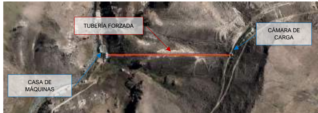
Componente: Tubería forzada Superficie: 1,517.4 m 2
