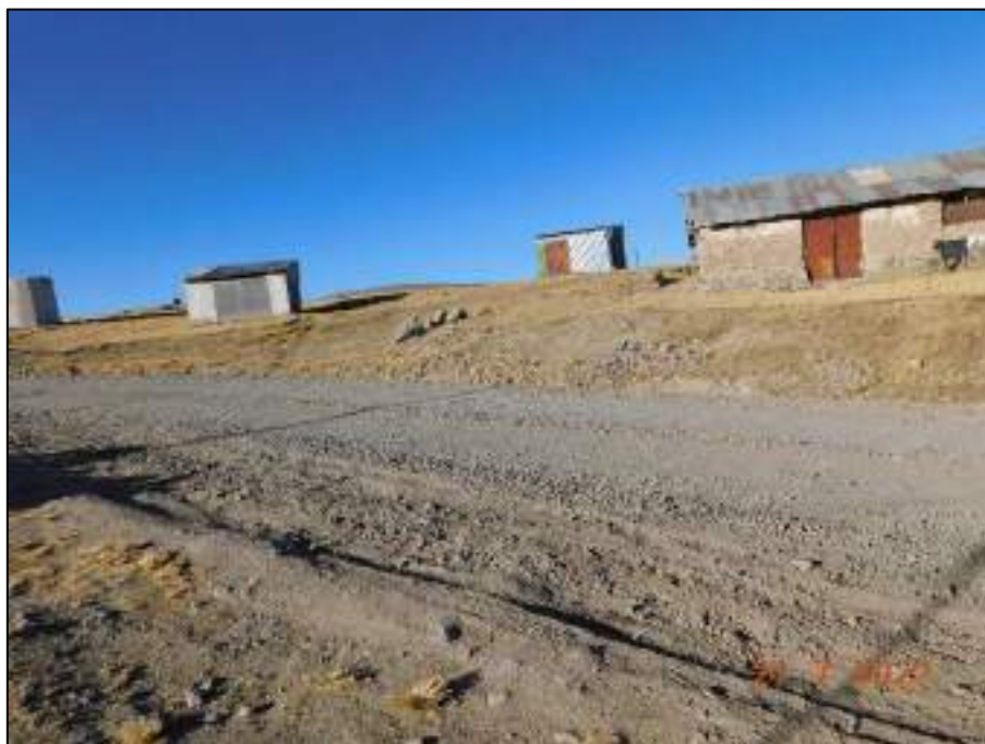
Fotografía 39: Infraestructura de la ampliación Cruz Pata. Vivienda con paredes de adobe y techo de calamina, y módulos de calamina.
