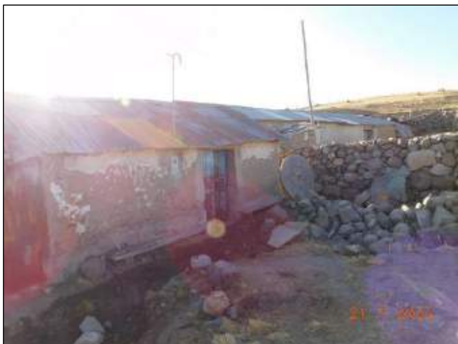
Fotografía 38: Infraestructura de la ampliación Cruz Pata. Viviendas con paredes de adobe y techos de calamina.
