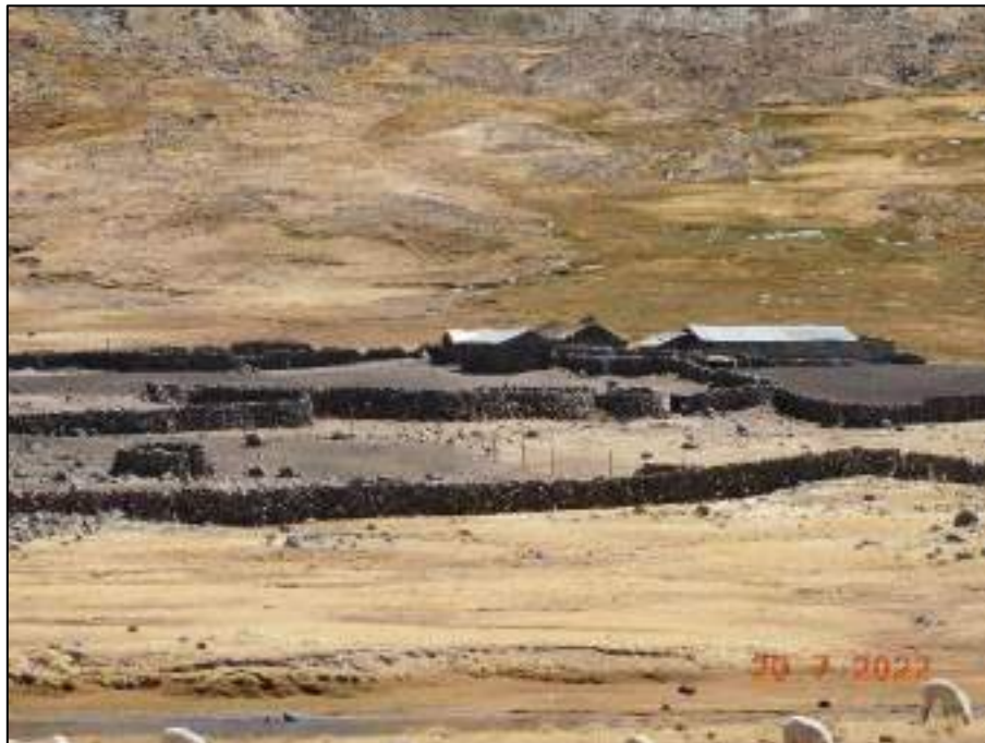
Fotografía 27: Infraestructura de la estancia Cochasique. Vista de general de viviendas y corrales de la estancia.
