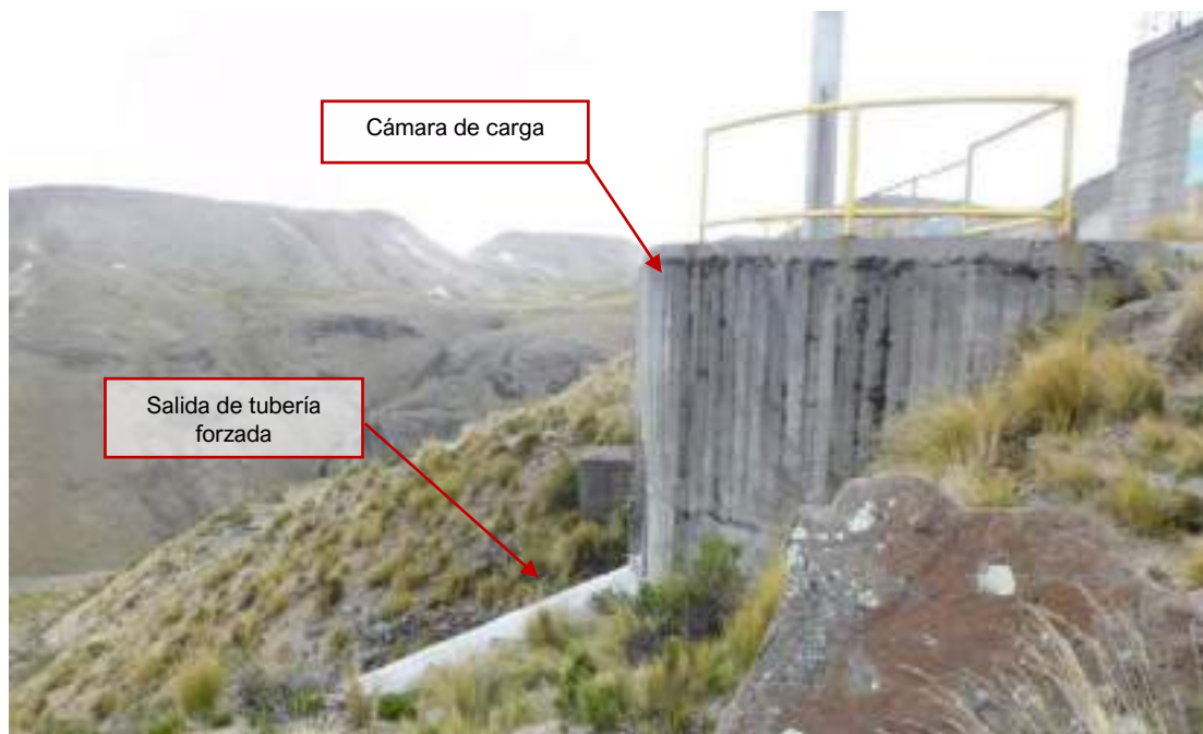
Fotografía 3.3-9 Tubería forzada - Salida de cámara de carga
