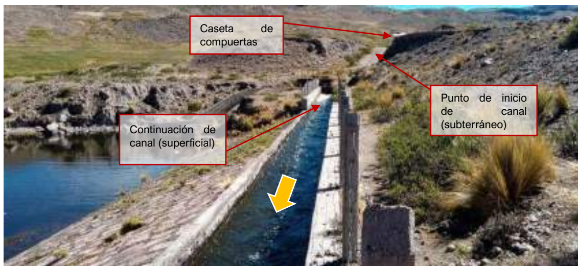
Fotografía 3.3-1 Punto de inicio de componente (Presa Arcata)
