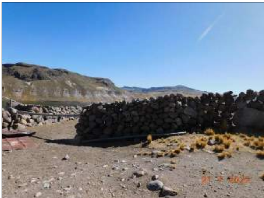
Fotografía 31: Infraestructura de la estancia Machacoyo. Corral con cerco de piedra.
