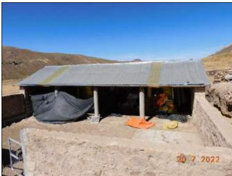
Fotografía 24: Infraestructura de la estancia Llojeta. Cobertizo con paredes de piedra y techo de calamina.
