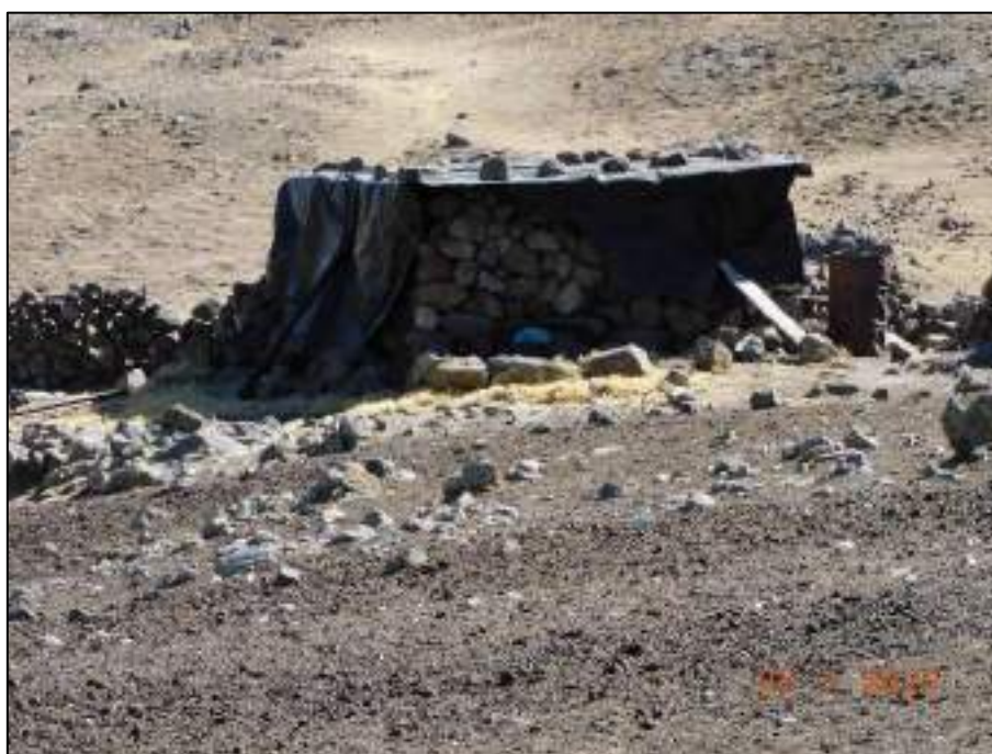
Fotografía 44: Infraestructura en la estancia Huisca Huisca. Vivienda con paredes de piedra, techo de calamina y envuelta en plástico.
