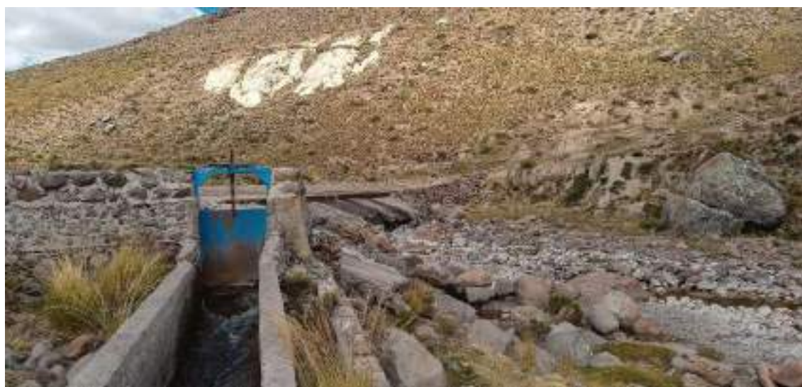
Fotografía 3.3-27 Toma Udjo 2/Toma 4: Aporte km 6+620
