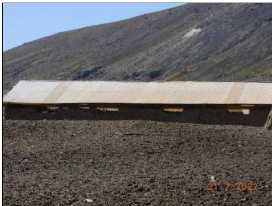
Fotografía 34: Infraestructura de la estancia Ovejería. Cobertizo con paredes de piedra y techo de calamina.
