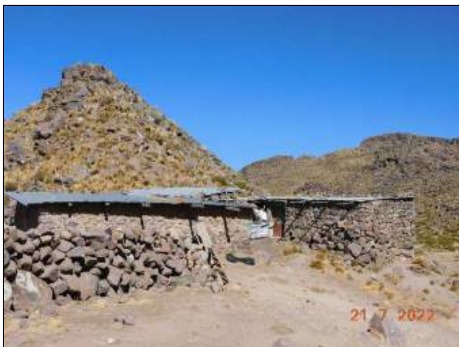
Fotografía 41: Infraestructura en la estancia Sonjochocho. Viviendas con paredes de piedra y techo de calamina.
