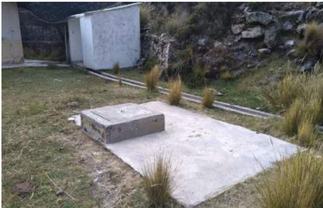
Fotografía 3.3-19 Vista actual del Pozo séptico
