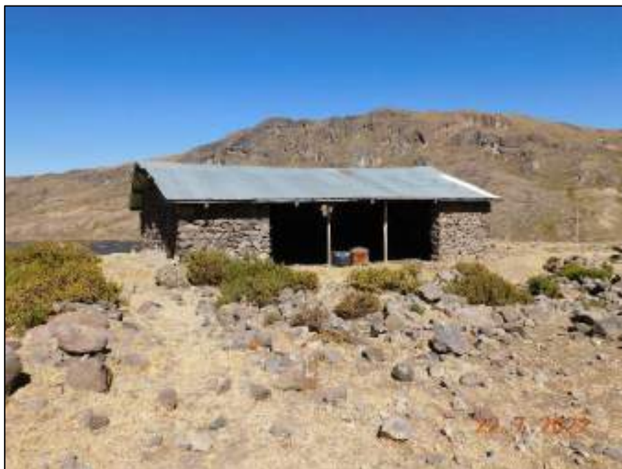
Fotografía 45: Infraestructura en la estancia Huisca Huisca. Cobertizo con paredes de piedra y techo de calamina.
