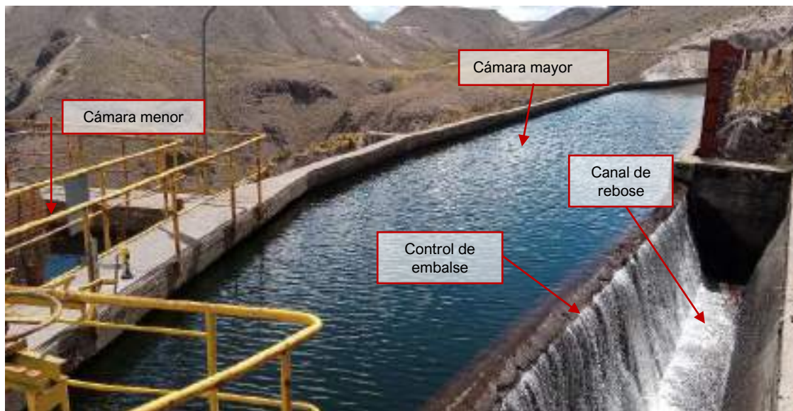
Fotografía 3.3-5 Componentes de la Cámara de carga
