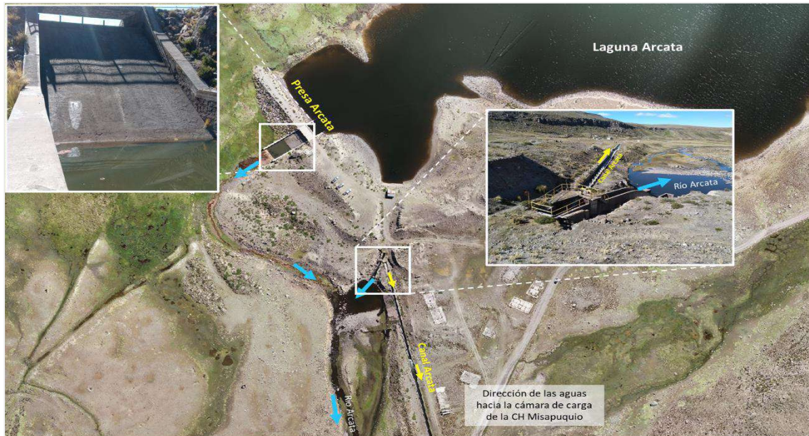
Figura 5-2 Conducción de las aguas de la laguna Arcata por medio de un canal a la CH Misapuquio
