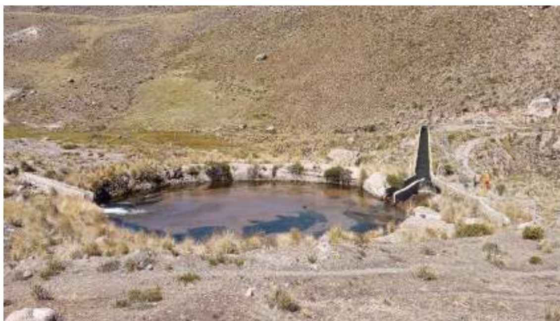
Fotografía 3.3-26 Vista actual de la Toma Udjo /Toma 3: Aporte Udjo
