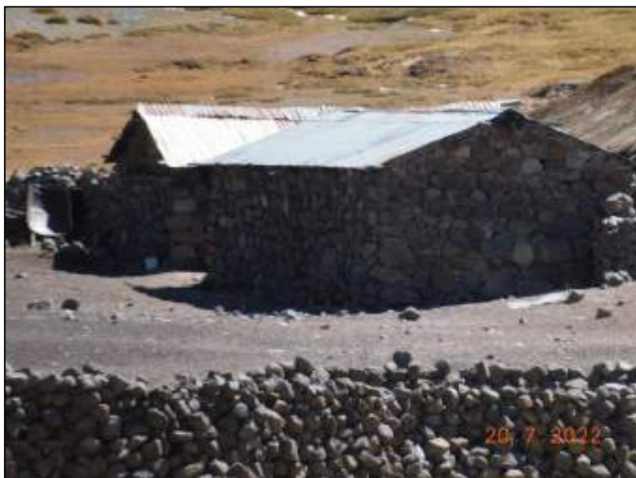
Fotografía 28: Infraestructura de la estancia Cochasique. Viviendas con paredes de piedra y techo de calamina.
