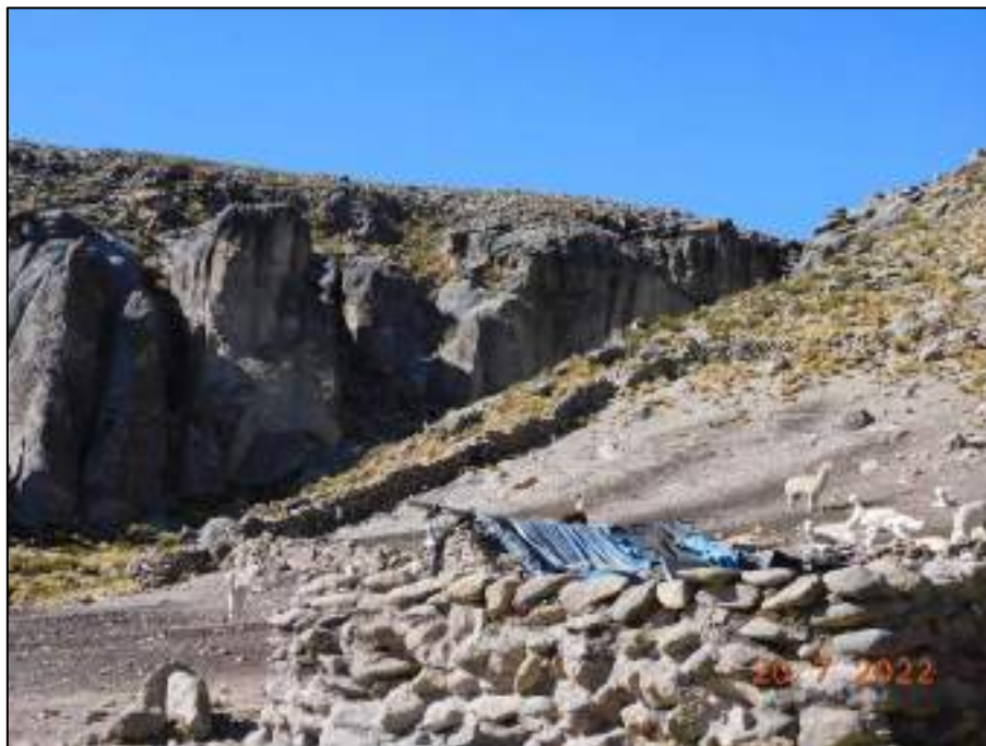
Fotografía 15: Infraestructura de la estancia Calachani. Vivienda con pared de piedra y techo de plástico, y corral con cerco de piedra.
