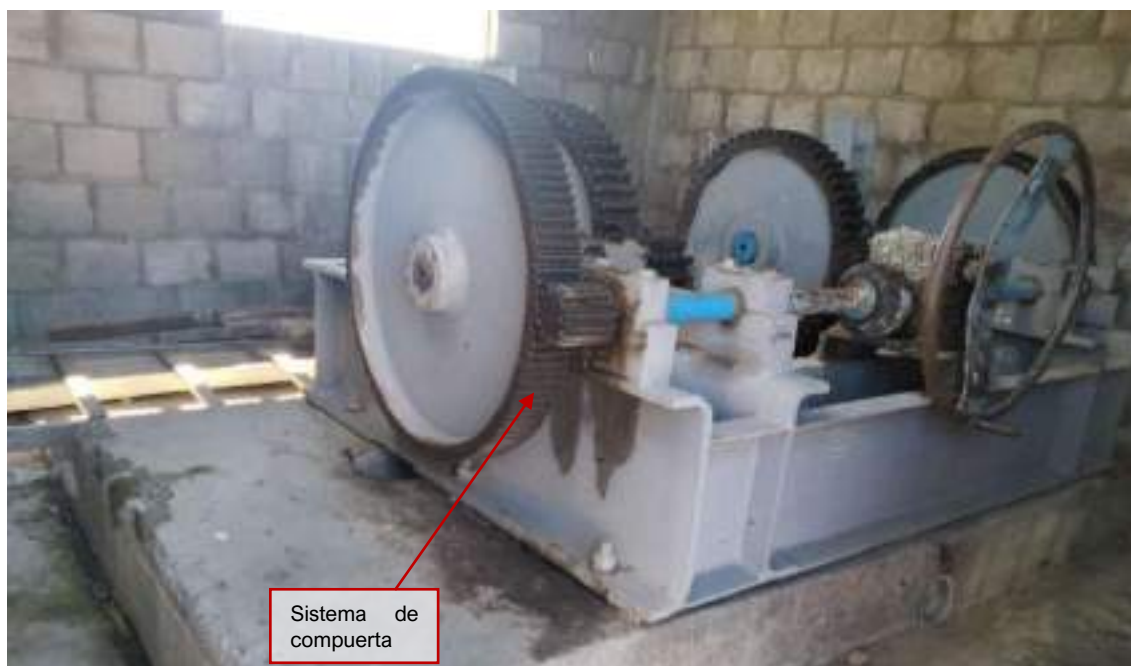
Fotografía 3.3-14 Interior de la caseta de compuerta de la presa Arcata
