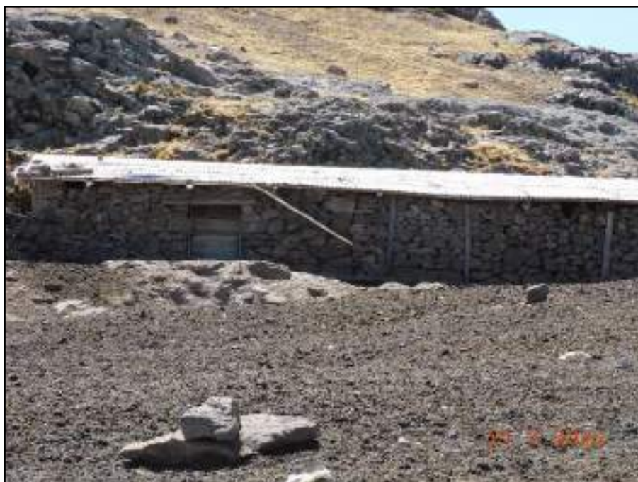
Fotografía 36: Infraestructura de la estancia Ovejera. Vivienda con paredes de piedra y techo de calamina.
