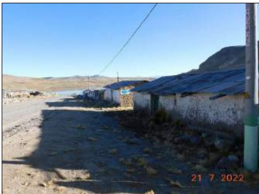
Fotografía 37: Infraestructura de la ampliación Cruz Pata. Viviendas con paredes de adobe y techos de calamina.
