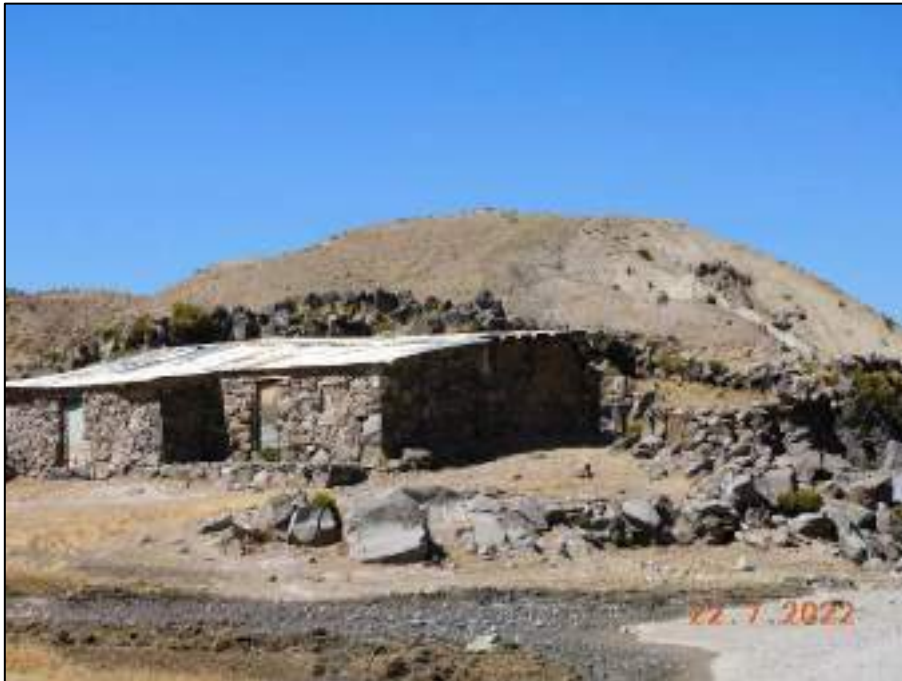
Fotografía 47: Infraestructura en la Estancia Yanananra. Vivienda con paredes de piedra y techo de calamina.
