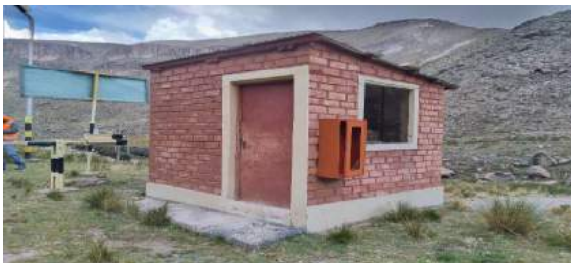
Fotografía 3.3-11 Caseta de control / vigilancia
