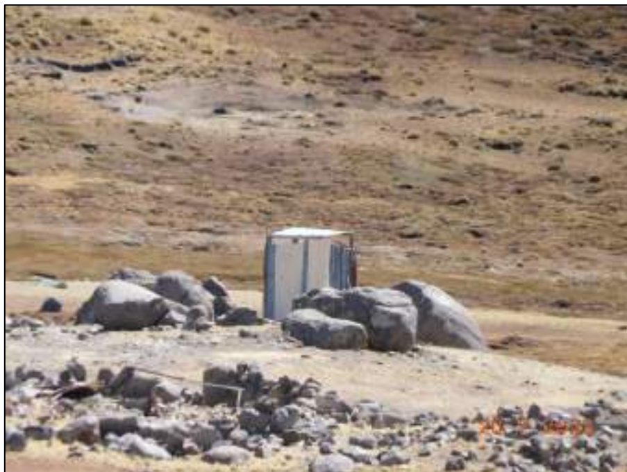
Fotografía 29: Infraestructura de la estancia Cochasiq. Letrina con paredes y techo de calamina
