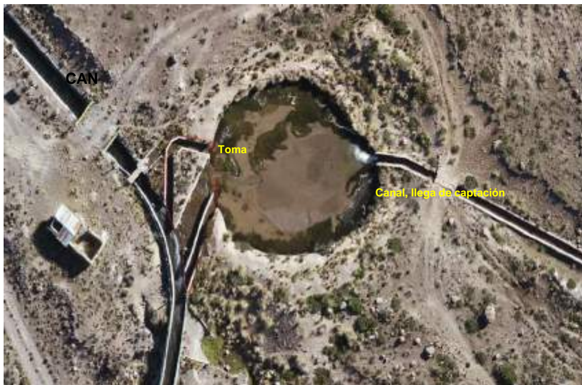
Fotografía 3.3-25 Vista en planta Toma Udjo /Toma 3: Aporte Udjo
