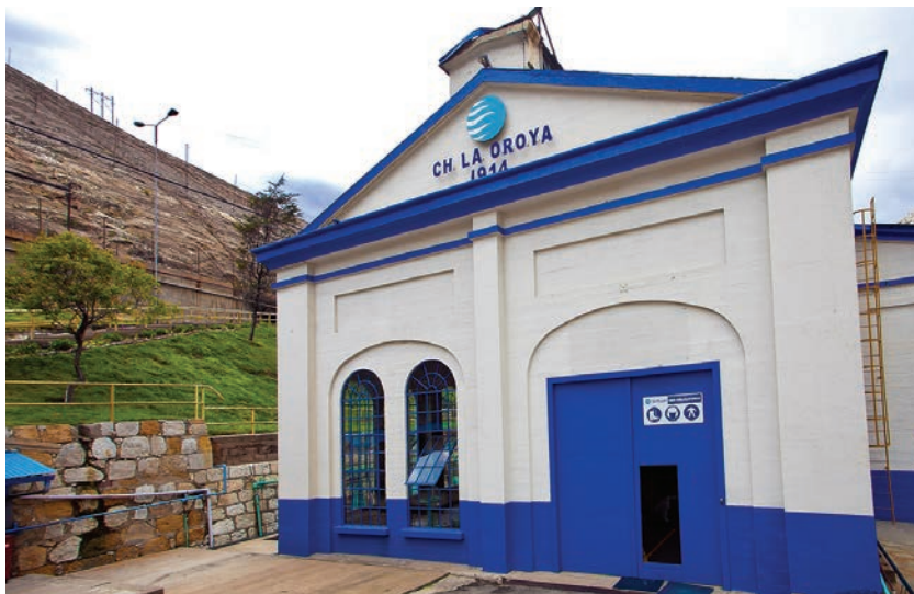
Central hidroeléctrica La Oroya, operada por Statkraft Perú.
