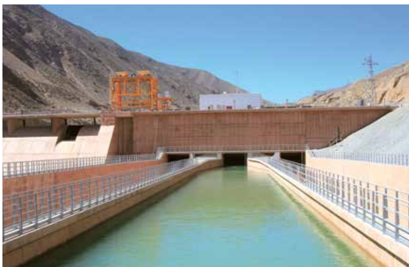
Central Hidroeléctrica Cheves, operada por Statkraft Perú
