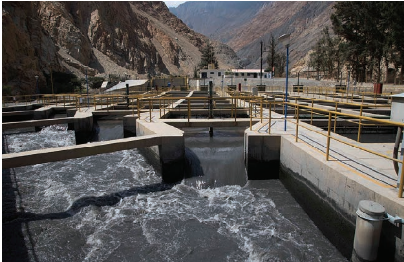
Central hidroeléctrica Cahua, operada por Statkraft Perú.
