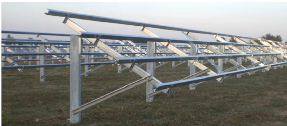
Figura 2.5-2 Figura referencial de la estructura de soporte
